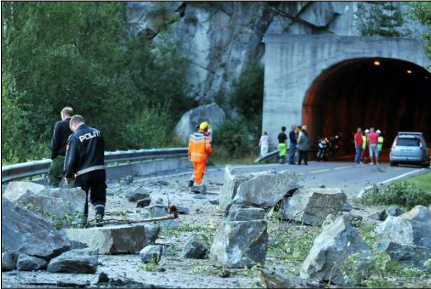
Figur 4: Skredet 24.08.2008 gjorde stor skade. Heldigvis gikk ingen liv tapt (foto: Tidens Krav).
