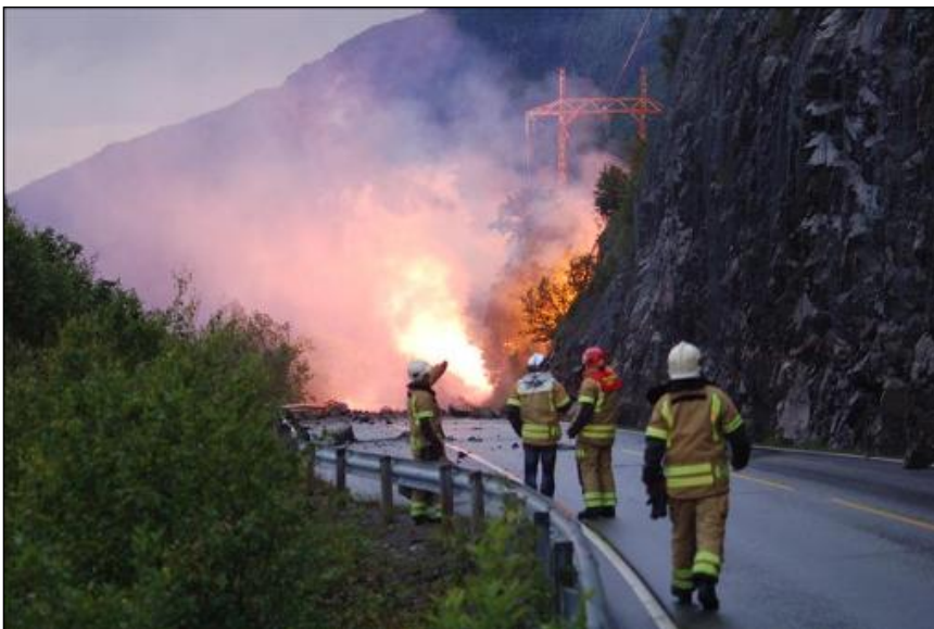
Figur 5: Steinskredet 16. juni 2009 gjorde skader på veg, rekkverk og kraftlinje. Høyspentledningen slo ned i skogen og satte fyr på den (foto: Jan Ødegård/Aura Avis).
