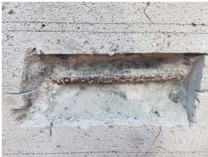
Figur 11 – Frilagt armering for å etablere armeringskontakt, sørside.
