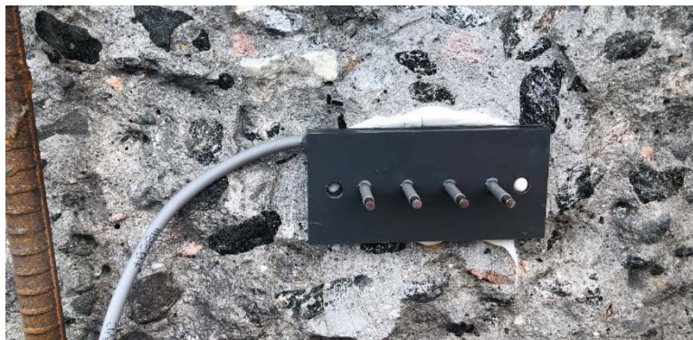
Figur 15 – Wennerelektroden limt på betongoverflaten.
