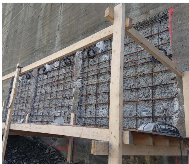
Figur 6 – Meisling bak armering i prøvefeltene på nordsiden.
