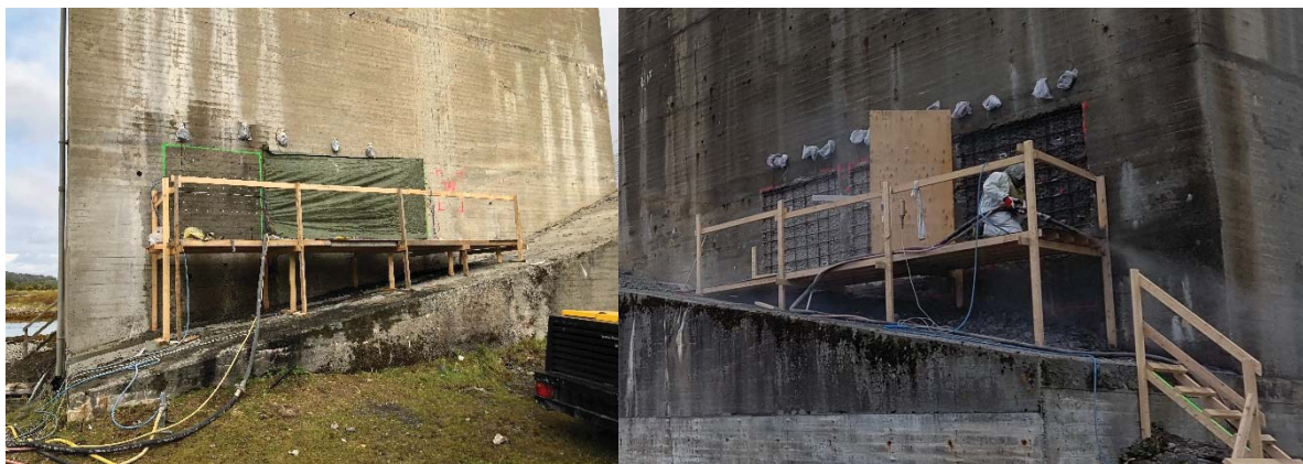
Figur 16 – Sprøyting av mørtlene, venstre – sørside, høyre – nordside.
