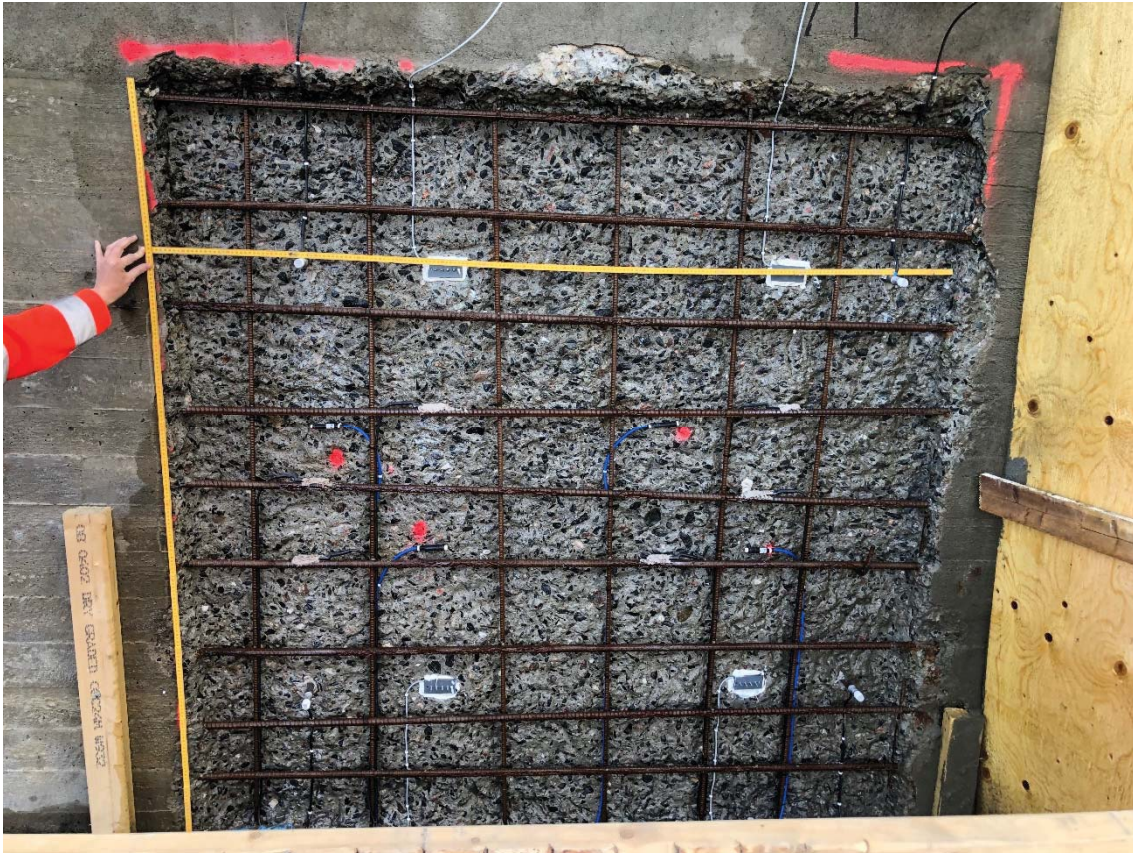
Vedlegg Figur 1 – Nordside Felt A før sprøyting Reparasjons-mørtel.
