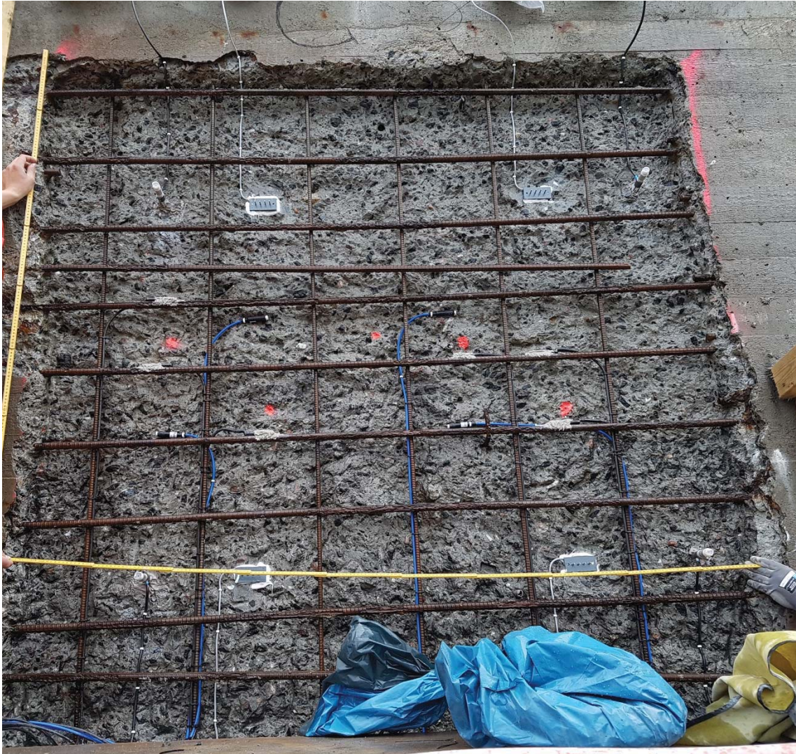
Vedlegg Figur 5 – Nordside Felt C før sprøyting Reb-mørtel.
