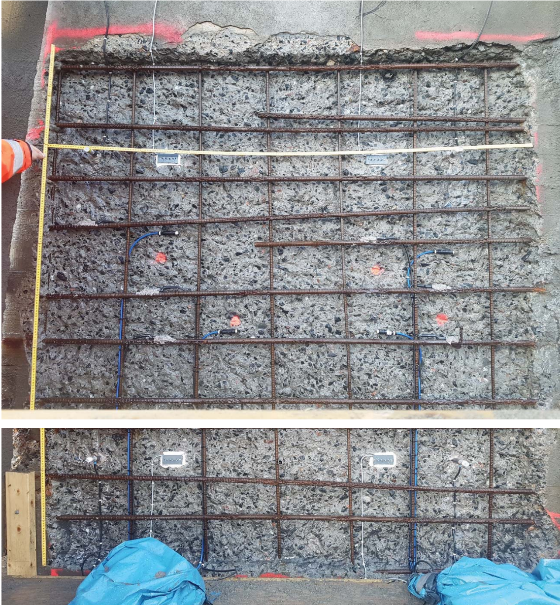
Vedlegg Figur 3 – Nordside Felt B før sprøyting Reparasjons-mørtel.
