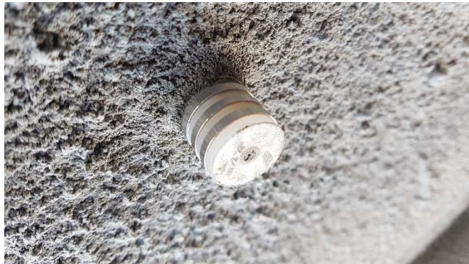
Øvre ringer klargjort for innsprøyting i KB-mørtel
