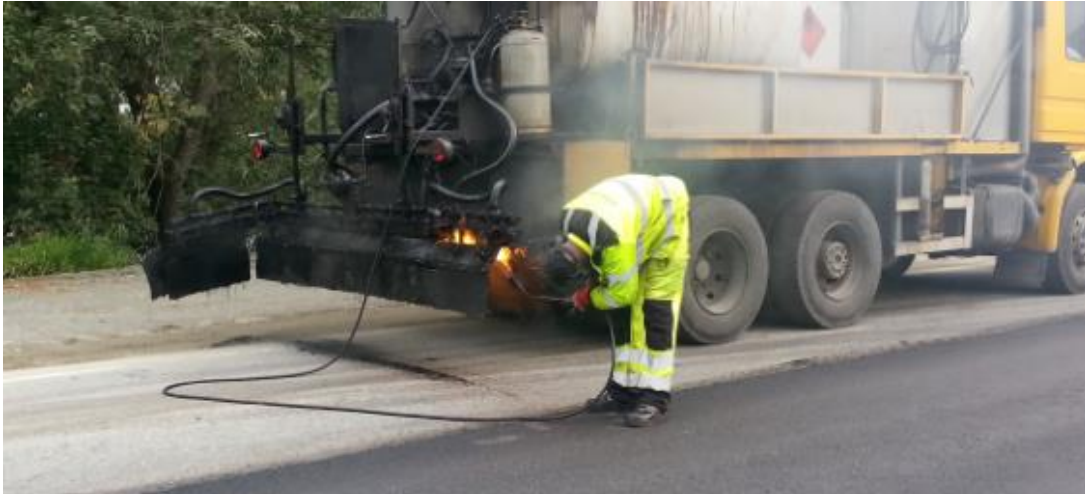
Figur 21 Rensing av dyser med propanbrenner.
