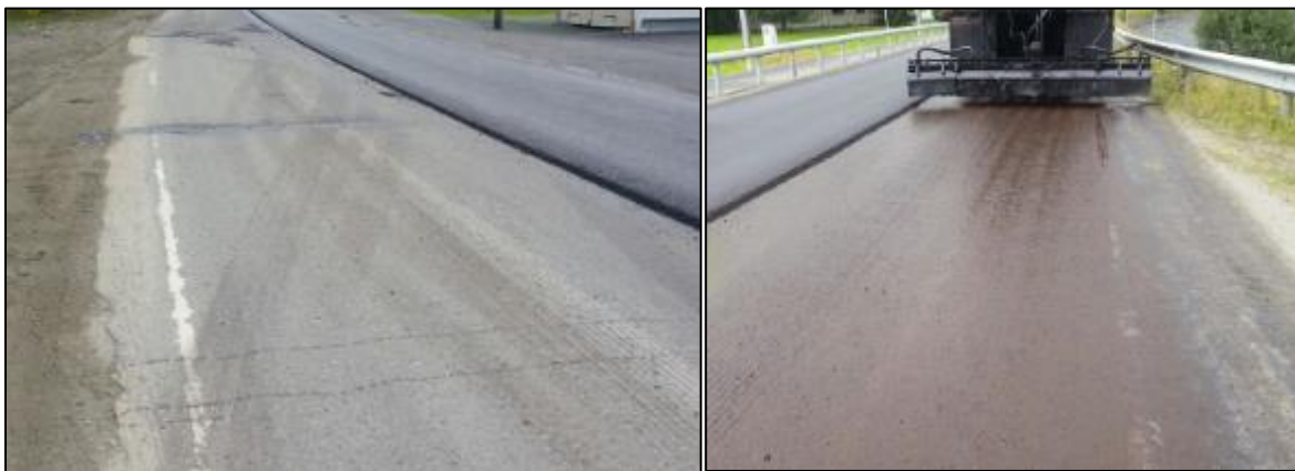
Figur 29 Bilder fra strekning B, rett før og rett etter klebingen er utført.
