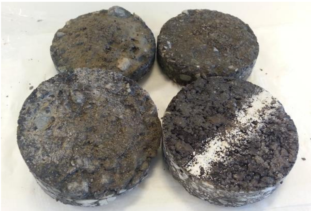
Figur 32 Den første prøven som ble forsøkt boret ut på vegskulderen på strekning B kom ut i 4 biter/lag.
