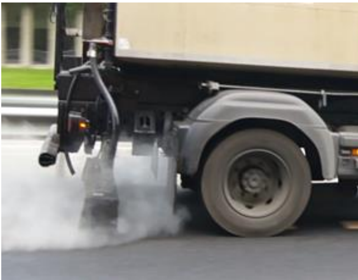
Figur 17 Denne sprøytebilen evner å finfordele emulsjonen særdeles godt. Dette sikrer en jevn fordeling av klebemiddelet på underlaget, samtidig som en god del av vannet fordamper allerede før emulsjonen treffer bakken.
