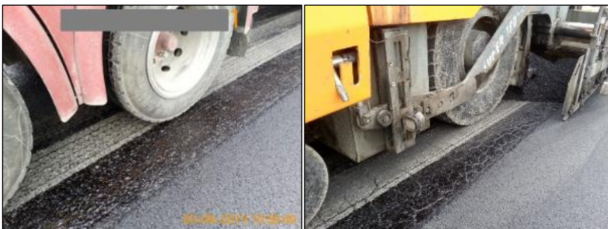
Figur 30 Bildene viser hvordan emulsjonen festet seg til dekkene og det gamle underlaget ble helt blottlagt i hjulsporene.
