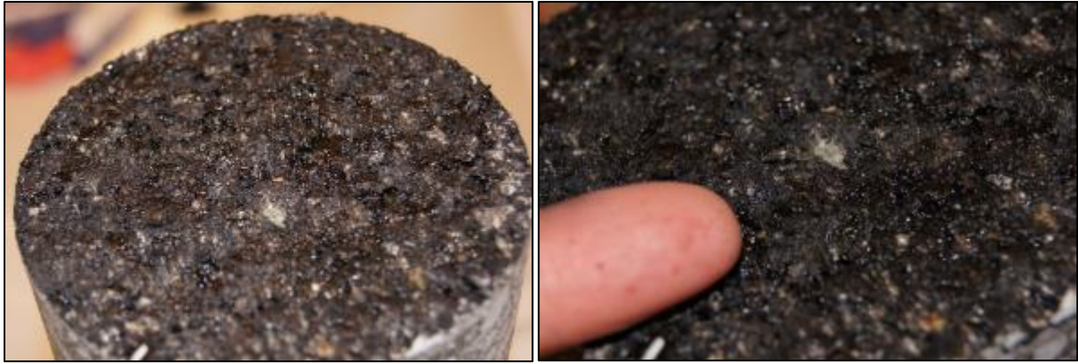
Figur 35 Bildene viser hvordan bruddflatene på borkjernene tatt ut på strekning G så ut etter testing av bindingsstyrke. Bildene viser at det er forekommer noe vann på overflaten, selv etter lagring i en måned i romtemperatur fra prøveuttak til testing.
