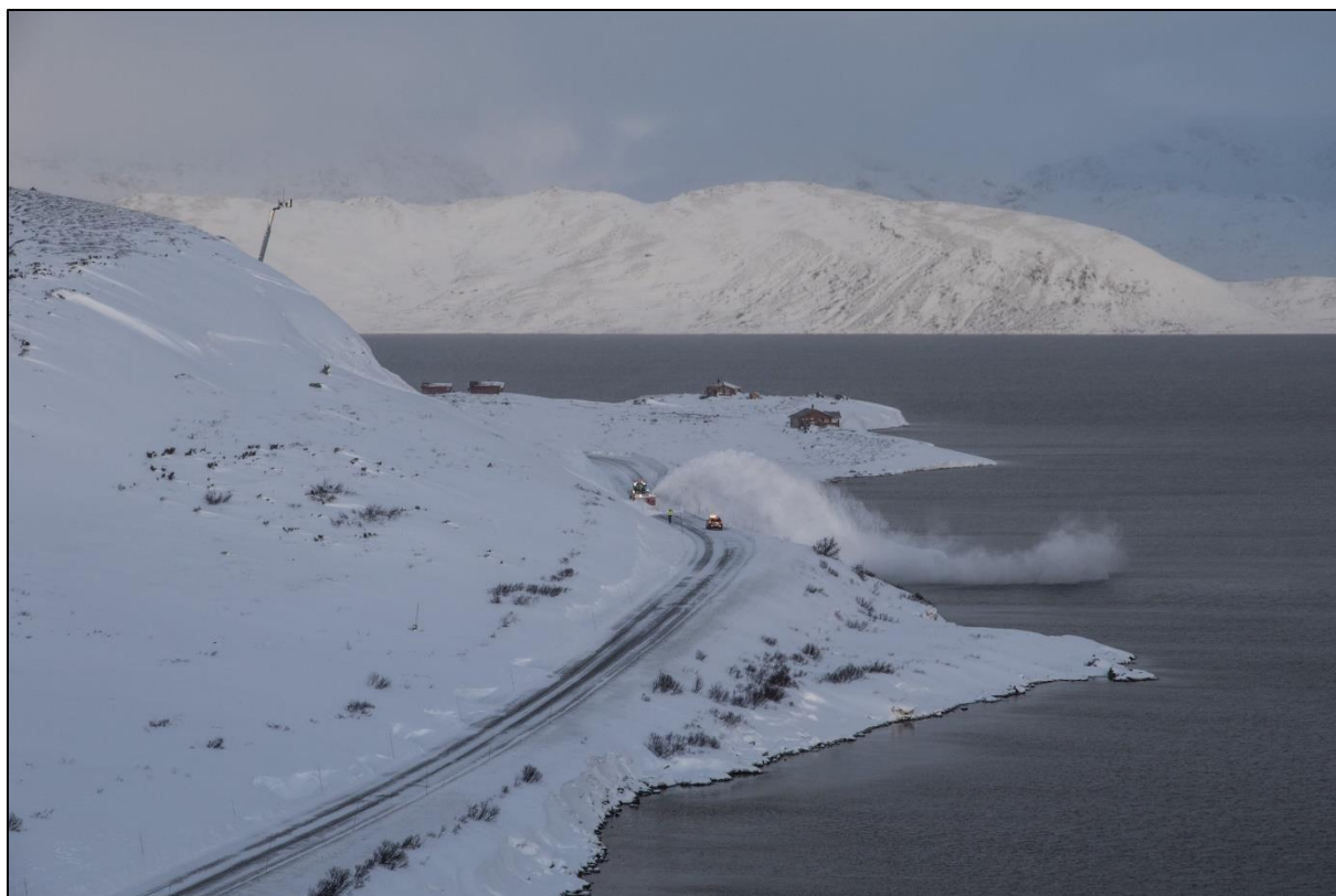
Figur 2: Nettverket av 14 snøskredtårn ved Tyin sto klare til bruk i desember 2016. Bildet viser skred i vegen løst ut ved skredpunktet Gamle Varden 02.12.2016. Dette var den første ladningen som ble detonert etter ferdigstillelse av prosjektet. Foto: Ragnar Ekker, NVE.
