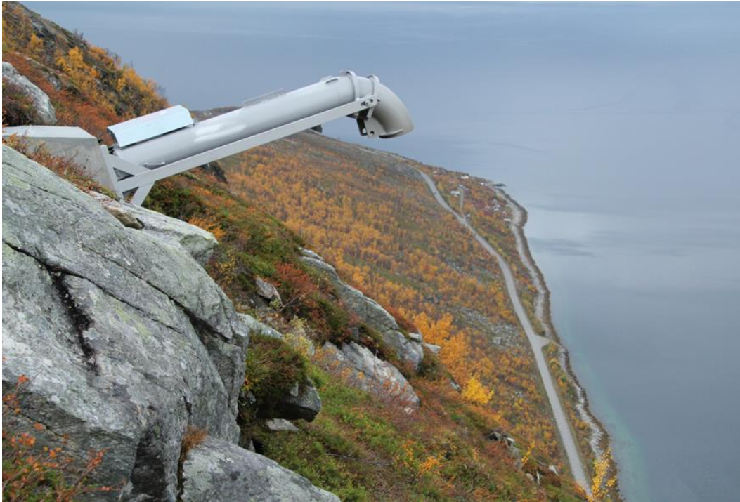
Figur 4: Gasskanon av typen Gazex ved Fv. 883 i Skillefjorden (Foto: Ole-André Helgaas, Statens vegvesen).
