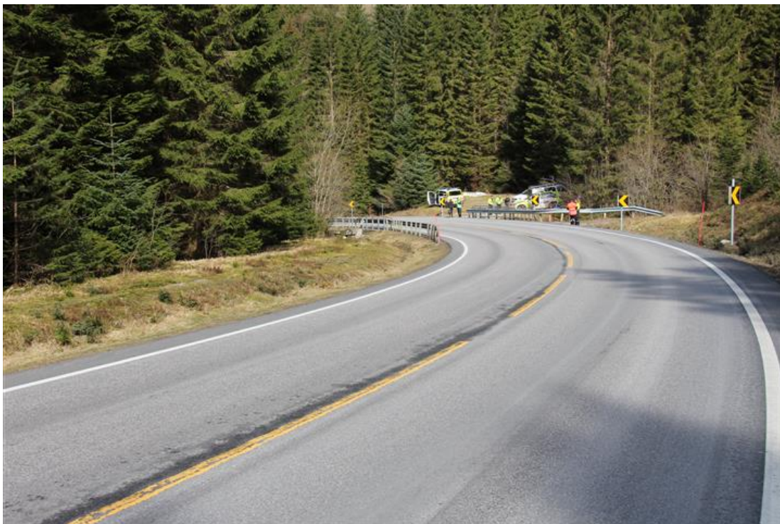
Figur 22 Bildet viser kurve der framoversikt er redusert av vegetasjon. Denne kurven avviker fra kurver i begge retninger med radius på 125 meter. Vegetasjon langs vegen hindrer også at sol kom til og fjerne fukt på vegen. Denne kurven er den kurven på denne strekningen som gir flest bilberginger på strekningen.
