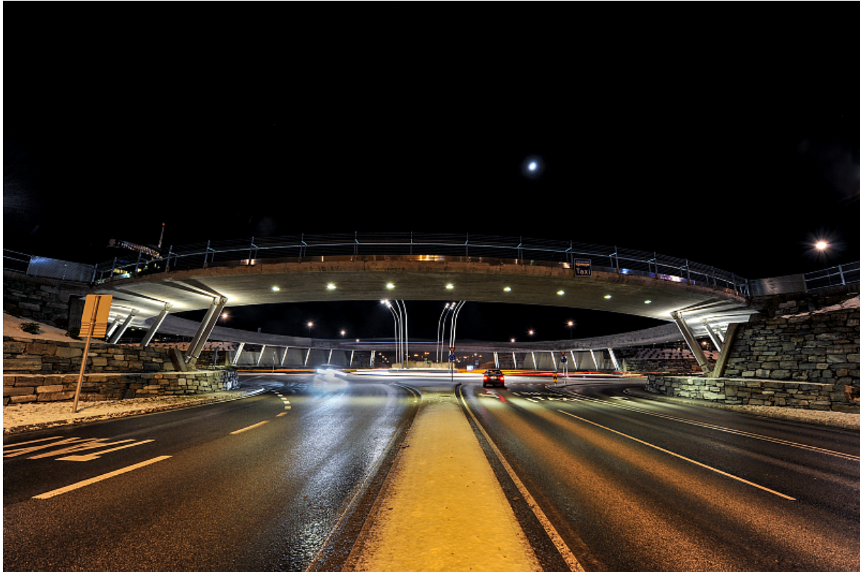
Figur 4 Bilde av planfri kryssing for fotgjengere og syklister over vegbanen for biler.
