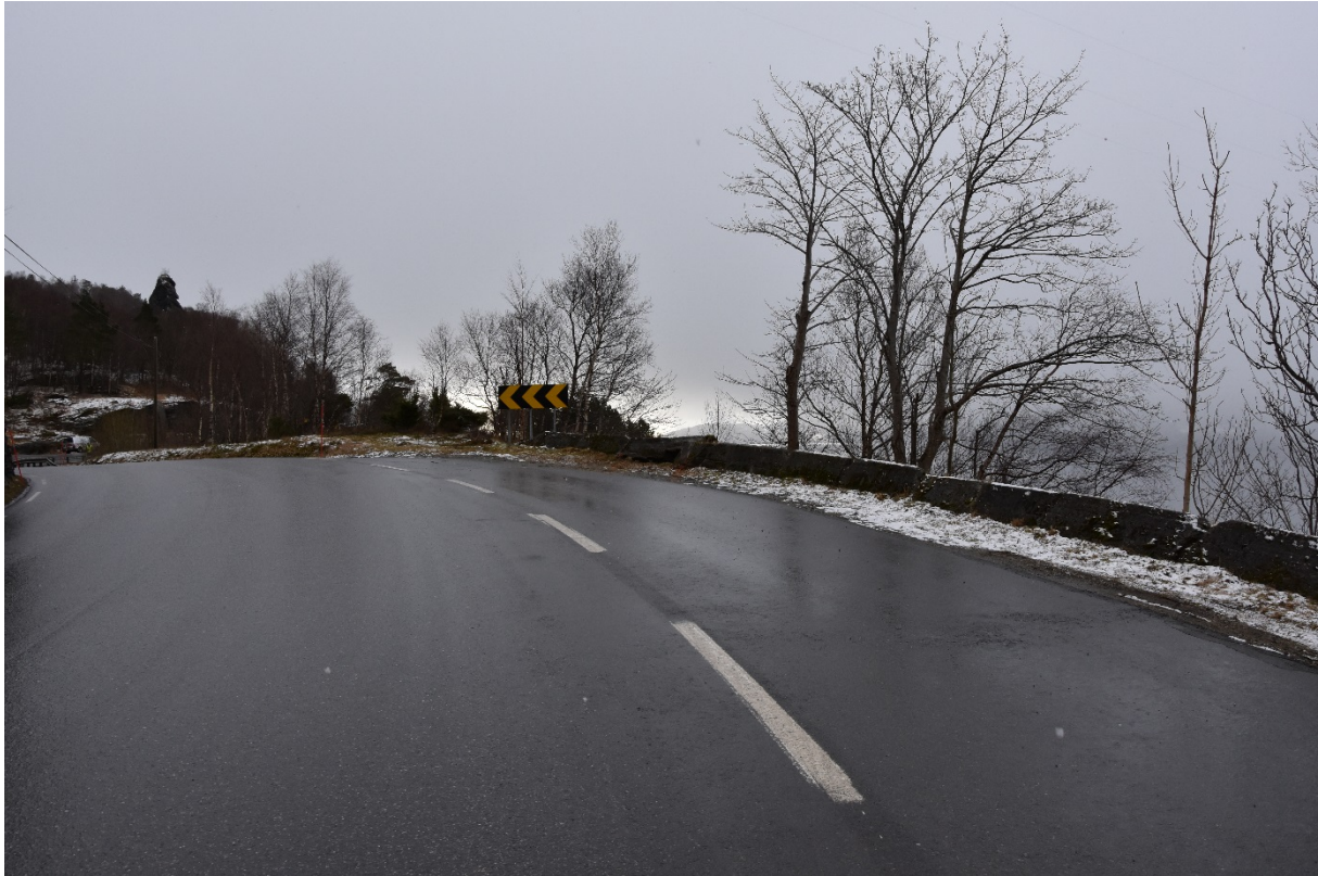
Figur 21 Bildet viser uheldig løsning. Vurdere kant-oppmerking ved møteplasser/lommer på grunn av fare for vill-ledning..
