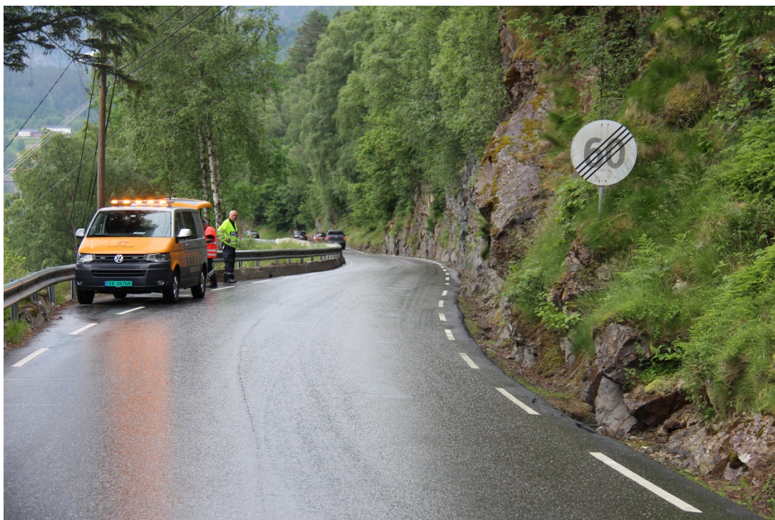
Figur 20 Bilde fra mc ulykke som skjer på veg der framoversikt er begrenset, og standardsprang (vegbrekke)
