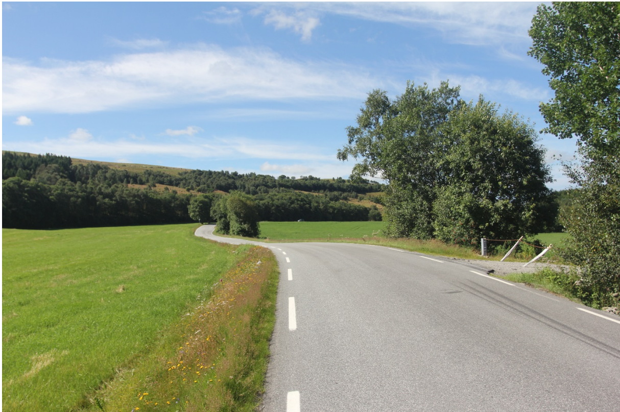
Figur 19 Bildet vis trær i ytterkurver, disse trærne må en søke å fjerne.
