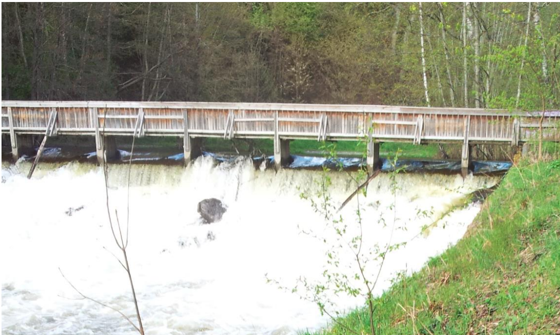
Figur 3 Eksempel på et enkelt vassdragsanlegg, en terskel, som også utnyttes som brufundament. Foto NGI.
