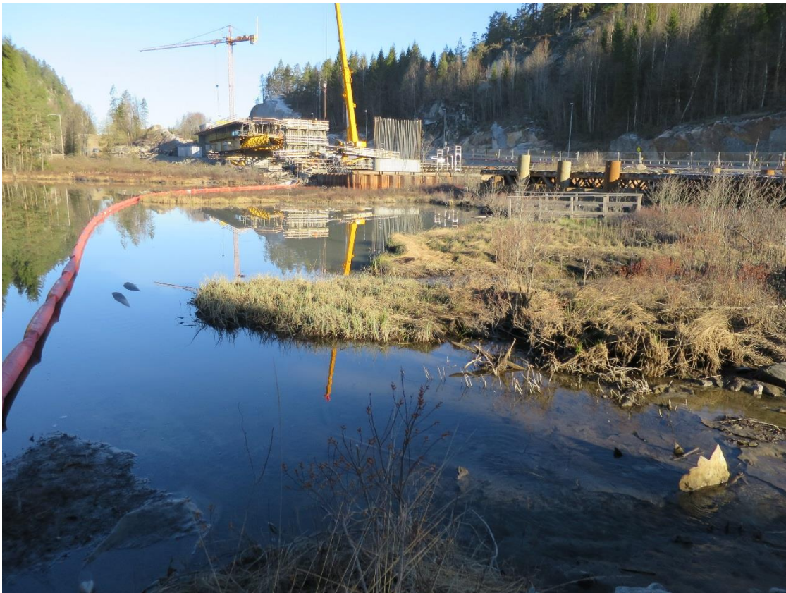
Figur 8 Siltgardin langs byggesonen når anlegget går langs et tjern. Foto NGI
