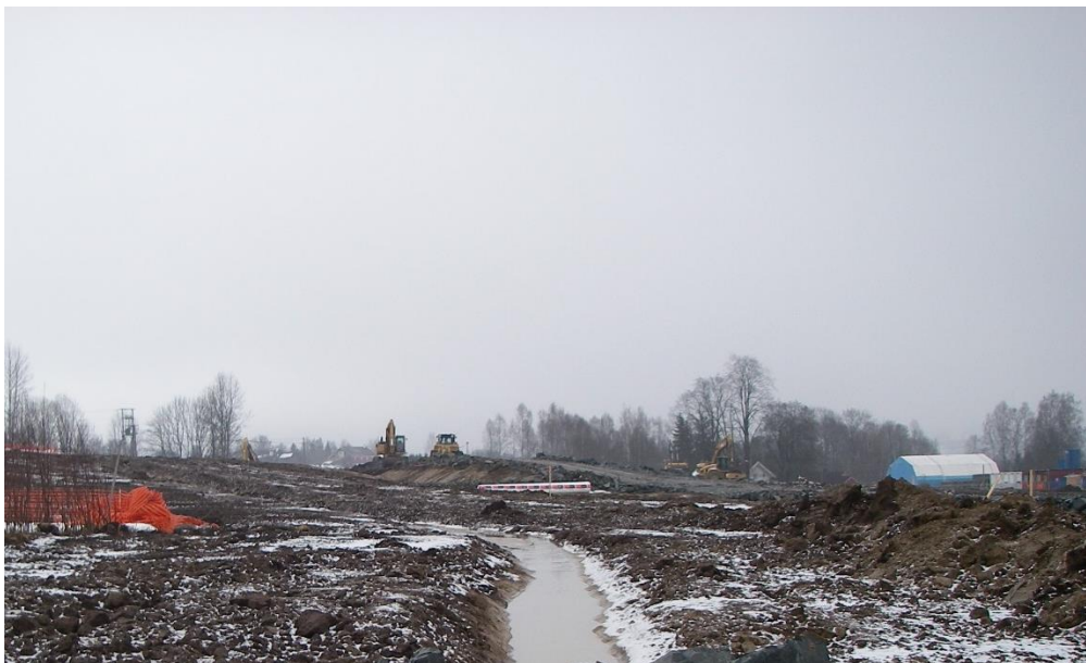
Figur 7 Avskjærende terrenggrøft før uttak av skjæring. Foto NGI
