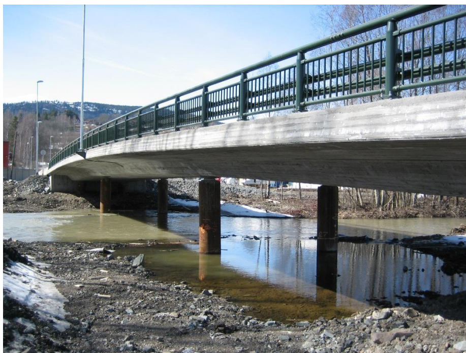
Figur 6 Midlertidig inngrep ved brubygging, før reparasjonsarbeider er startet. Foto NGI
