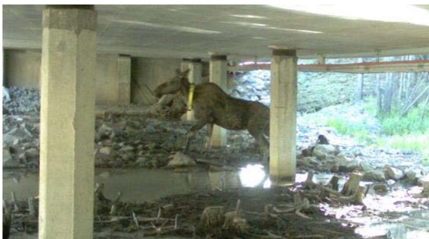
Figur 11: Kryssende GPS-merket elg under lav vegbru under E6 i Eidsvoll. Bilde tatt med viltkamera
