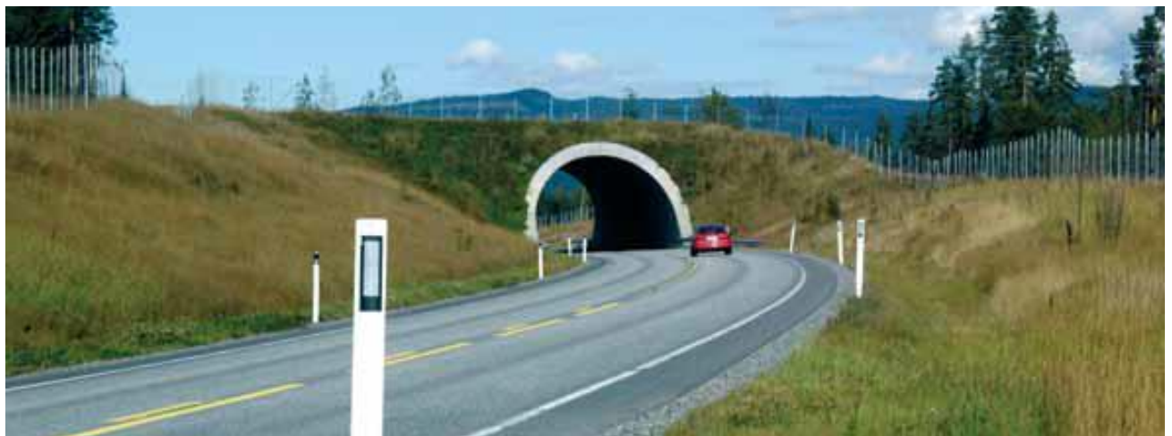
Viltgjerdar som leder dyra mot en faunaovergang på Riksveg 35, Preståsen, Nannestad (Foto: B. Iuell).
