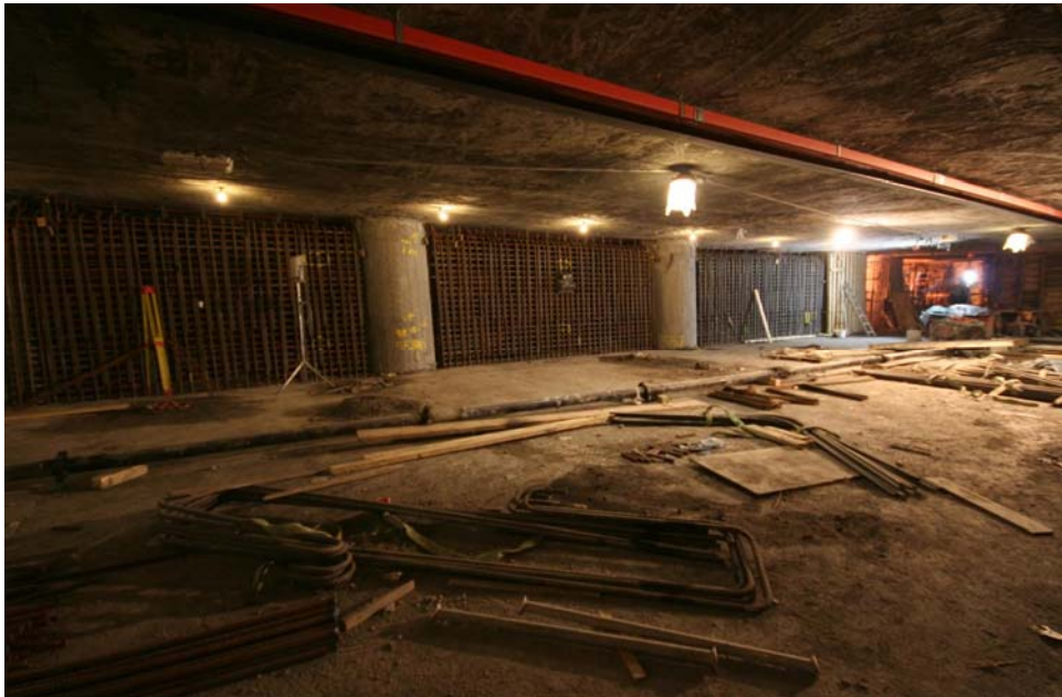
2008-04-25 Armering av midtveggen mellom hovedløpene. Trafikken går over hodet.
