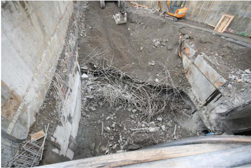
2009 10 21 Det er støpt ferdig ny bunnplate og vegger, og vi åpner opp ved å pigge eksisterende bunnplate.
