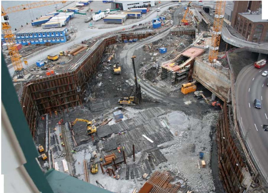
16.3.2007: Stokkmatter er kjøreunderlaget for peleriggen. H-peler i stål står opp ferdig rammet midt i gropa
