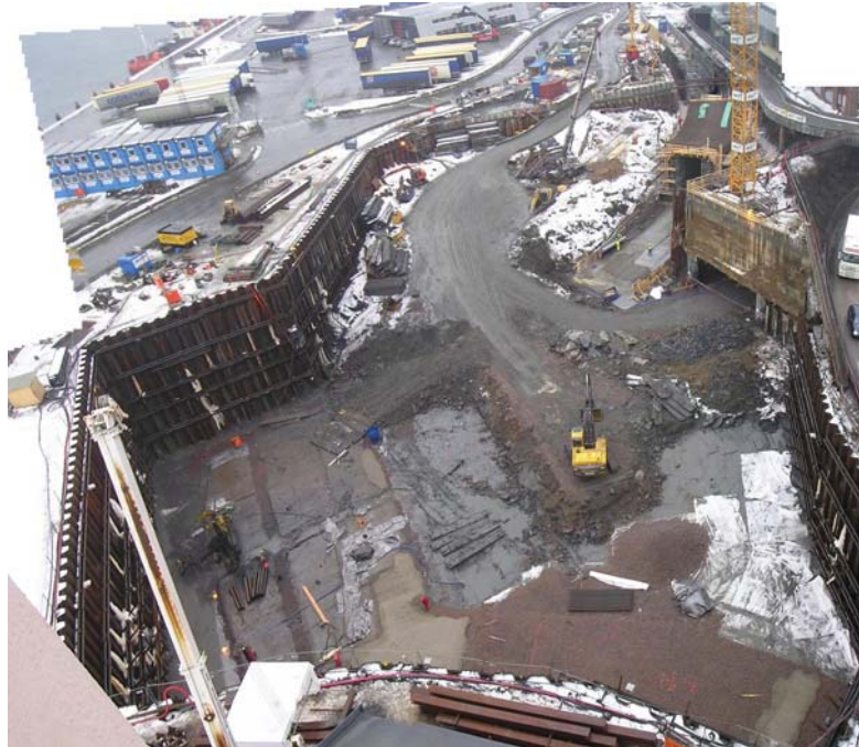
16.2.2016: Det er gravd ned til 5. stegrad, og det er 17 m. dypt.
