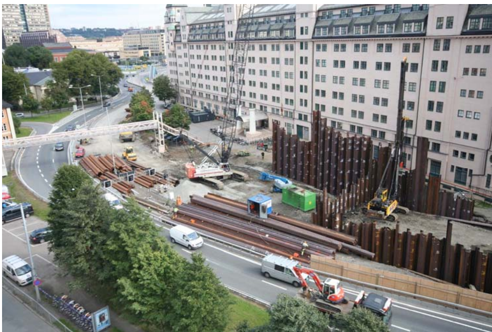
2010 09 08: Start på byggegrøp 3
