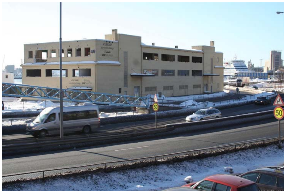
2.3.2010–Fremdeles er det lite å se av rivingen på siden mot E18.
