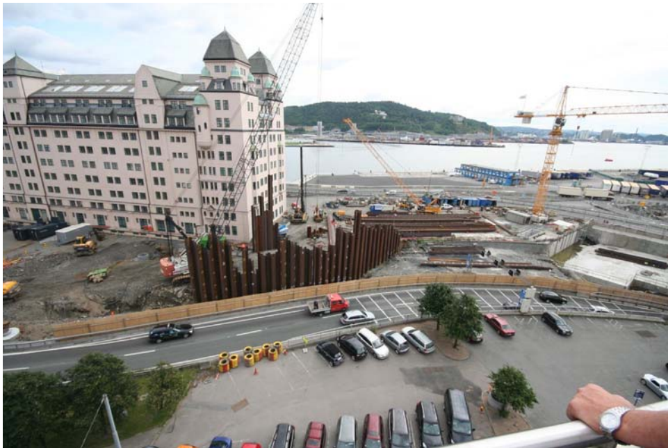
2010 08 09: Søndre vegg av byggegrøp 1
