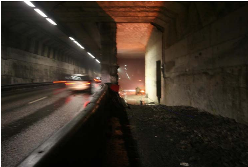
2011 02 25 Trafikken går mens arbeidet pågår. Støynivået er høyt.
