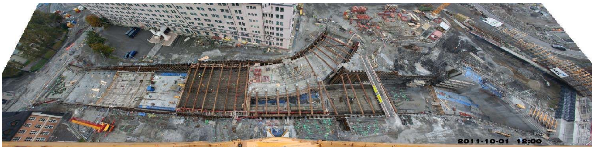
2011 10 01: Tak og vegger armert i første seksjon i byggegrop 3. Snart klar for støp.
