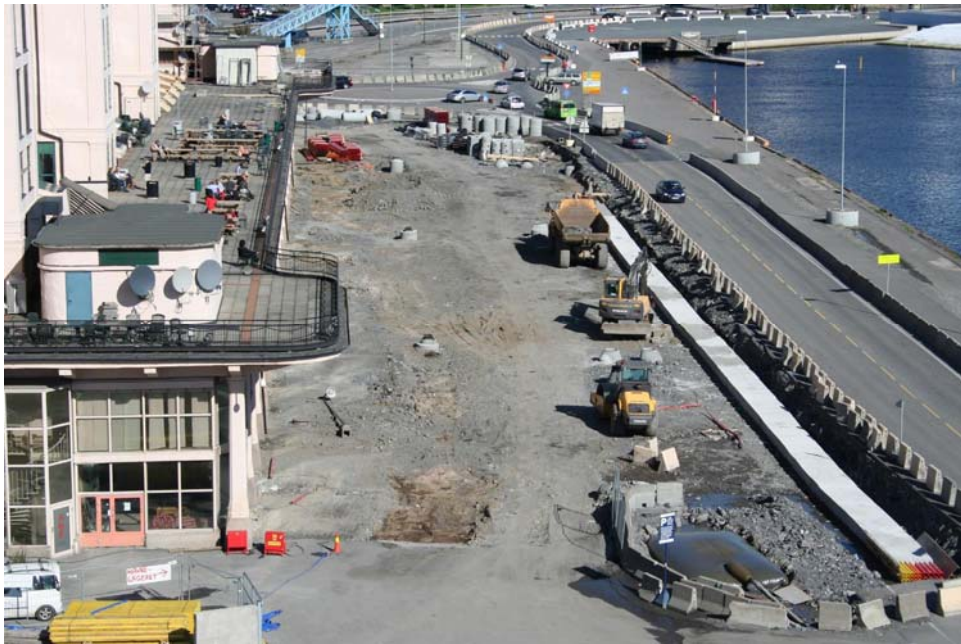
2011 09 16 Gjenfylling rundt kabelkanalen med sand.
