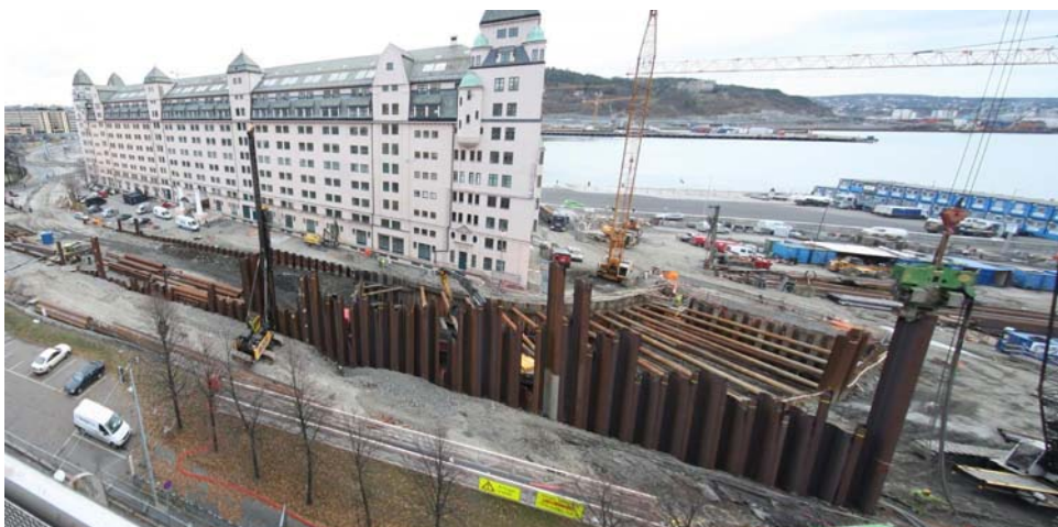
2010 11 10: All trafikk inn i tunnelen. Avstiving med rør i øverste stivernivå i byggegrupp 1.
