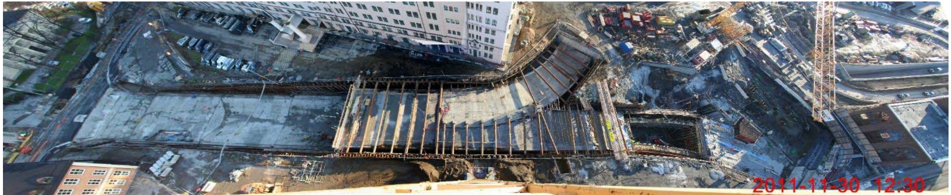
Arbeid på midtre seksjon i byggegrøp 2. Denne ble støpt sist.
