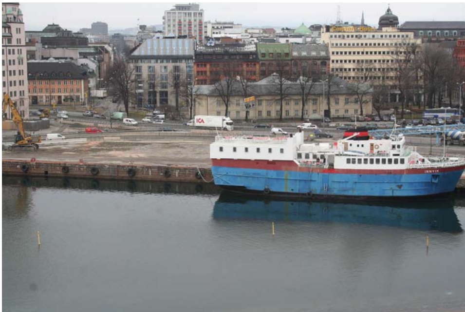
26.3.2010: I løpet av en og en halv måned etter innvendig stripping er ferdig er bygget nede. Området er ryddet, og massene er kjørt bort.
