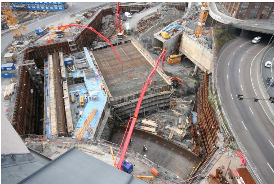
6.9.2007: Støp av tak og vegger i seksjon 2.
