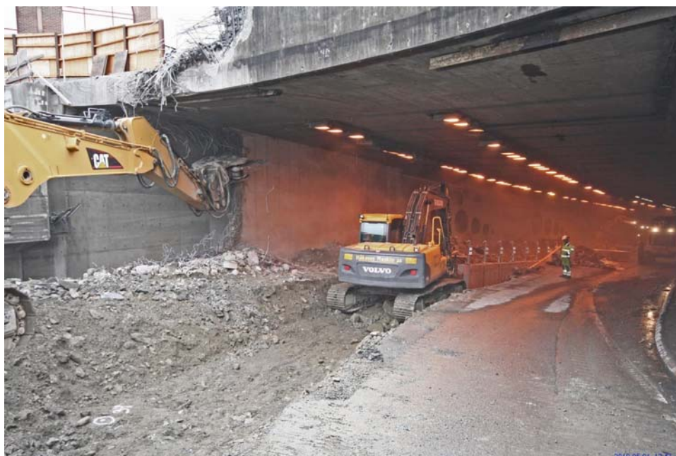
2010 05 02 Oppstart arbeider retning Hamar – Drammen skjer i en helgestengt periode.
