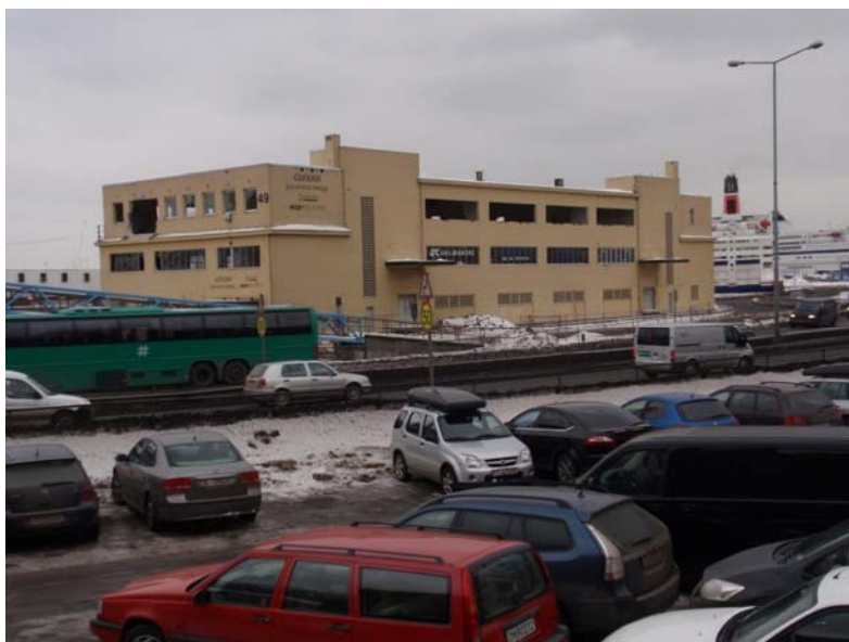
16.02.2010- Bygget er blitt strippet innvendig.
