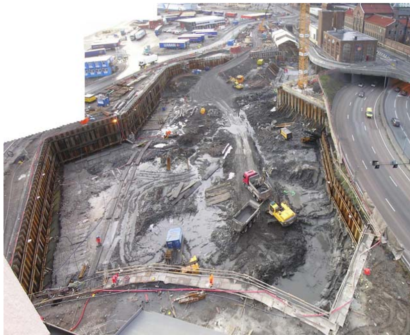
27.11.2006: Injeksjon langs spunten med tax for å få tettere byggegrop.
