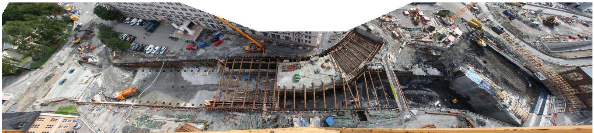
2011 08 30: Montering av peler i byggegrop 2
