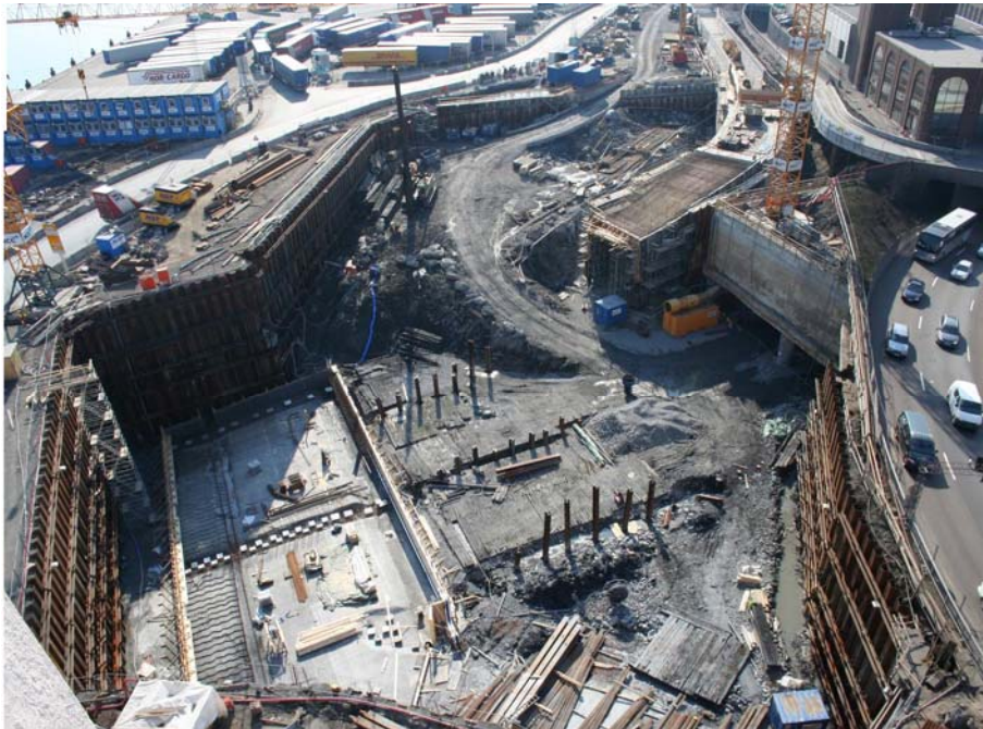
30.3.2007: Tre rader med peler under bunnplaten/veggene til tunnelen. Armering av tak på Danskerampe
