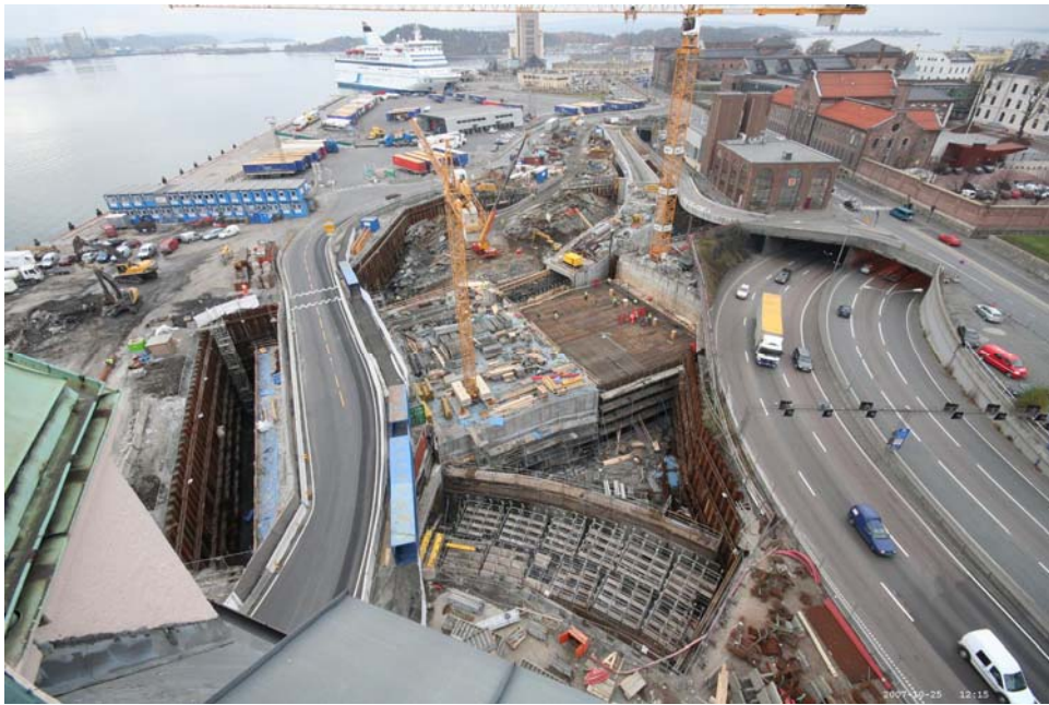
25.10.2007. Armering av seksjon 3. Reisen settes opp i rampe mot Rådhusgata.
