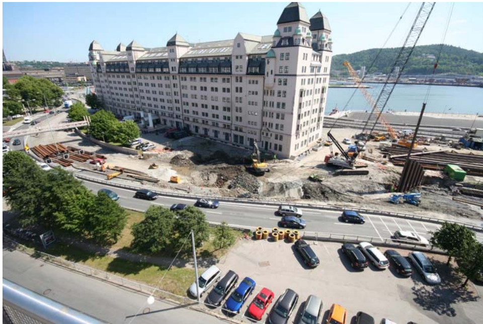
28.6.2010: Oppstart av vibrering av spunt
