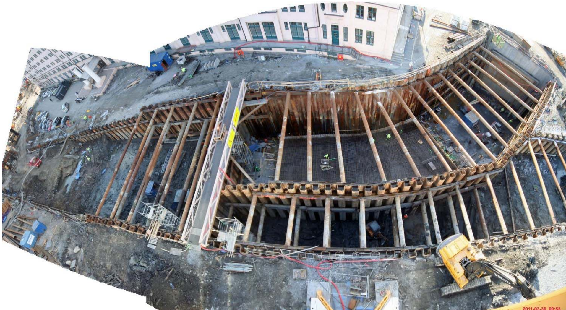
2011 03 30: Bunnplaten erstatter et stiverlag. Utgraving i grop 3 nærmer seg slutten
