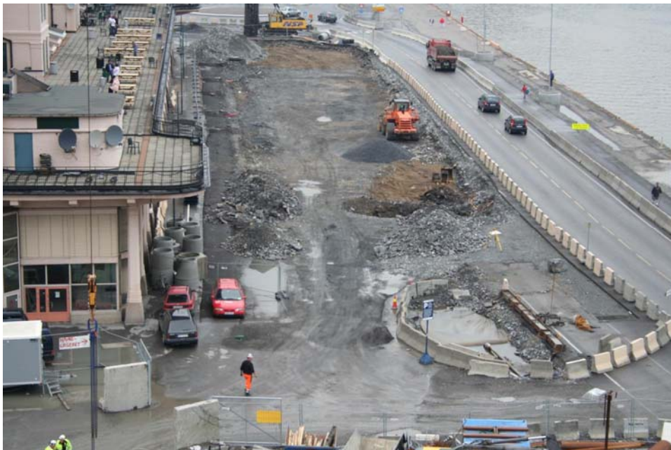
2011 06 07 - Trafikken går langs kaia. Anleggsområde er klargjort foran Langkaia 1 «Havnelageret»
