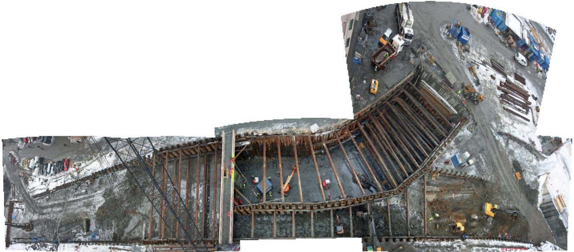
2011 03 10: Graving pågår i byggegrop 2 og 3 samtidig. Ferdig utgravd i byggegrop 1
