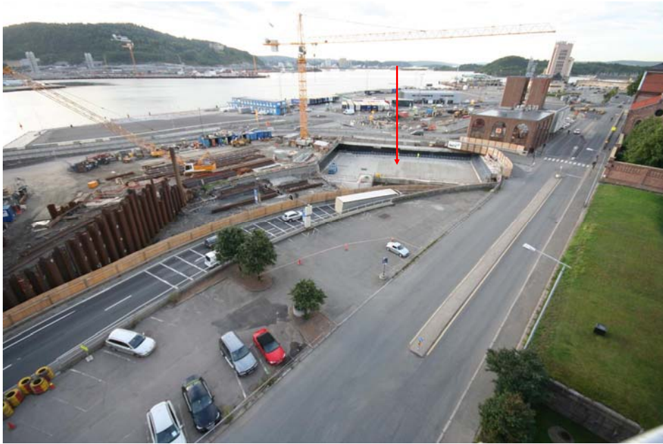
2010 09 01: Toppen av Operatunnelen bygget i fase 1
