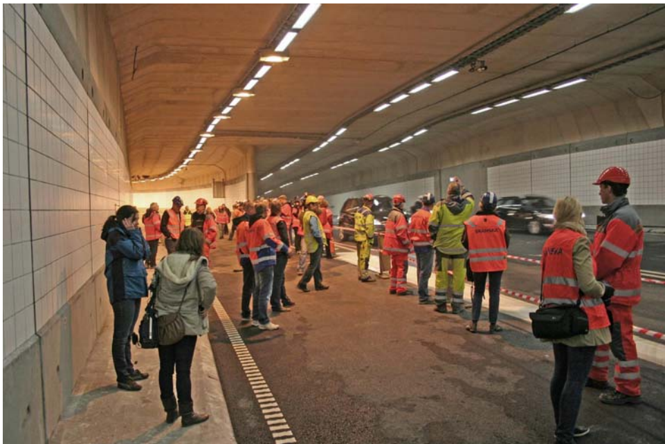
2010 04 26 Åpning av østgående løp i senketunnelen
