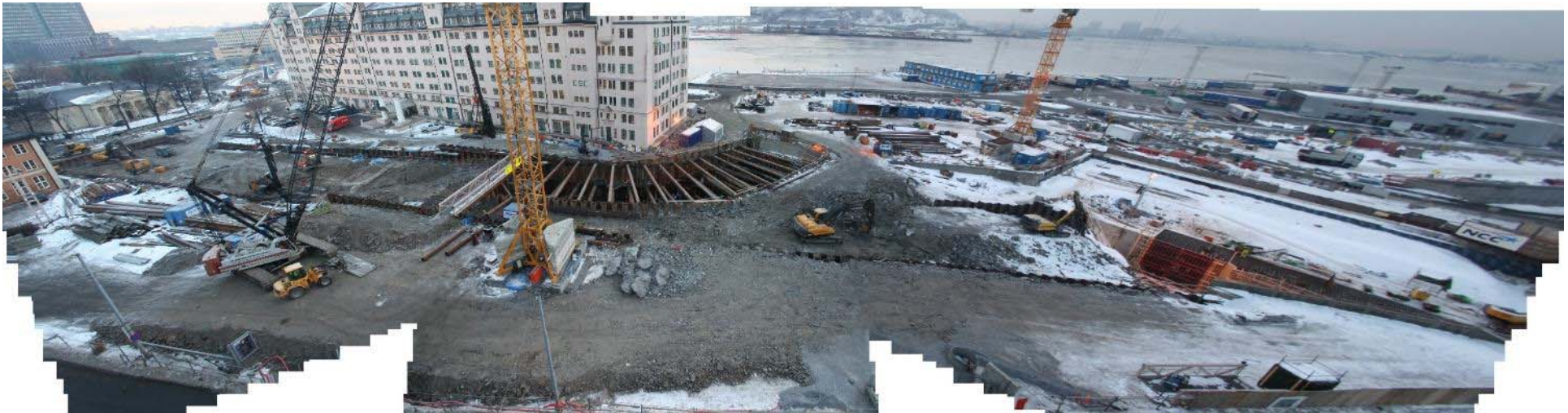
2011 01 28: Utgraving nær hjørnet på Havnelagerbygget
