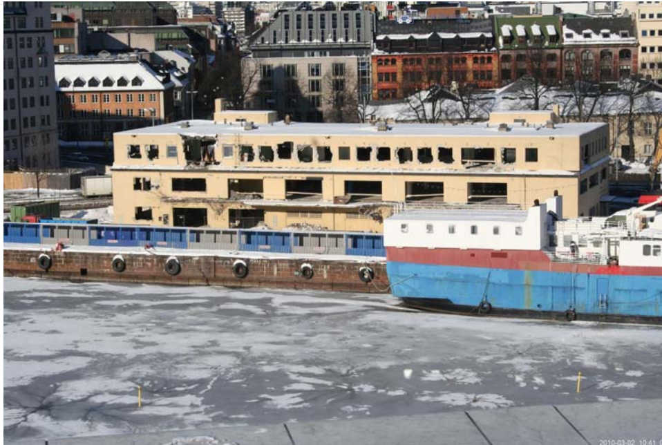
2.3.2010 – Alle vinduer er fjernet. Gående blir skjermet mot nedfall med gangcontainer
