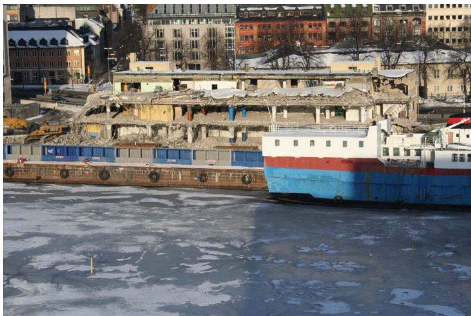
5.3.2010– Det rives fra toppen og nedover, og fra hjørnene og mot senter av bygget
