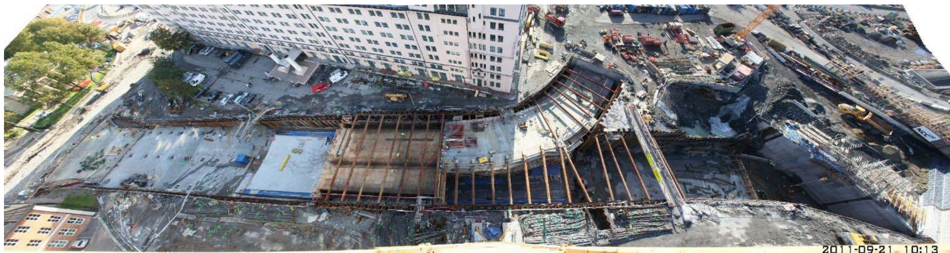
2011 09 21: Forskaling førsteseksjon i byggegrop 3
