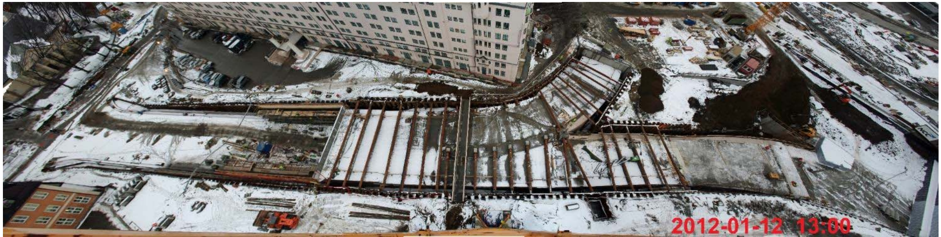
2012 01 12: Forskaling av vegger på begge sider i trau mot nord.
