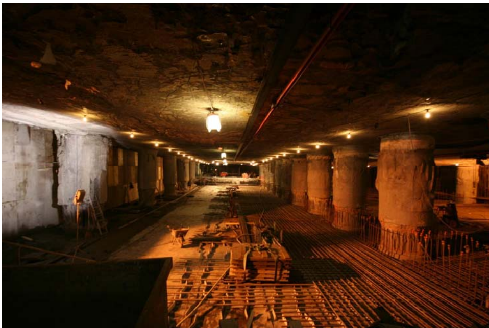
2008 02 05 Armering bunnplate østgående løp Drammen - Hamar
