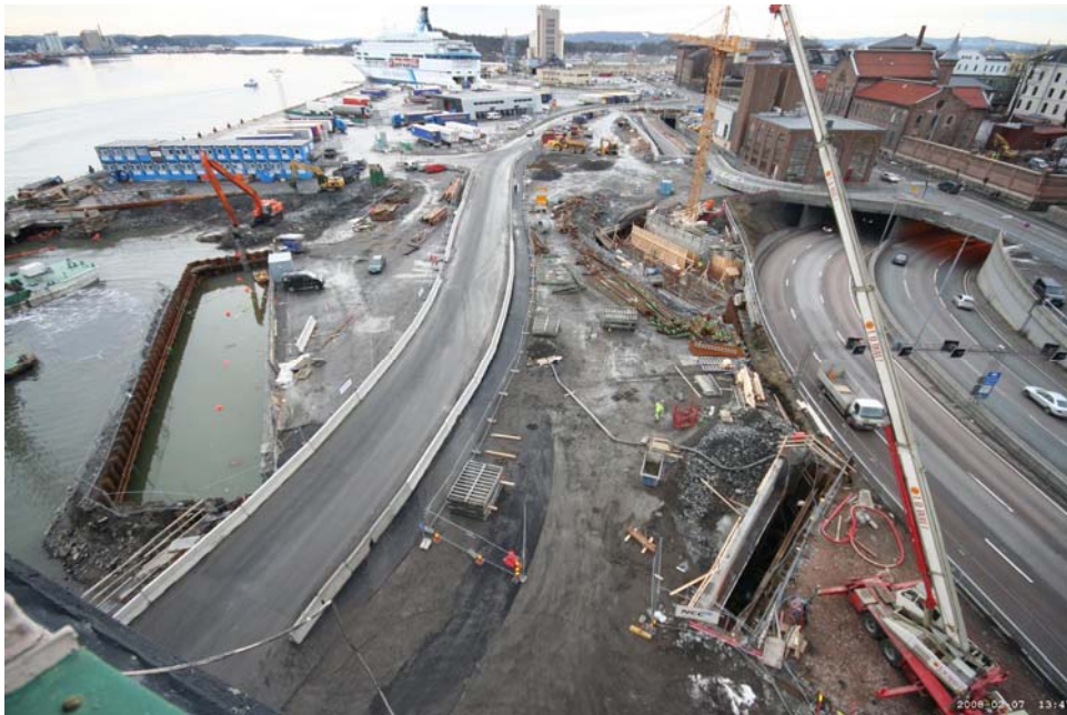
7.2.2008: Ved åpningen til rampen Rådhusgata gjenfylles det ikke.
