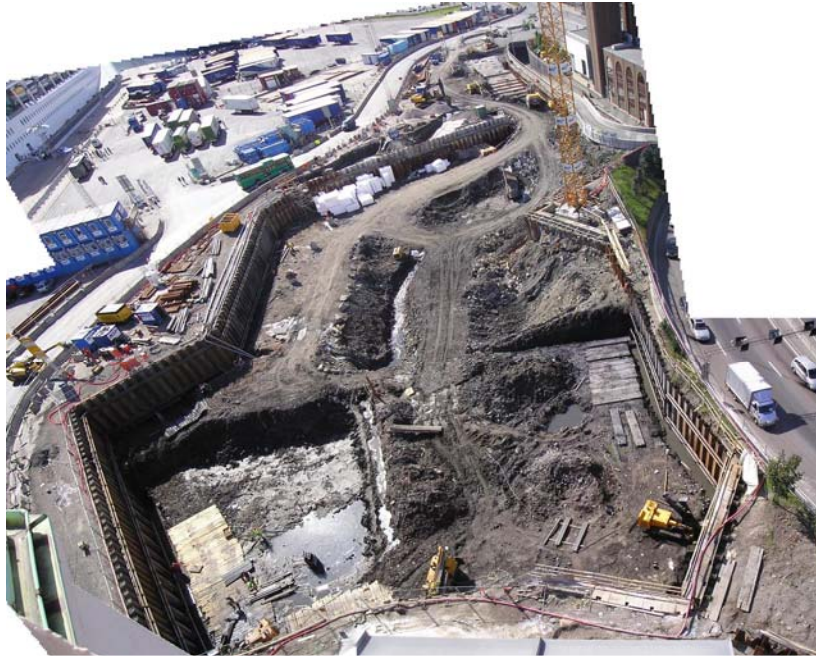
1.9.2006: Massene i gropa ble definert som forurenset og levert til Lindum i Drammen. Det ble kostbart. Senere ble grensene for forureningsgrad endret.
