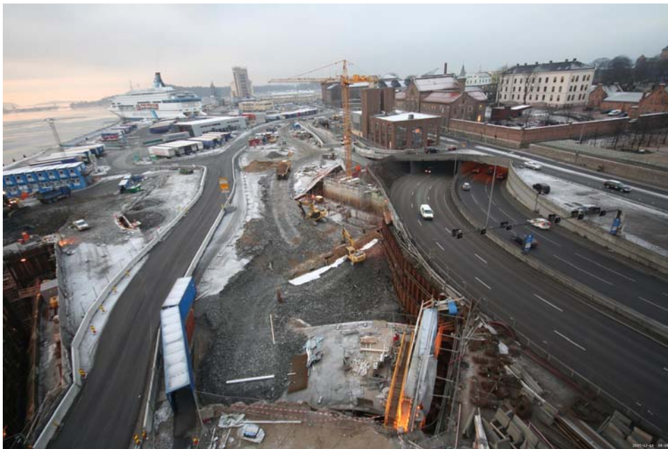
19.12.2007: Gjenfylling av spuntgropa før jul etter ca. to års byggetid.
