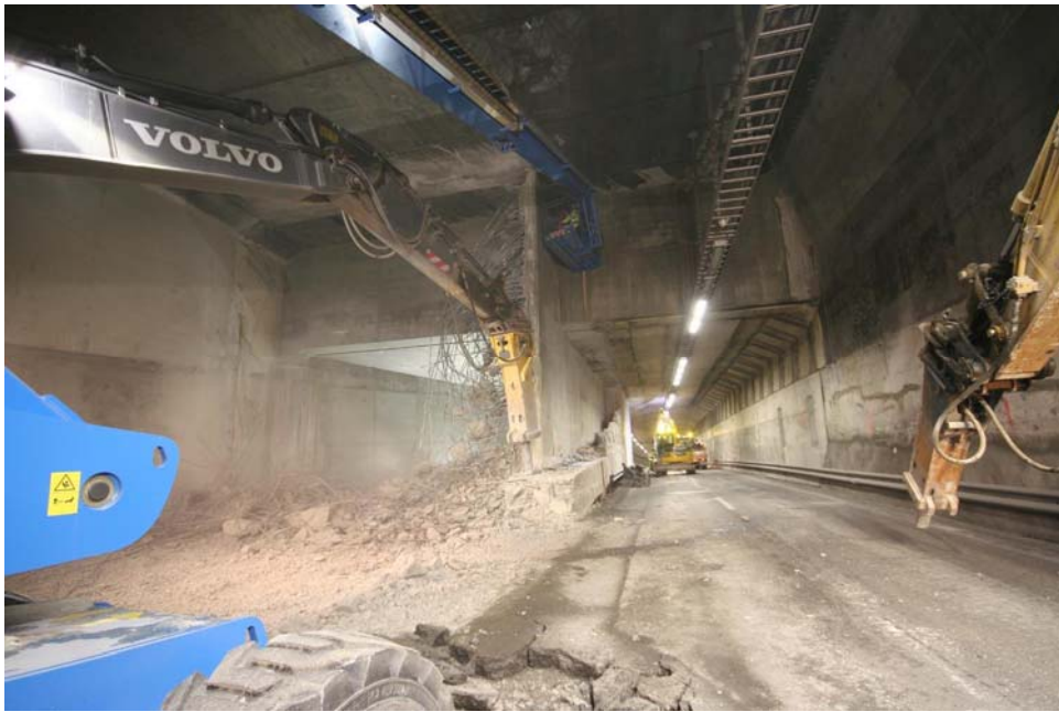
2011 02 23 Fjerning av beskyttelsesvegg for etappe 2
