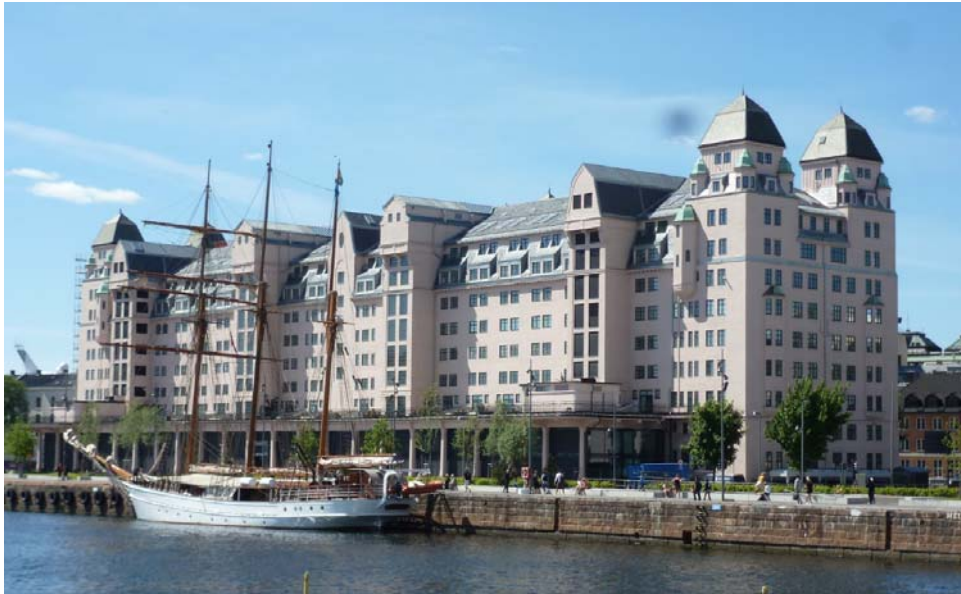
2016: Området har fått gatepreg og byens befolkning har fått kaien til disposisjon
