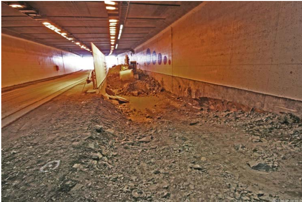
2010 05 02 Oppsetting av vegg mot trafikk i vestgående løp
