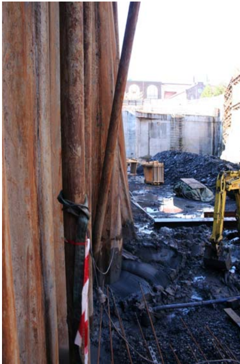
Bruddet skjedde etter at 2. stiverrad var fjernet
