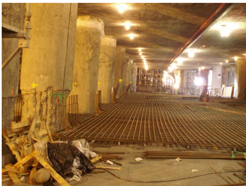
2007 11 26 Armering ny bunnplate. Vi slisset oss inn i søyla.
