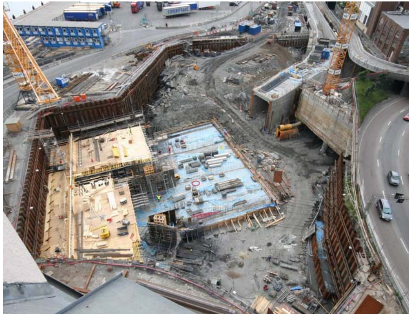
14.6.2007: Sikkert arbeid i høyden er utfordrende. Bruk av rekkverk og sele ble diskutert mye med entreprenøren.
