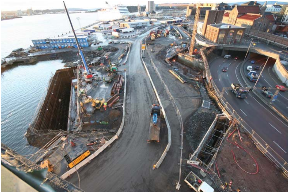
Utgraving for senketunnel er ferdig innenfor spunten. Gangveikulverter fjernes og Havneveien flyttes.
