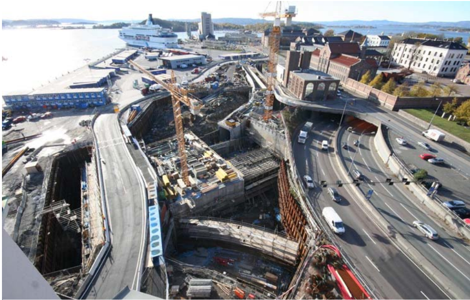
12.10.2007: Asfaltering og vegmerking av Havneveien er ferdig. Gangveien er også klar for ferangepassasjerene.
