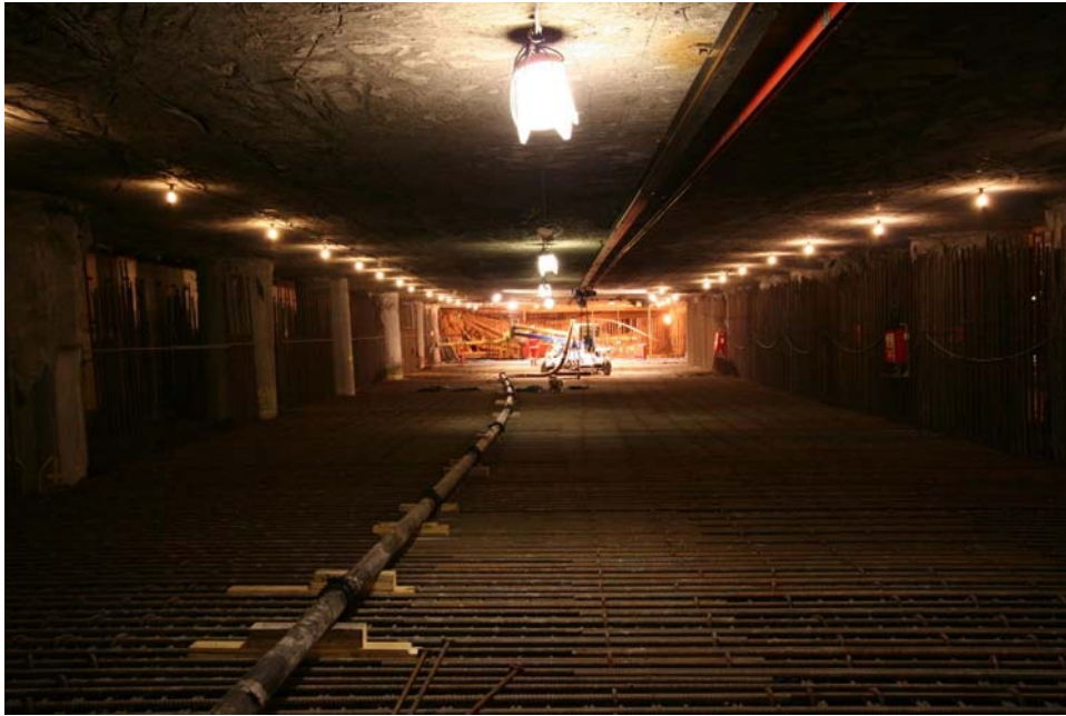
2008 03 07 Støp bunnplate i tre etapper. Betongen pumpes fram.
