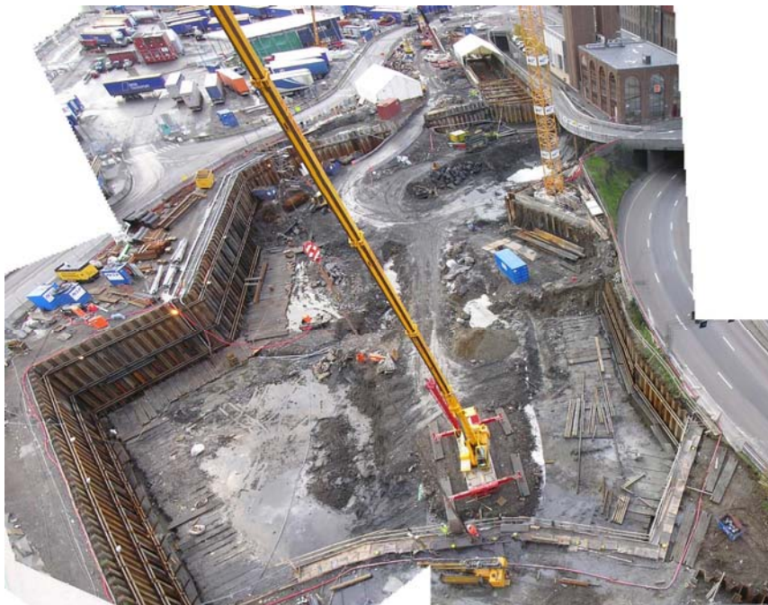
24.10.2006: Innvendig avstiving i Danskerammpa. Betongarbeid pågår.
