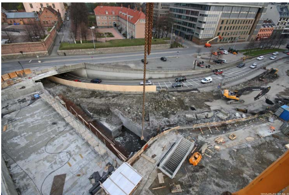
2010 05 03 Vestgående trafikk i Festningstunnelen
