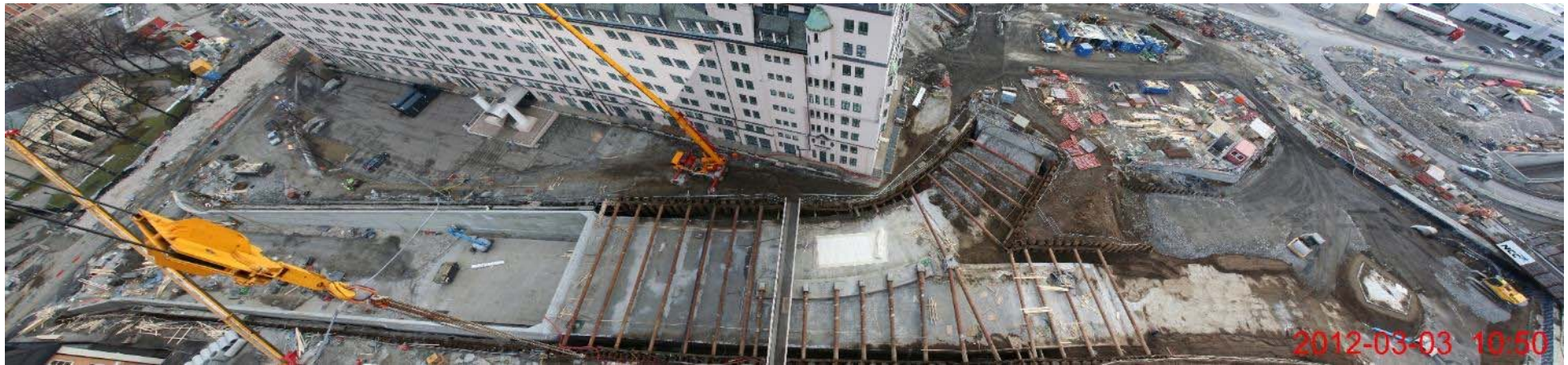
2012 03 03: Ferdig støpt vegger i trau og portal. Portalen fungerer som et rekkverk for gående i parken.
