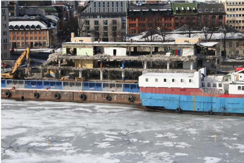
9.3.2010: Gravemaskin påmontert betongsaks utfører jobben
