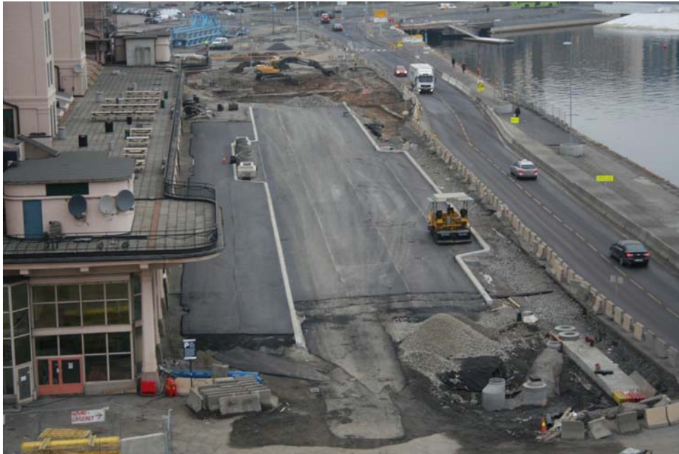
2011 11 18 Asfaltering – ved asfaltering mot eksisterende bygg, må høyden tilpasses slik at grensesnittene blir pene
