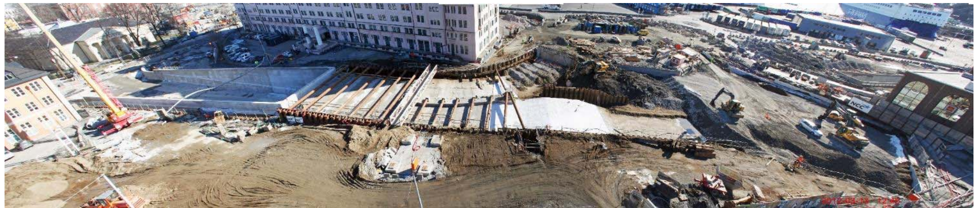
2012 03 13: Gjenfylling med sand mellom spunt og betong
