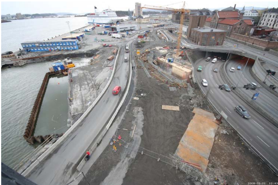
22.2.2008 Spuntgropa fylles med vann. Åpning til rampe dekkes til med stålplater
