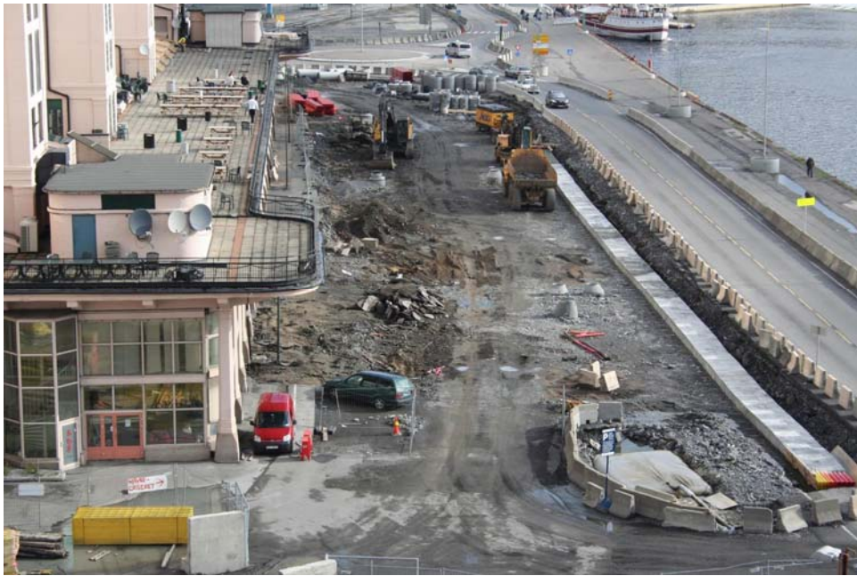
2011 09 12 Betongen har herdet
