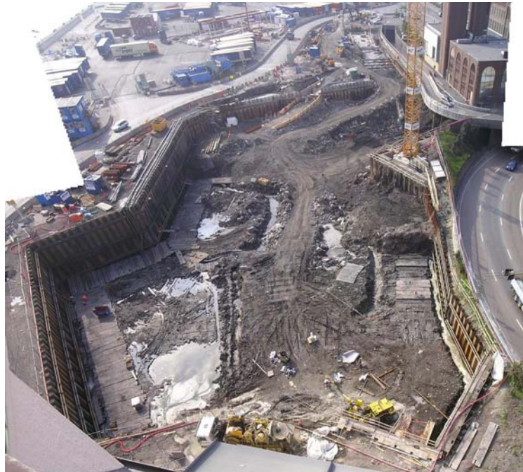
22.9.2006: Arbeid pågår på 3. stognivå.
