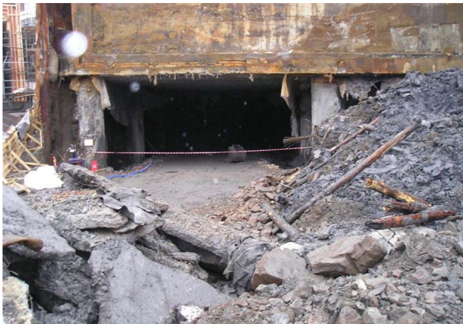
2007 02 09 Graving under eksisterende bunnplate i Festningstunnelen. Tunnelen var forberedt for en ny fase og lukket.
