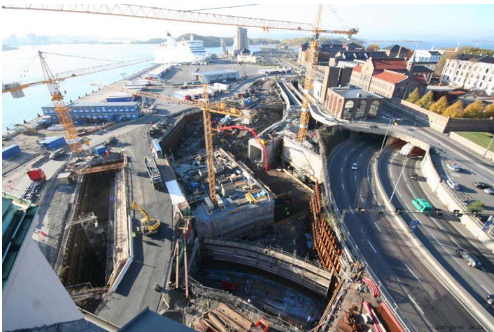
5.10.2016: Montering av rekkverk på midlertidig Havnevei
