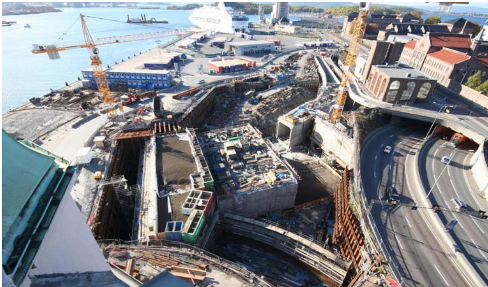
28.9.2007: Havneveien måtte flyttes siden senketunnelen kom. På grunn av forsinkelser blant annet på grunn av mye vann i gropa, måtte Havneveien legges over kulverten i byggeperioden. Containere ble fylt med stein og betong ga sidestøtte ut mot kanten.
