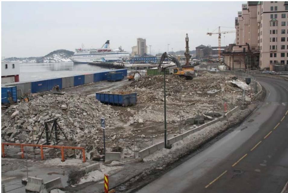
18.3.2010: Bygget er ned og trafikken er satt på.
