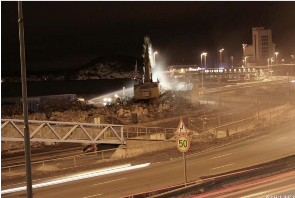
16.3.2010: I løpet av 1 ½ døgn er resten av bygget nede.
