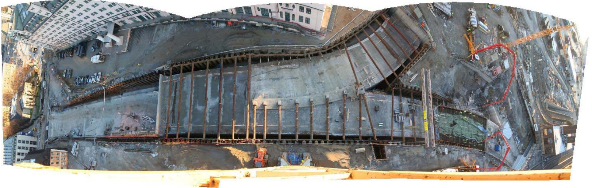
2011 12 20: Siste seksjon byggegrop 2 støpes.
