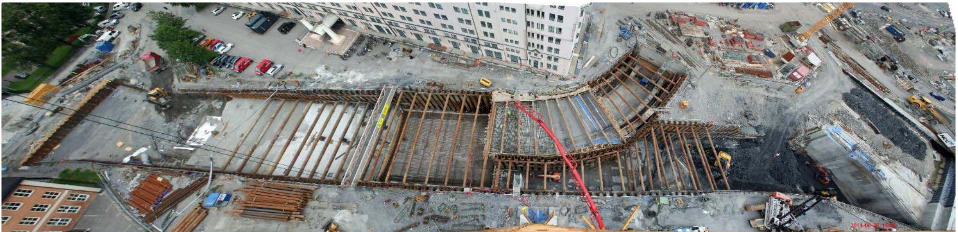
2011 06 30: Støping av tak og vegger av en seksjon i byggegrøp 1
