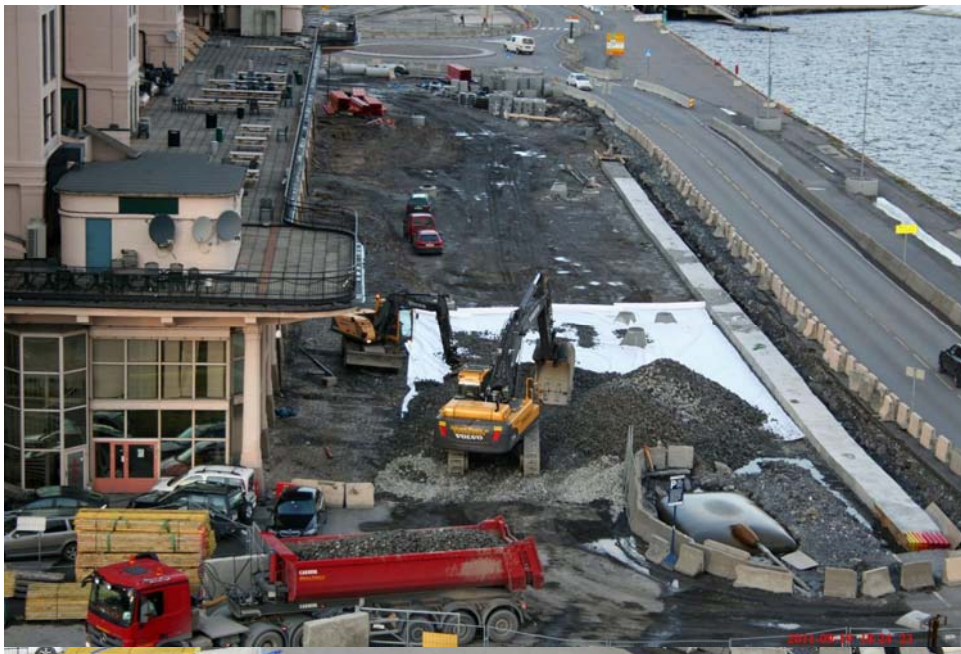
2011 09 19: Fiberduk legges ut og frostsikre og masser som gir god bæreevne legges ut
