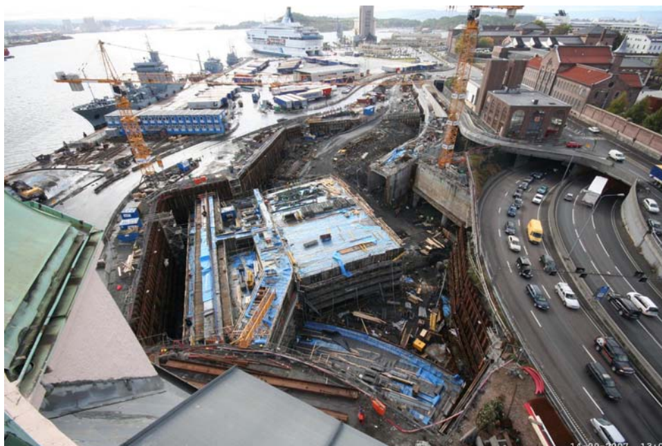
14.9.2007: Seksjon 1 og 2 ferdig støpt.
