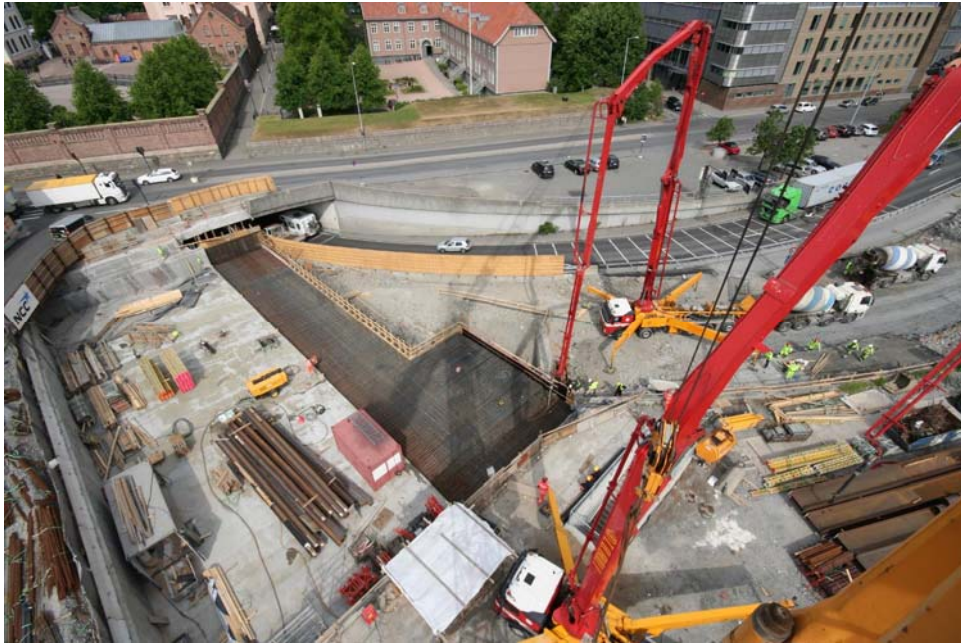
2010 06 09 Armering takplate vestgående løp
