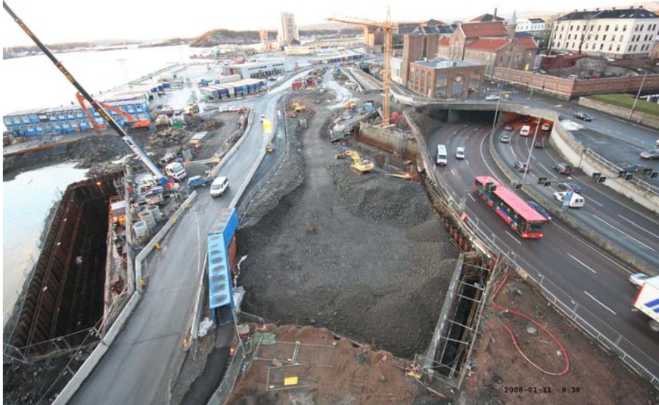
11.1.2008: Tilbakefylling masser over tunnelen ferdigstilles på nyåret
