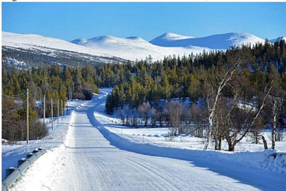
Figur 21.3 For vinterdriftsklasse DkD kan vegen ha snø- og isdekke (Foto: Jarle Wæhler)
