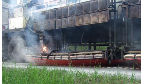
Figur 14.21 Forvarming før asfaltering. (Foto: Vegard Opsahl)
