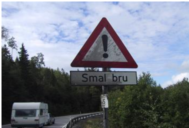
Figur 16.6 Behov for rengjøring (vask) av skiltet (Foto: Bjørn Skaar)
