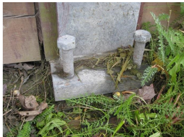
Figur 24.5 Støyskjermer utsatt for tagging. Til høyre justerbart feste til fundament. (Foto: Øystein Larsen)
