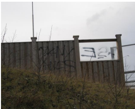
Figur 24.5 Støyskjermer utsatt for tagging. Til høyre justerbart feste til fundament. (Foto: Øystein Larsen)
