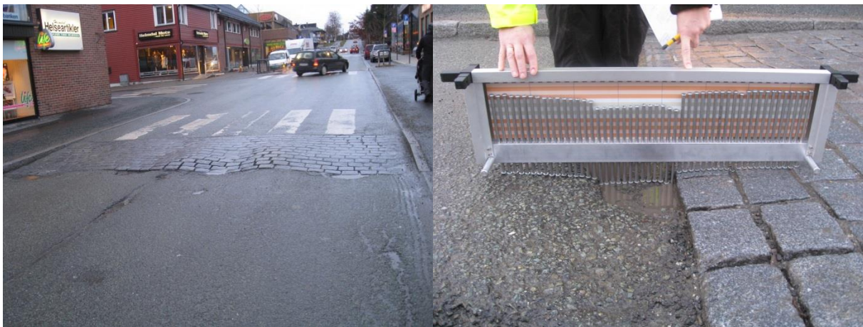
Figur 24.7 Opphøyd gangfelt med brosteinmarkering. Til høyre brostein farlig for brøyte- skjær (Foto: Øystein Larsen)
