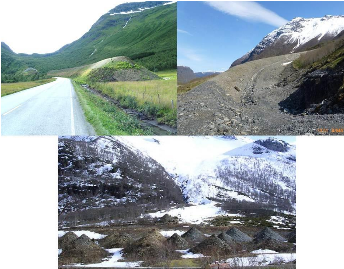
Figur 22.7 Ulike terrengtiltak. Oppe til venstre fangvoll på fv.60 i Strandadalen, Møre og Romsdal (Foto: Gunne Håland). Oppe til høyre ledevoll på fv.615 ved Storesvora, Sogn og Fjordane (Foto: Pernille Aas). Nederst kjegler i Strandadalen, Møre og Romsdal (Foto: Harald Norem).
