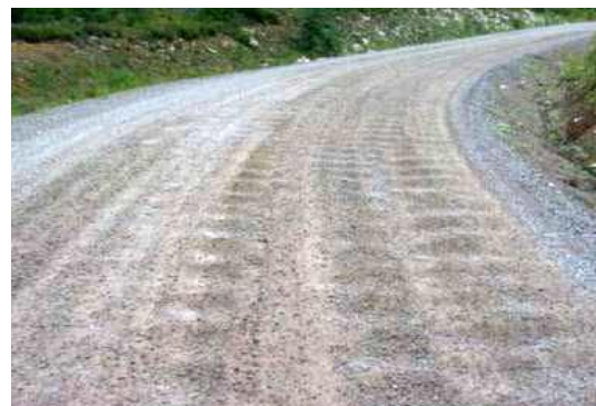
Figur 14.6 Ujevnt grusdekke (vaskebrett). Til venstre tilstandsgrad 1 (akseptabel tilstand). Til høyre tilstandsgrad 3, dvs. snarlig behov for tiltak. (Foto: Vägverket)
