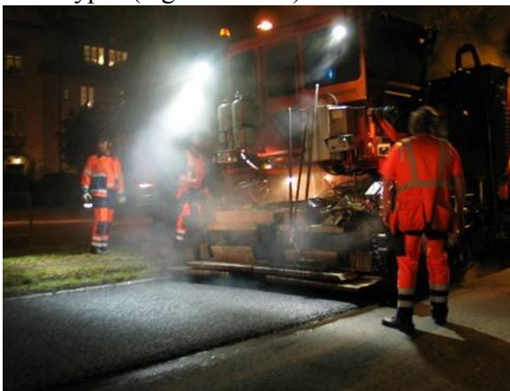
Figur 14.22 Utlegging av støysvake tynndekker (Ring 2 Oslo, Rv 170 Bjørkelangen). (Foto: Jostein Aksnes)
