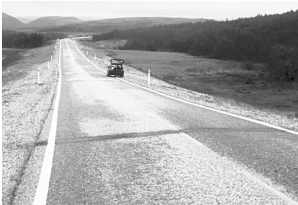
Figur 14.15 Tverrsprekker pga. lavtemperatur, Finnmark. (Foto: Eivind Andersen)
