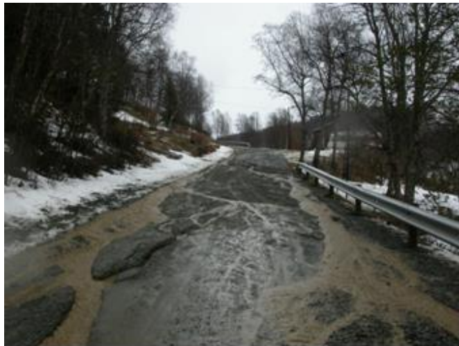
Figur 8.5 Regn og snøsmelting kan gi omfattende skader på et grusdekke (Foto: Svv Region Nord)
