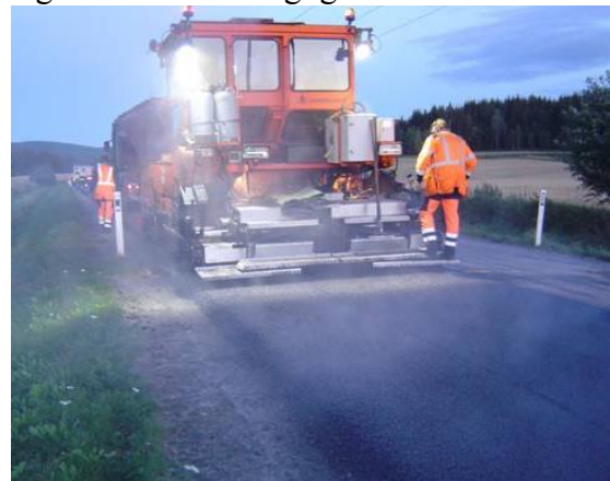
Figur 14.22 Utlegging av støysvake tynndekker (Ring 2 Oslo, Rv 170 Bjørkelangen). (Foto: Jostein Aksnes)
