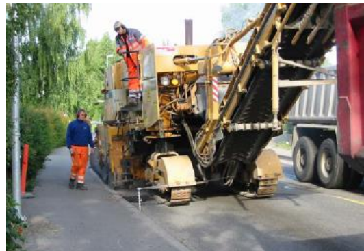
Figur 14.19 Asfaltfresing; traufresing (til venstre) og planfresing (til høyre). (Foto: Arvid Jordet)
