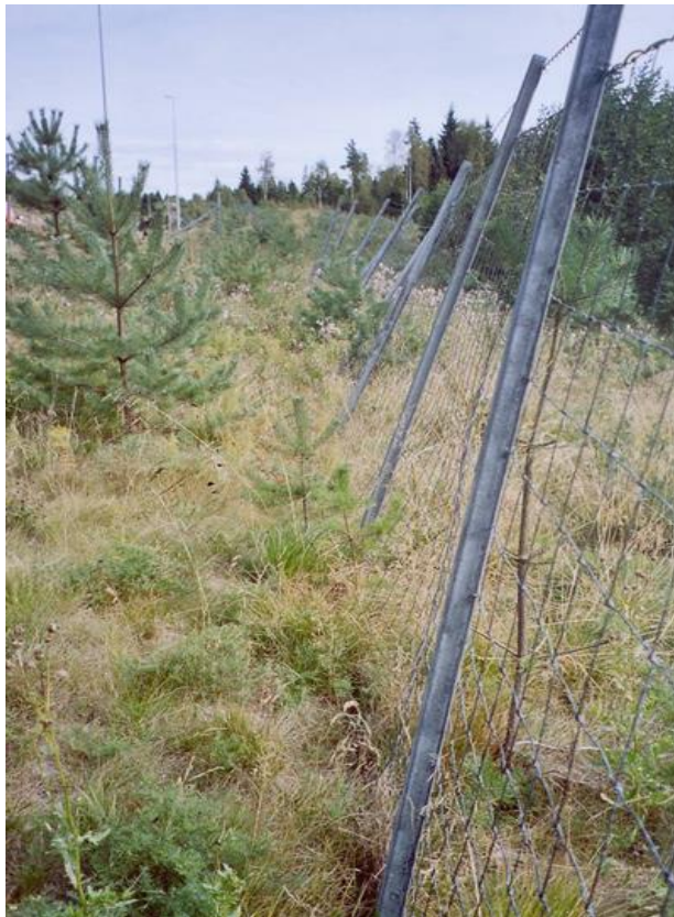
Figur 5.3 Viltgjerdet er i ferd med å brytes ned, sannsynligvis på grunn av en kombinasjon av mye snø og dårlig fundament. Dette kan på sikt gjøre det lettere for store dyr å forville seg inn på vegene. (Foto: Statens vegvesen)
