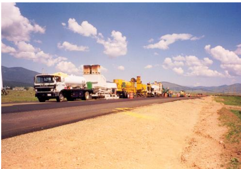
Figur 14.32 Varm gjenvinning på veg med Pyropaver. Legg merke til skorsteinene for avbrenning av røykgassene. (Foto: Paveover Inc., USA)
