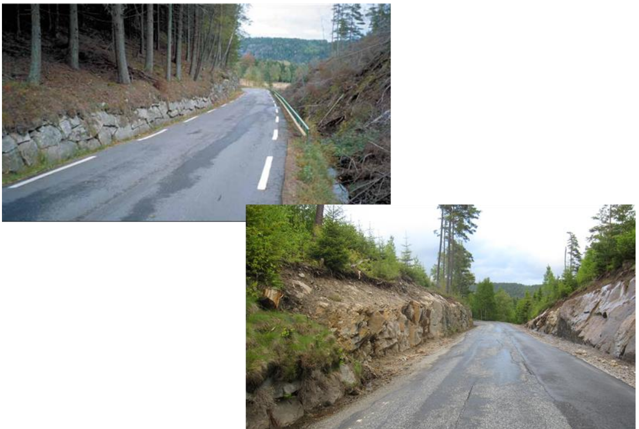
Figur 5.8 Berbyveien i Østfold er en mellomriksveg fra Unionstiden og ble anlagt i 1880 og inngår i Nasjonal verneplan for veger, bruer og vegrelaterte kulturminner. Den er fredet etter kulturminneloven. Det øverste fotoet viser vegen slik den så ut da vegen ble fredet. Det nederste fotoet er eksempel på utbedring der det har vært manglende kunnskap om vegens verneverdi. Det er viktig at kulturminnefaglig kompetanse vurderer hvordan hensynet til kulturminnet kan ivaretas før et såpass omfattende tiltak gjennomføres. I dette tilfellet hadde det vært mulig å utbedre vegen med mye enklere tiltak enn det som er gjennomført (vegetasjonsrensing, grøfting, utbedring av rekkverk etc.). (Foto: Statens vegvesen, 1999 og 2011)
