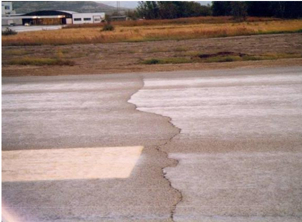
Figur 14.23 Lavtemperaturoppsprekking. Til venstre, åpen utettet sprekk som gir fritt nedløp for vann. Til høyre, forseglet sprekk (Lakselv lufthavn, Banak). (Foto: Joralf Aurstad)
