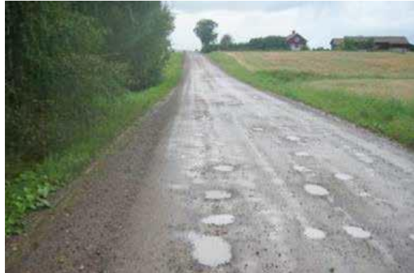
Figur 14.5 Ujevnt grusdekke (slaghull). Til venstre tilstandsgrad 1 (akseptabel tilstand). Til høyre tilstandsgrad 3, dvs. snarlig behov for tiltak. (Foto: Vägverket)
