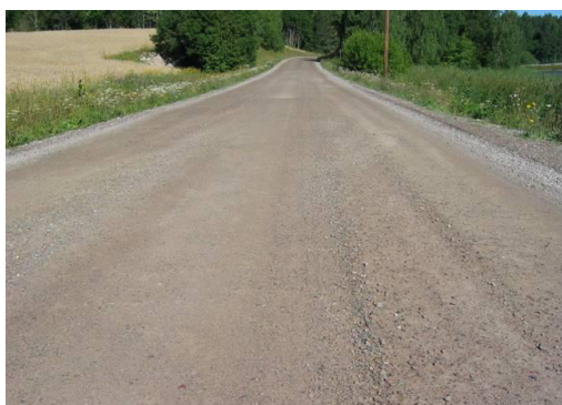
Figur 14.7 Løs grus. Til venstre tilstandsgrad 1, akseptabel tilstand. Til høyre tilstandsgrad 3, dvs. snarlig behov for tiltak. (Foto: Vägverket)
