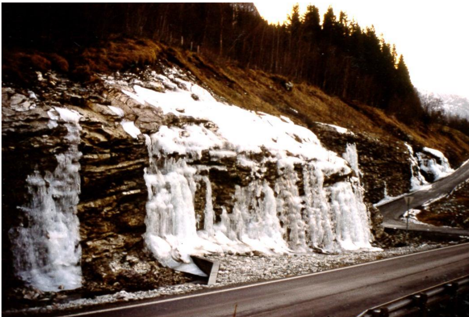
Figur 22.25 En litt bredere grøft er ofte nok for å hindre at ismasser kommer ut på vegen. Rv. 15 Kongeneset, Sogn og Fjordane. (Foto: Harald Norem)
