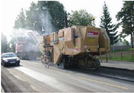
Figur 14.19 Asfaltfresing; traufresing (til venstre) og planfresing (til høyre). (Foto: Arvid Jordet)
