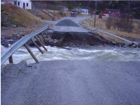
Figur 8.18 Konsekvensene av blokkert stikkrenne kan være store (Foto: Trygve Rullestad)
