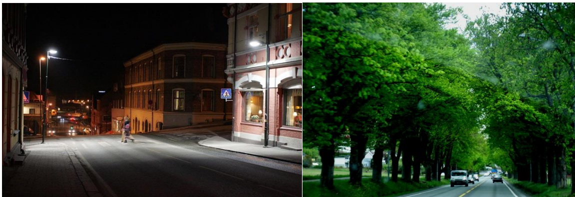
Figur 18.2 Prioritert belysning ved gangfelt (Foto: Vegard Stensrød). Til høyre er belysningen skjult inne mellom greinene (Foto: Hans Sandland)
