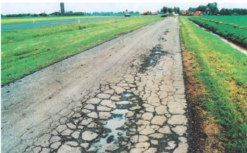
Figur 14.16 Gammelt, krakelert dekke. (Foto: Ukjent)
