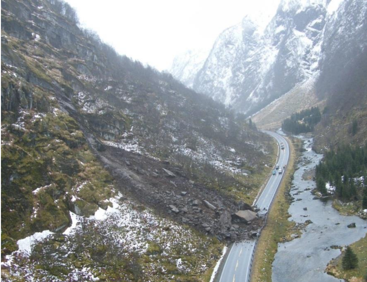
Figur 22.14 Steinskred på veg ved E39 Instedfjorden, Sogn og Fjordane. Volum ca. 1500 m. 3 (Foto: Njål Farestveit)
