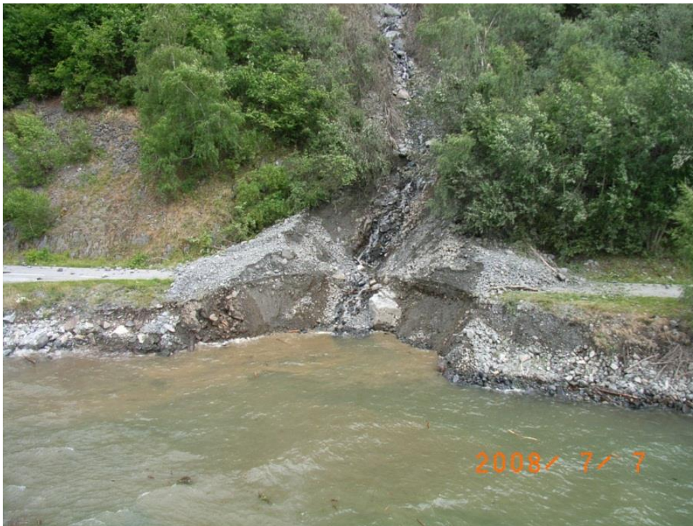
Figur 22.19 Eksempel på flomskred med stor eroderende kraft som har ødelagt en veg. Skjeldal, Sogn og Fjordane. (Foto: Svein Helge Frækaland)
