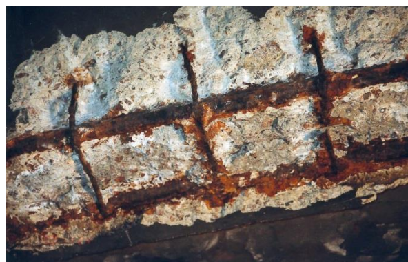
Figur 19.2 Eksempel på armeringskorrosjon initiert av klorider, før og etter fjerning av løs/delaminert betong (Foto: Eva Rodum)
