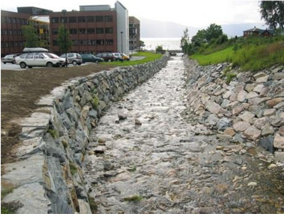
Figur 22.20 Erosjonssikring av et elveløp der det kan gå flom og flomskred. Regionvegkontoret i Leikanger, Sogn og Fjordane. (Foto: NVE)
