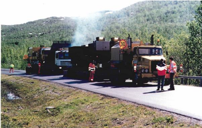
Figur 14.31 Varm gjenvinning på veg (Remix). (Foto: Geir Berntsen)
