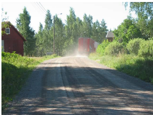
Figur 14.8 Støv fra grusveg. Til venstre tilstandsgrad 1, akseptabel tilstand. Til høyre tilstandsgrad 3, dvs. snarlig behov for tiltak. (Foto: Vägverket)
