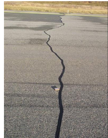
Figur 14.23 Lavtemperaturoppsprekking. Til venstre, åpen utettet sprekk som gir fritt nedløp for vann. Til høyre, forseglet sprekk (Lakselv lufthavn, Banak). (Foto: Joralf Aurstad)
