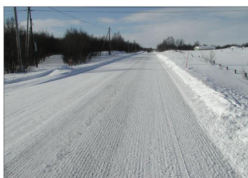
Figur 21.7 Veghøvel med underskjær i aksjon, til høyre jevnt snø-/isdekke etter høvling (Foto: Statens vegvesen)
