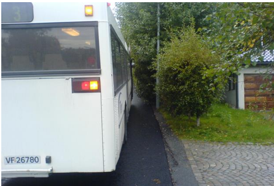
Figur 23.2 Private trær vokser ut i vegen og hindrer framkommelighet for tunge kjøretøy og fotgjengere Foto: Nettbuss Trøndelag
