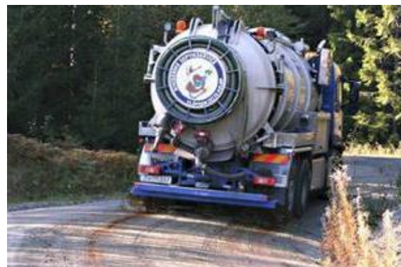
Figur 14.11 Støvbinding med lignin (Dustex). Utlekking med hhv gjødselspreder og tankbil. (Foto: Statens vegvesen)
