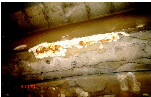
Figur 19.2 Eksempel på armeringskorrosjon initiert av klorider, før og etter fjerning av løs/delaminert betong (Foto: Eva Rodum)
