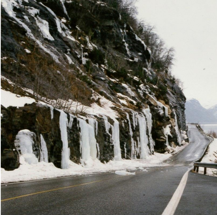
Figur 22.22 Isnedfall på veg. Fv. 572 Bruravik, Hordaland. (Foto: Harald Norem)
