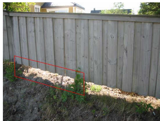
Figur 5.2 Støyskjermer skal være tette. Effekten av en støyskerm med slike sprekker er sterkt redusert og dermed kan det hende at skjermen ikke oppfyller støyregeverkets krav. (Foto: Statens vegvesen)
