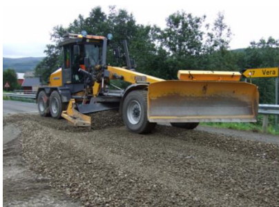
Figur 14.25 Eksempel på forsterkningstiltak; utlegging av ny bærelagspukk oppå gammelt dekke med påfølgende dypfresing til 25 cm dybde. (Foto: Vegard Opsahl)
