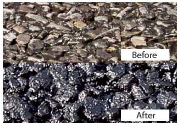
Figur 14.26 Fornyng av aldret asfaltdekke med bitumenemulsjon. (Foto: USAsphalt Maintenance NN)
