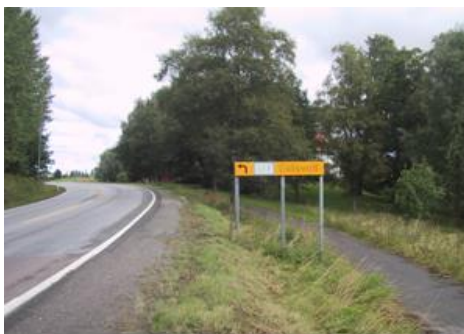
Figur 16.4 Skiltets folie er falmet og har så dårlig refleks at det ikke fungerer verken i dagslys eller mørke (Foto: Bjørn Skaar)
