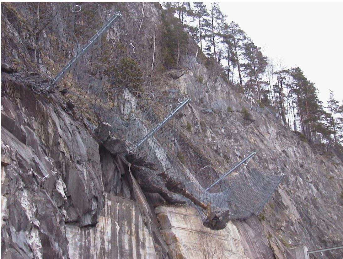
Figur 22.15 Fanggjerdene er satt opp rett over en adkomstveg inn til et kraftverk for å fange opp rullende steiner. Dalen kraftverk, Telemark. (Foto: Audun Langelid)
