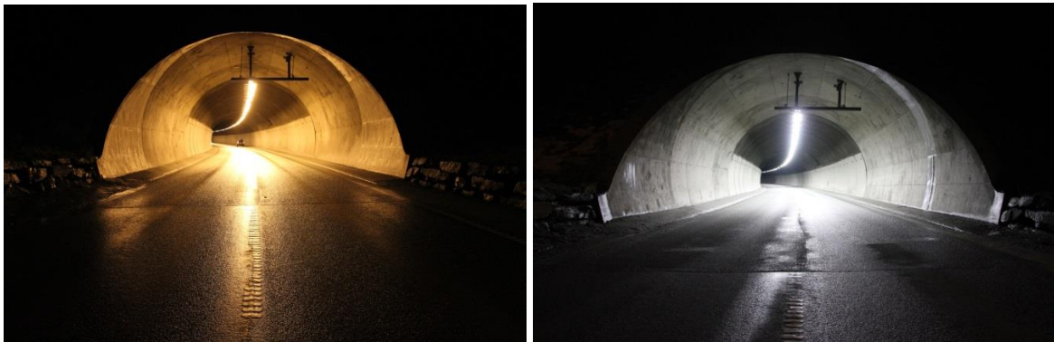
Figur 18.1 Utskifting fra Natrium høytrykk til LED i Brekk tunnel (Foto: Pål J. Larsen)
