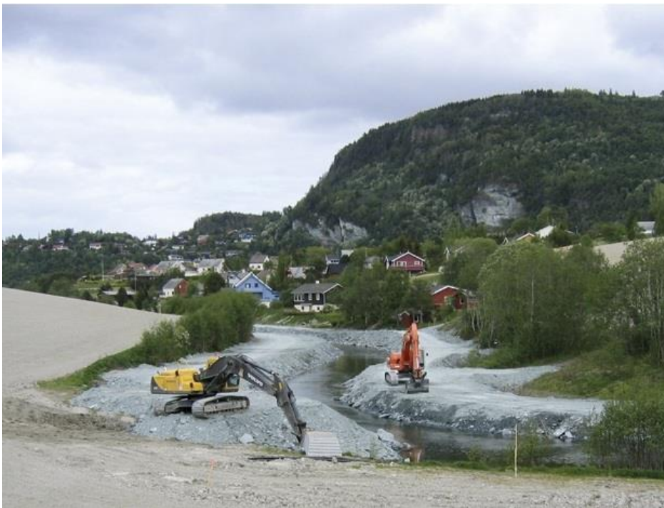
Figur 22.27 Her blir en utsatt elvestrekning erosjonssikret for å hindre erosjon og utgraving i foten av skråninger med kvikkleire. (Foto: NVE)
