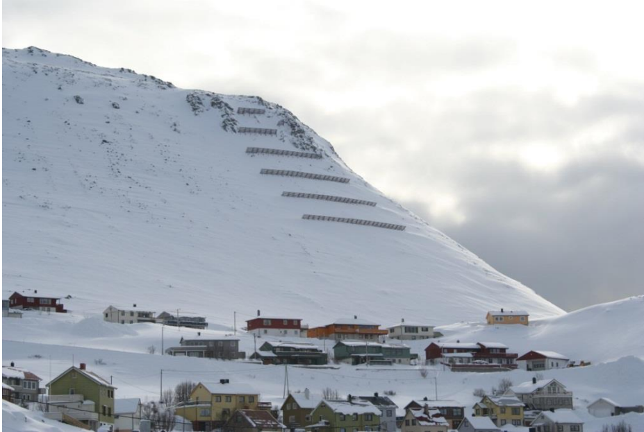
Figur 22.8 Støtteforbygninger som både sikrer boligområde og en veg i Honningsvåg. I slike tilfeller kan det være kostnadseffektivt å bruke støtteforbygninger som sikringstiltak. (Foto: Jan Otto Larsen)
