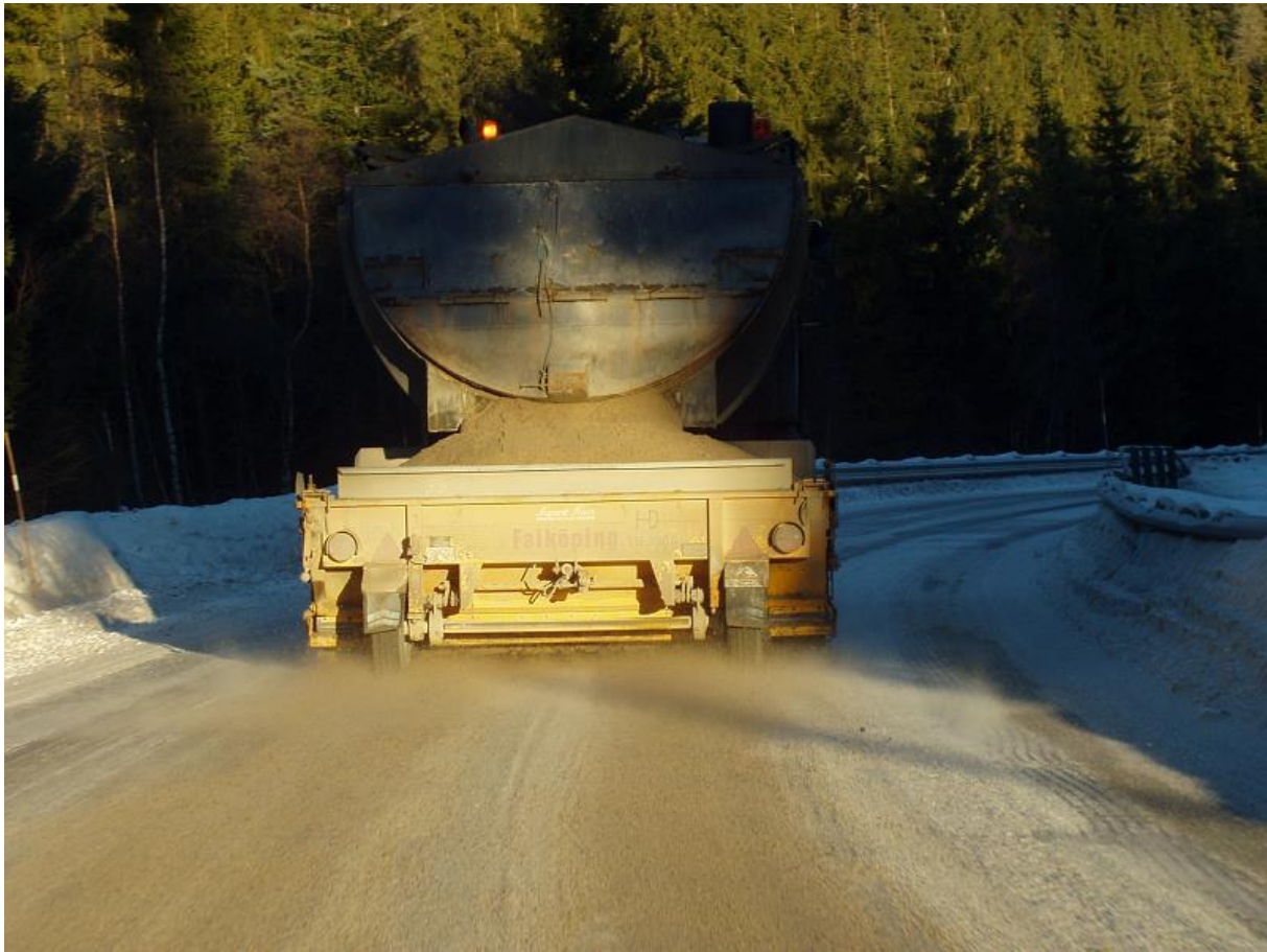
Figur 21.12 Strøing med tørr sand. (Foto: Per Ingar Haug)
