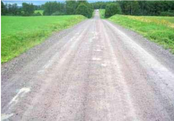
Figur 14.5 Ujevnt grusdekke (slaghull). Til venstre tilstandsgrad 1 (akseptabel tilstand). Til høyre tilstandsgrad 3, dvs. snarlig behov for tiltak. (Foto: Vägverket)
