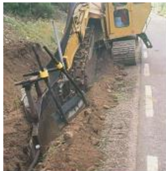
Figur 8.23 Hydraway Drain; prinsippkisse og foto fra utlegging (Foto: Per Syvaldsen)
