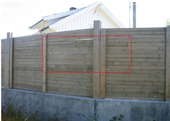
Figur 5.2 Støyskjermer skal være tette. Effekten av en støyskerm med slike sprekker er sterkt redusert og dermed kan det hende at skjermen ikke oppfyller støyregeverkets krav. (Foto: Statens vegvesen)
