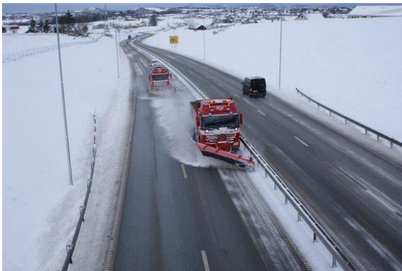
Figur 21.2 Vinterdriftsklasse DkA: Vegen brøytes og saltes slik at den blir bar kort tid etter snøfall (Foto: Risa AS)
