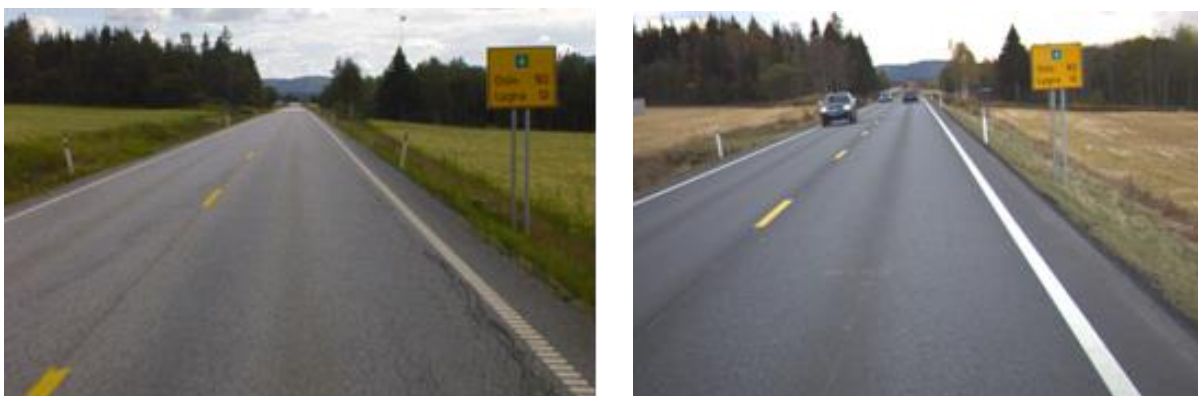
Figur 9.8 Kantforsterkning med stålarmring på rv. 4, Oppland – før (2007) og etter (2009) tiltak (Foto Statens vegvesen)
