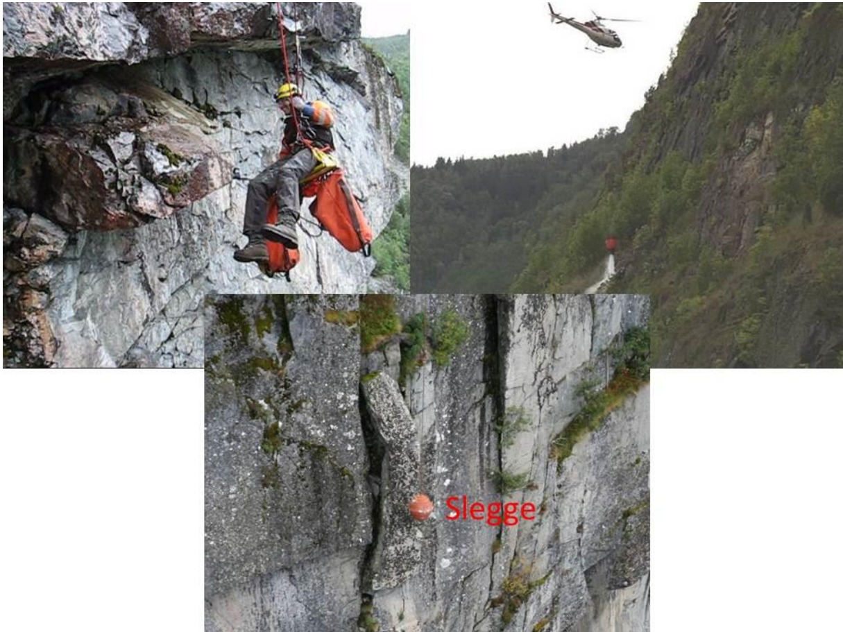
Figur 22.16 Ulike sikringstiltak som blir brukt mot steinsprang og steinskred. Til venstre spettrensk utført av et renskelag hengende i tau (Foto: Betongrenovering). Til høyre spyling (Foto: Svein Helge Frækaland). Nederst sleggerensk (Foto: Tore Humstad).
