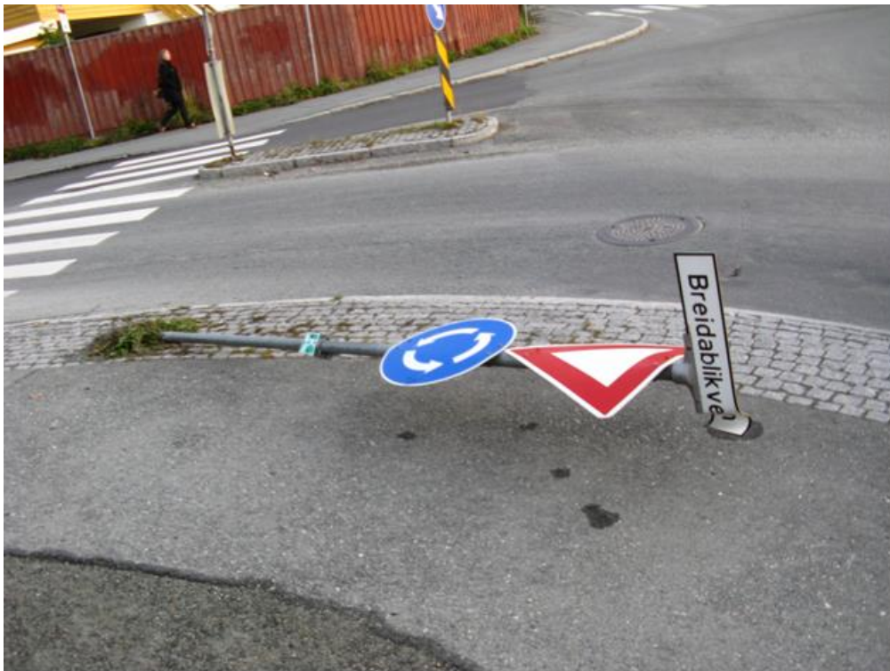
Figur 23.4 Nedkjørt skilt, Foto: Terje Lindland
