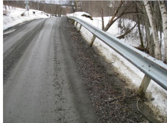
Figur24.4 Rekkverk mellom kjøreveg og gang- og sykkelveg. Til høyre utbøyd rekkverk med skader på stolper. (Foto: Øystein Larsen)
