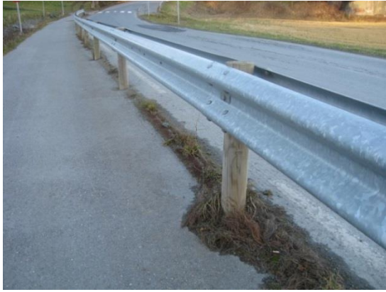
Figur24.4 Rekkverk mellom kjøreveg og gang- og sykkelveg. Til høyre utbøyd rekkverk med skader på stolper. (Foto: Øystein Larsen)
