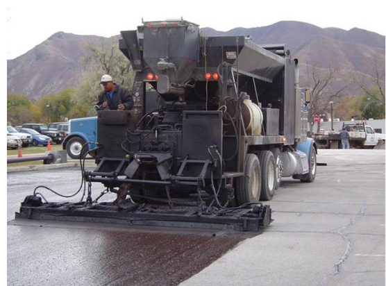
Figur 14.27 Asfaltering med Slurry seal. (Prinsippskisse og foto: Morgan Pavement, USA)
