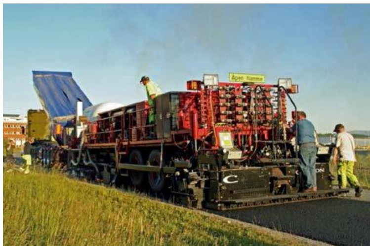
Figur 14.29 Gjenvinning på veg ved bruk av repaver. (Foto: KFA) /10/
