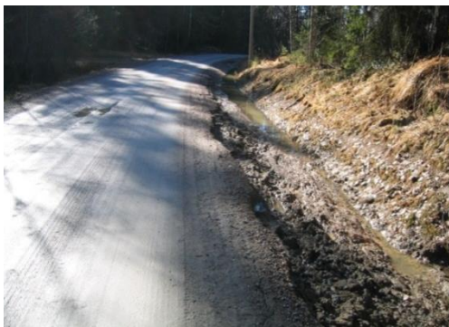
Figur 8.15 Dype sidegrøfter må renskes jevnlig for å opprettholde funksjonen (Foto: Geir Berntsen)
