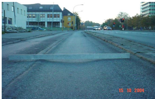
Figur 14.12 Sporete og deformerte asfaltdekker finner vi både utenfor og i tettbygd strøk. (Foto: Leif Bakløkk/Brynhild Snilsberg)
