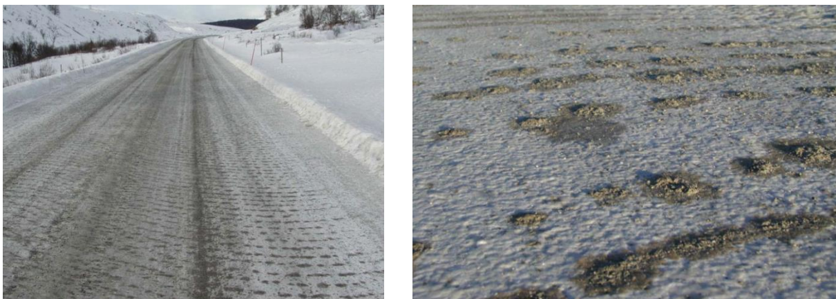
Figur 21.11 Strøing utført etter fastsandmetoden, oversiktsbilde og detaljbilde (Foto: Torgeir Vaa)
