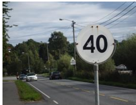
Figur 16.4 Skiltets folie er falmet og har så dårlig refleks at det ikke fungerer verken i dagslys eller mørke (Foto: Bjørn Skaar)
