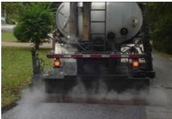
Figur 14.26 Fornyng av aldret asfaltdekke med bitumenemulsjon. (Foto: USAsphalt Maintenance NN)
