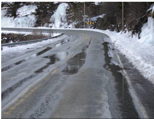
Figur 14.12 Sporete og deformerte asfaltdekker finner vi både utenfor og i tettbygd strøk. (Foto: Leif Bakløkk/Brynhild Snilsberg)
