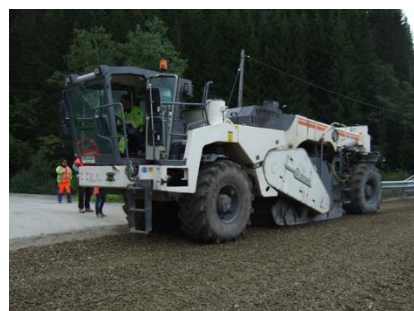
Figur 14.25 Eksempel på forsterkningstiltak; utlegging av ny bærelagspukk oppå gammelt dekke med påfølgende dypfresing til 25 cm dybde. (Foto: Vegard Opsahl)
