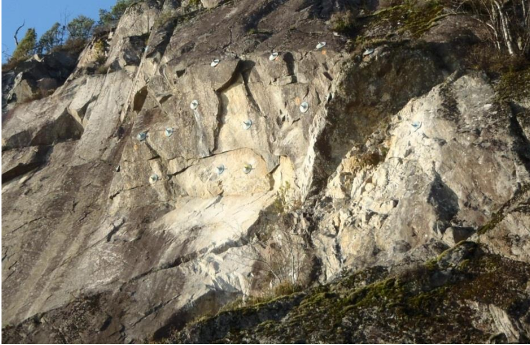
Figur 22.17 Eksempel på bolting for å feste løse blokker i fjellet. (Foto: Jens Tveit)
