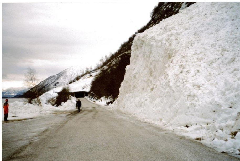
Figur 22.2 Veg som har blitt ryddet for snøskred. Fv. 13 Vetlefjorden, Sogn og Fjordane. (Foto: Harald Norem)
