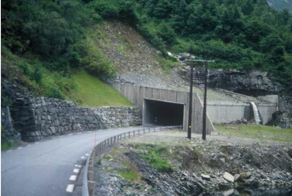
Figur 22.6 Eksempel på et skredoverbygg ved Fv. 615 Hyenfjorden i Sogn og Fjordane. Overbygget fungerer også som en forlengelse av en skredsikringstunnel. Forlengelse av tunnelen viste seg å være nødvendig da man fant ut at tunnelmunningen lå i et skredområde. (Foto: Harald Norem)
