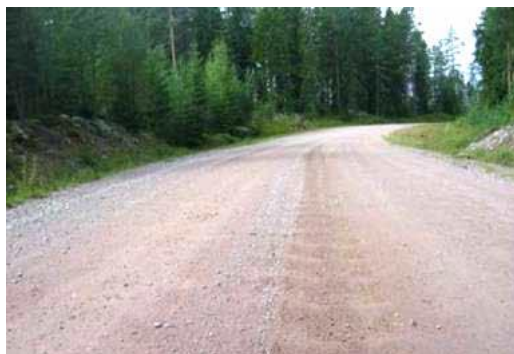
Figur 14.6 Ujevnt grusdekke (vaskebrett). Til venstre tilstandsgrad 1 (akseptabel tilstand). Til høyre tilstandsgrad 3, dvs. snarlig behov for tiltak. (Foto: Vägverket)
