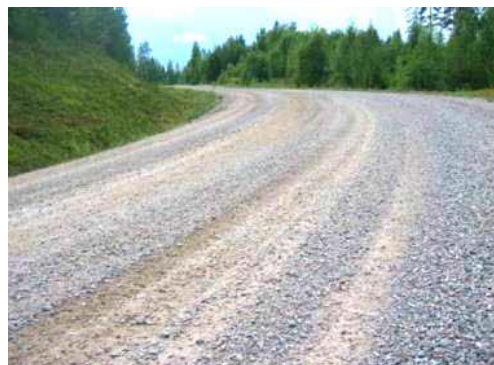
Figur 14.7 Løs grus. Til venstre tilstandsgrad 1, akseptabel tilstand. Til høyre tilstandsgrad 3, dvs. snarlig behov for tiltak. (Foto: Vägverket)
