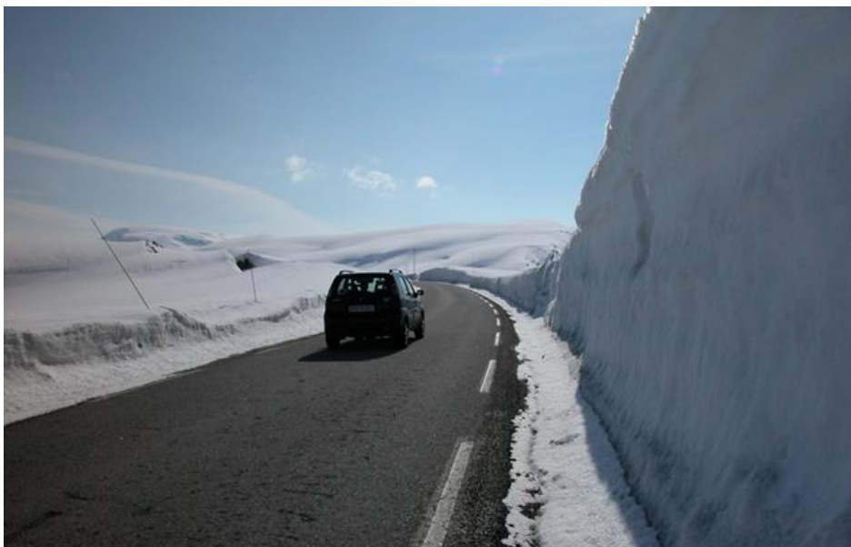
Figur 5.5 Høye brøytekanter kan være et problem for viltet som skal krysse vegen. Viltet vil bruke lenger tid på å krysse vegen og brøytekanterne kan dermed øke faren for viltpåkjørrel. (Foto: Statens vegvesen)
