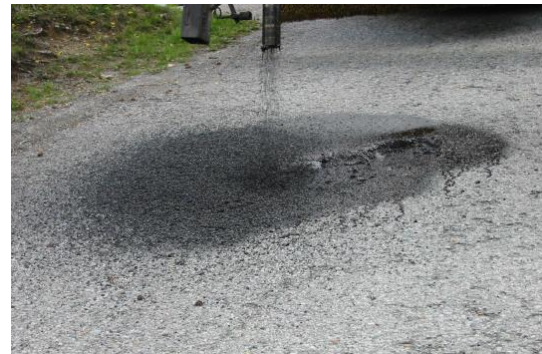
Figur 14.24 Lappekanon for reparasjon av hull (Mesta). (Foto: Noralf Haugvaldstad)
