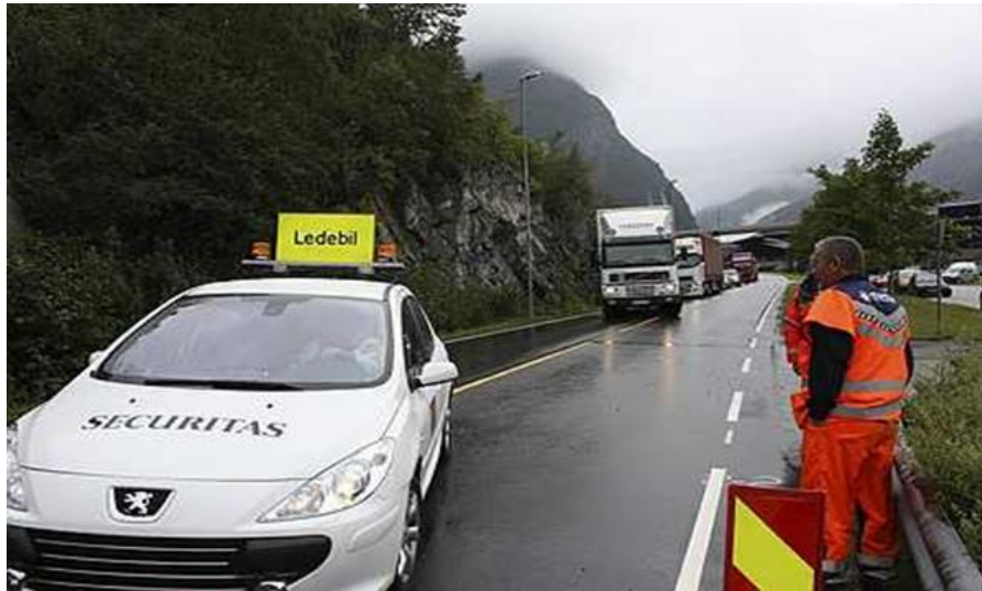
Figur 4.3 Bruk av ledebil ved rassikringsarbeid (Fotograf: Reidun Øverland, Statens vegvesen)
