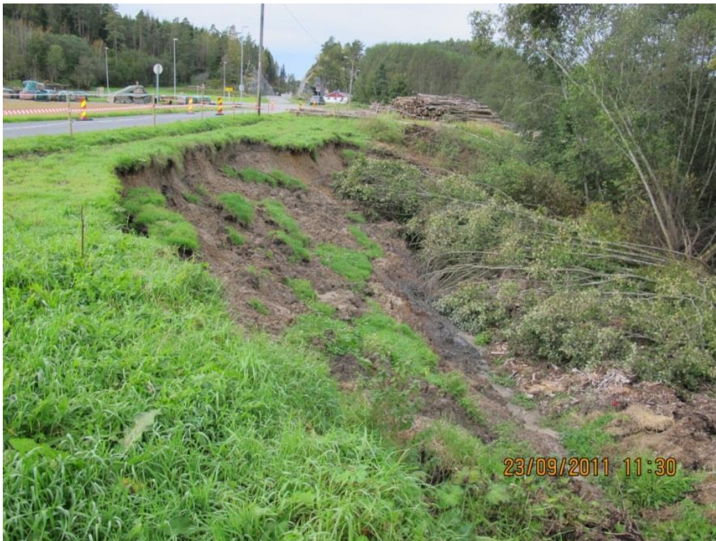
Figur 22.18 Lite jordskred (overflateskred) i en løsmasseskråning som sannsynligvis har løsnet langs et svakere lag like under overflaten. Fv. 208 Åby, Telemark. (Foto: Eigil Haugen)
