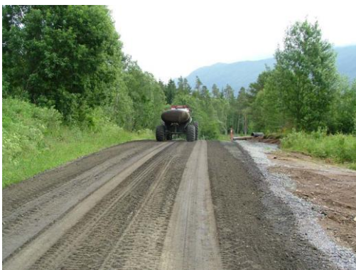
Figur 14.11 Støvbinding med lignin (Dustex). Utlekking med hhv gjødselspreder og tankbil. (Foto: Statens vegvesen)
