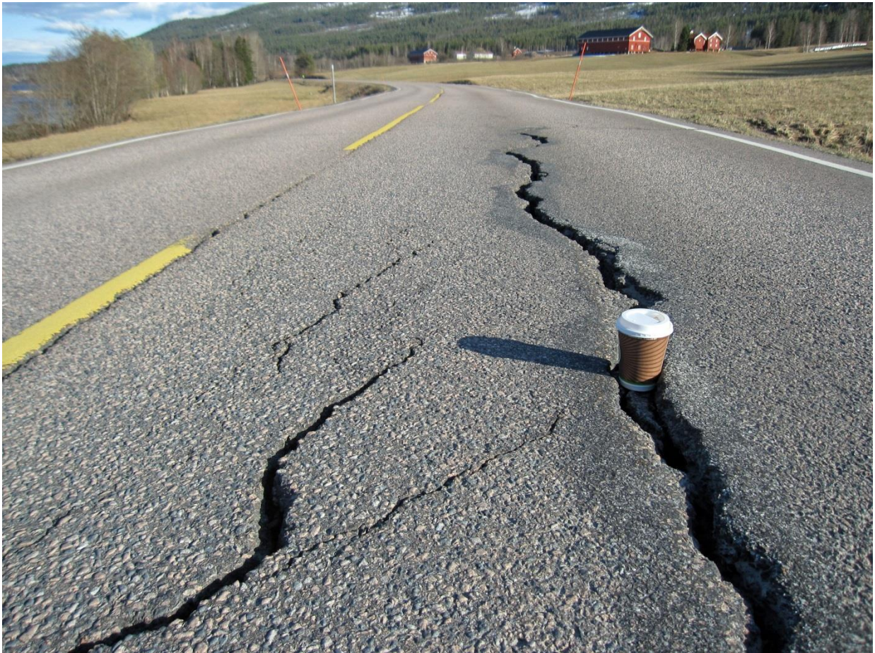
Figur 9.9 Oppsprekking etter breddeutvidelse (Foto Torleif Haugødegård)
