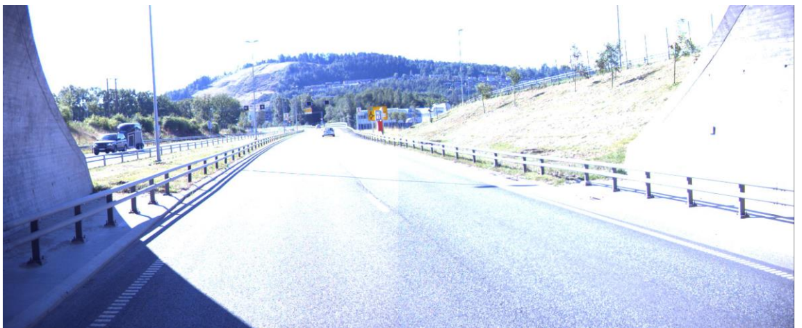
Sikt fra tunnelåpning til rundkjøring
