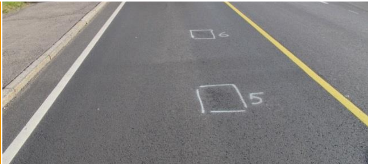
Konsekvens: Stopp i utlegging gir svakt parti i asfaltdekket (foto: Frode Malmstrøm)
