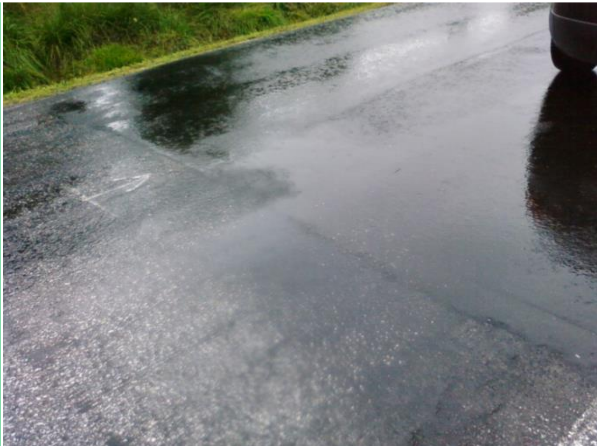
Riktig: Godt utført tverrskjøt (foto: Jan Sundstrøm)
