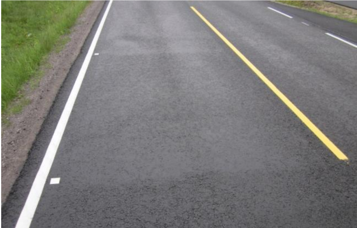
Konsekvens: Stopp i utlegging gir svakt parti i asfaltdekket (foto: Frode Malmstrøm)
