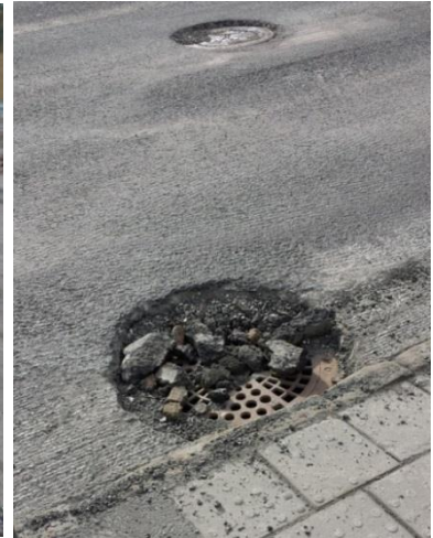
Feil: Dårlig rengjøring etter fresing (foto: Marit Fladvad)
