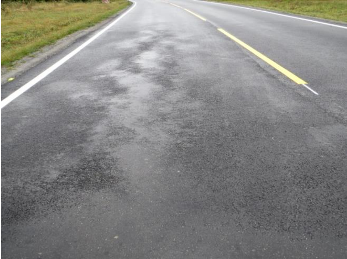
Konsekvens: Inhomogent dekke (foto: Jan Sundstrøm)
