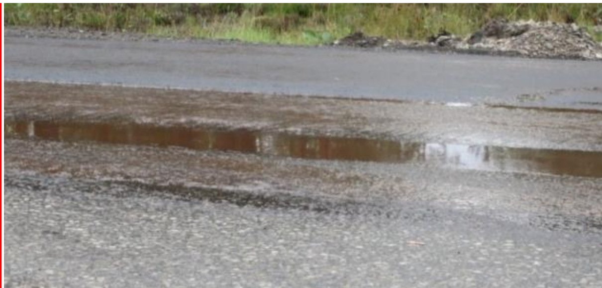
Feil: Vegbanen må være fri for fritt vann ved klebing (foto: Roar Telle)
