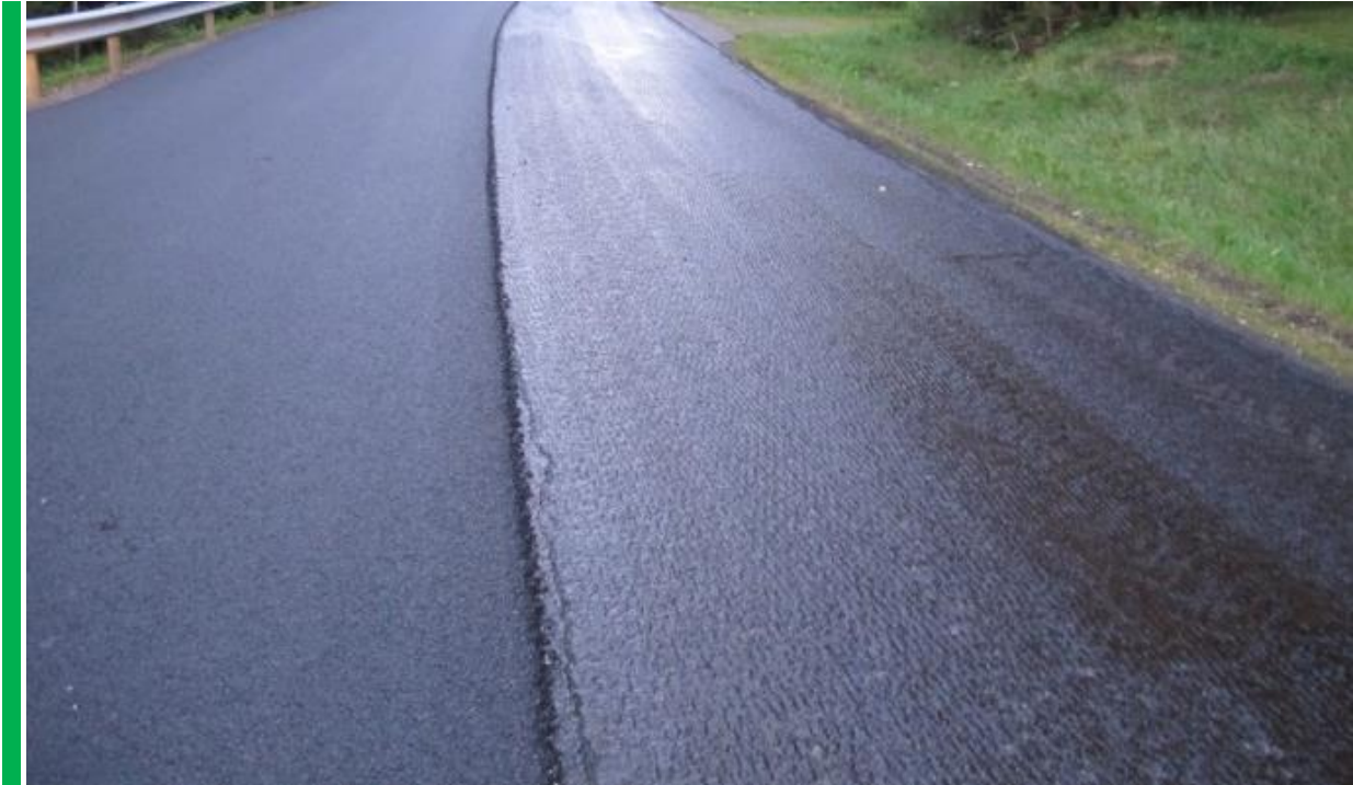
Riktig: Klebingen dekker hele arealet som skal asfalteres (foto: Frode Malmstrøm)
