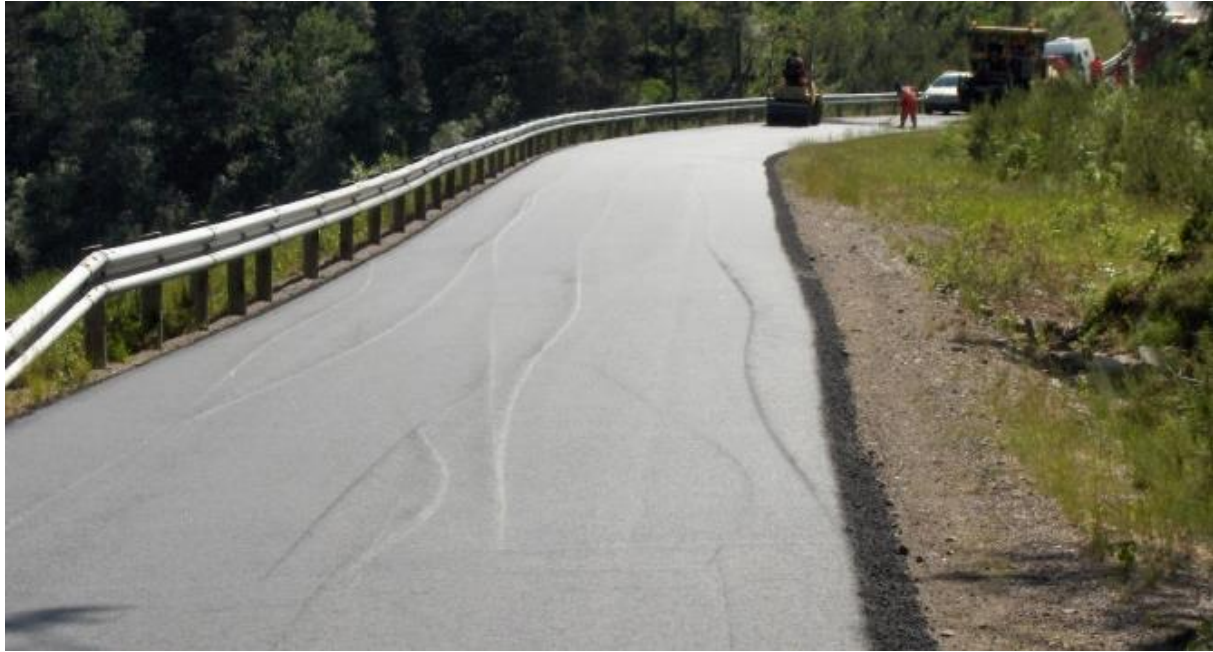
Konsekvens: Valsespor i dekke (foto: Bjørn Trygve Andersen)
