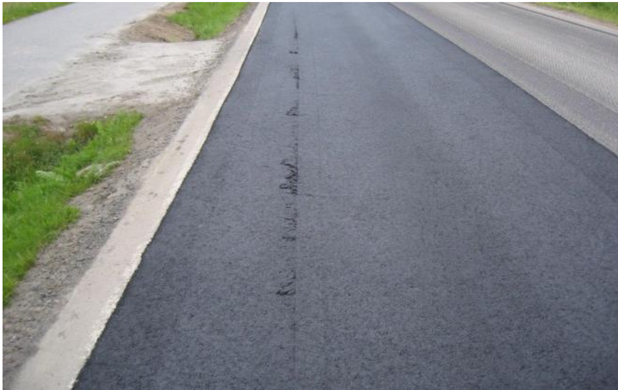
Konsekvens: Valsespor i dekke (foto: Bjørn Trygve Andersen)
