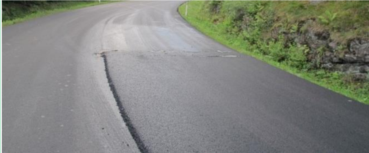
Riktig: Godt utført dagskjøt (foto: Frode Malmstrøm)
