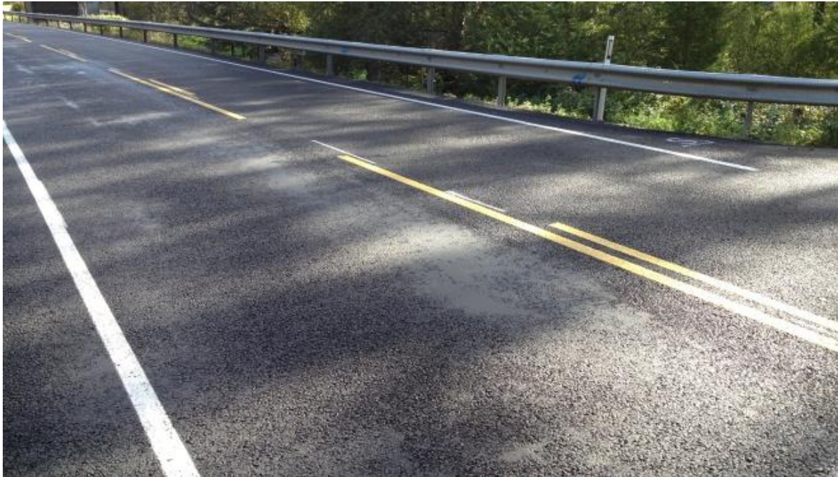
Konsekvens: Inhomogent dekke (foto: Johnny Stenshagen)
