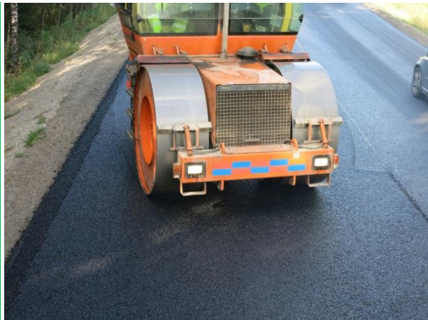
Riktig: Valsen gjør en sving bak utleggeren (foto: Roar Telle)
