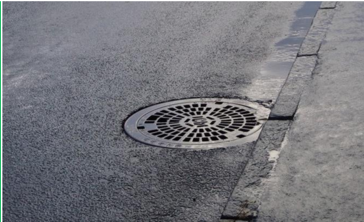
Riktig: Godt utført arbeid rundt kum (foto: Marit Fladvad)
