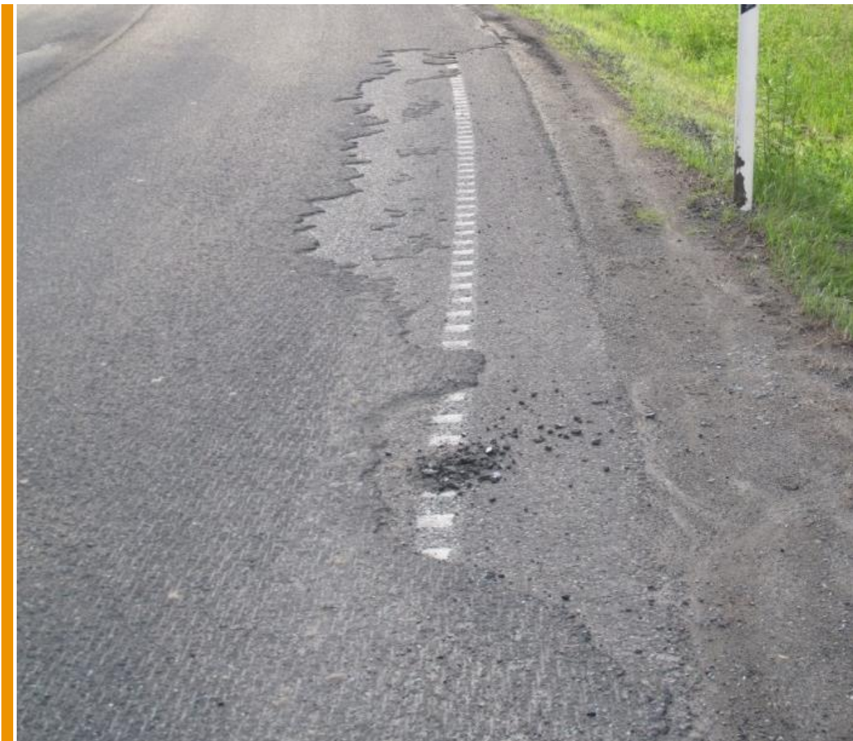
Konsekvens: Dårlig klebing blir synlig ved fresing av dekket (foto: Frode Malmstrøm)
