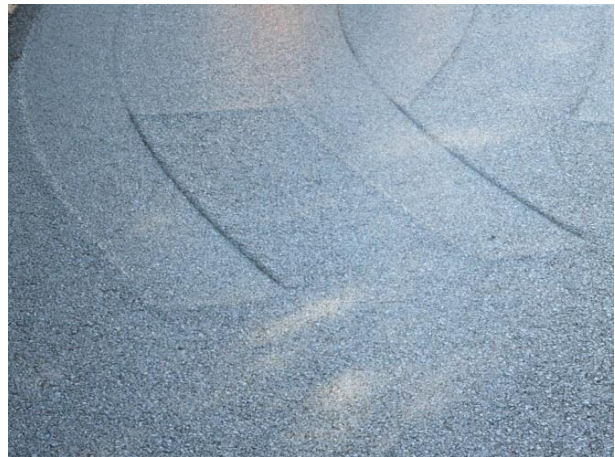
Riktig: En skrå valsestopp bak utlegger er lettere å jevne ut (foto: Roar Telle)
