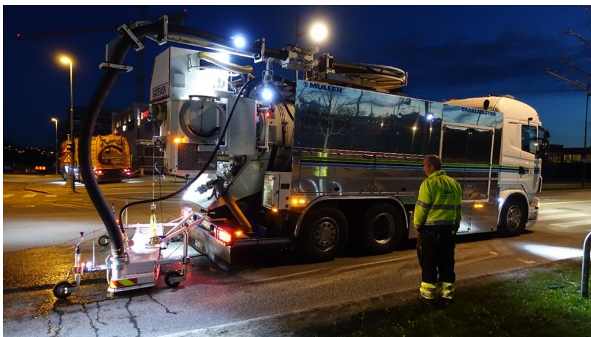
Figur 5: Egenutviklet høytrykksspyleenhet koblet på ordinær suge-/pumpebil (foto Dagfin Gryteselv)
