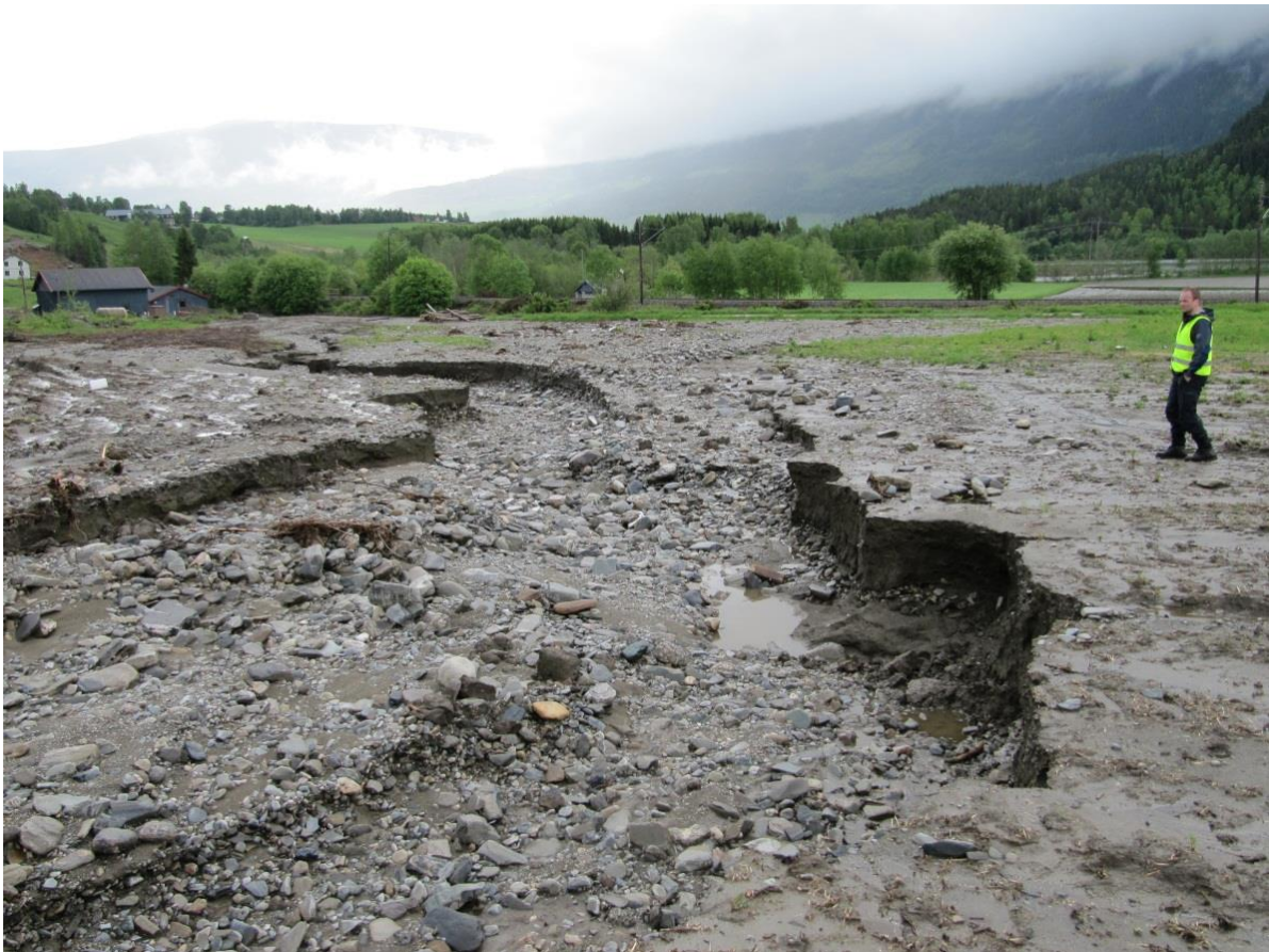
Figur 16: Stor utgraving nedstrøms Fv403, ca midt i linja til ny E6 ved Jota bru.
