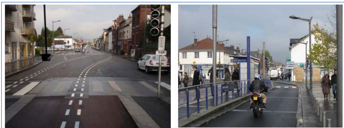
Figur 9 Bygate med bussprioritering og blandet trafikk i bykjernen, Rouen. Foto: Statens vegvesen
