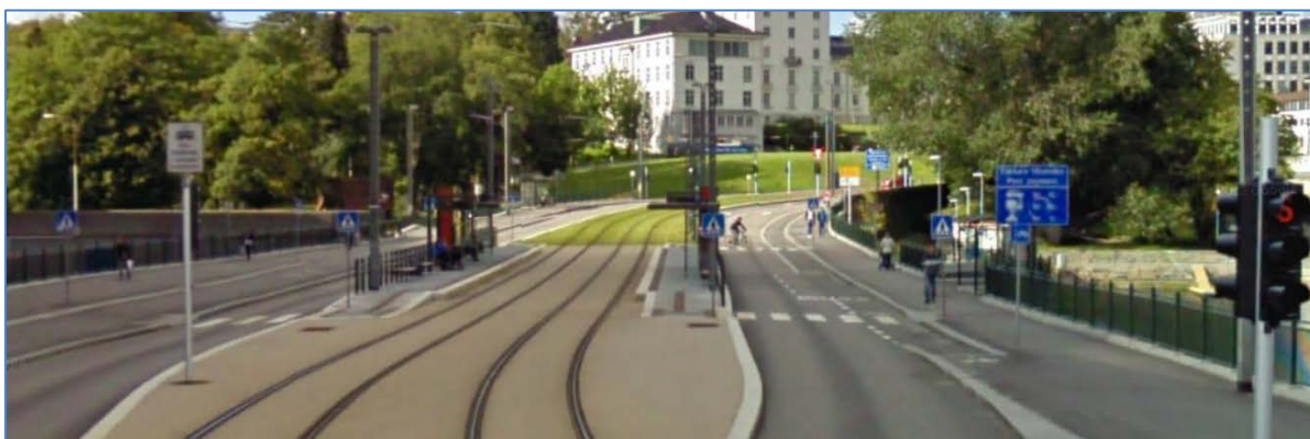
Figur 17 Florida holdeplass på midtstilt kollektivtrasé, Bybanen Bergen. Foto: Google maps
