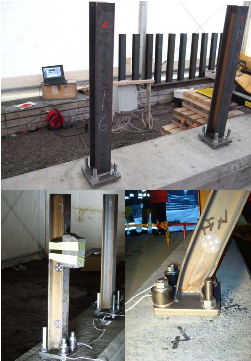
Figur 3.3: Bilde av HE100B stolper montert på kantbjelken.
