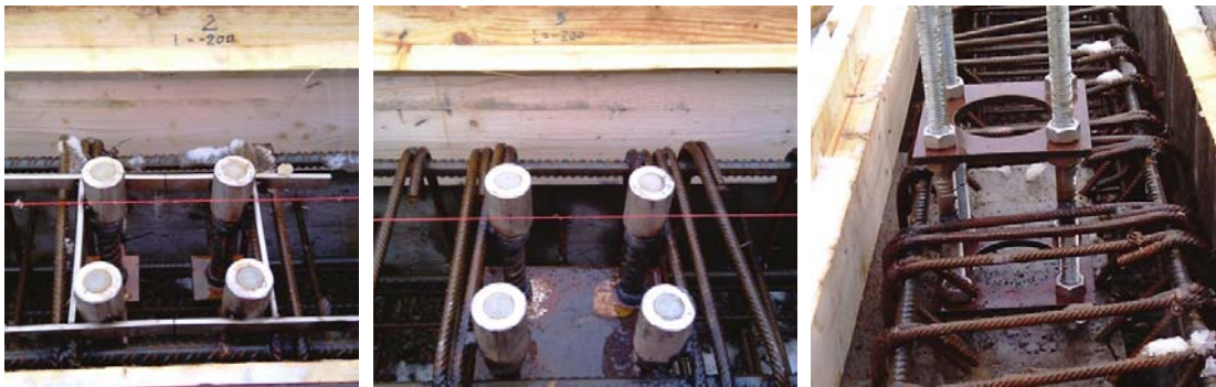
Figur 3.5: Innstøpte hylser og gjengestag med forankringsplate og T-hode.
