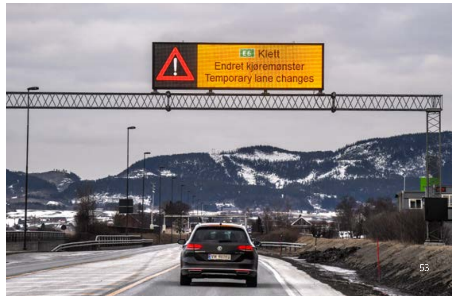
Friteksttavle varsler trafikantene om endret kjøremønster på E6 ved Klett Foto: Knut Opeide
