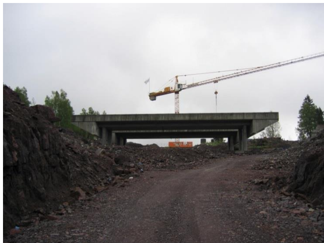
Figur 14 Landkarfri bru. Foto: Gaute Nordbotten, Statens vegvesen
