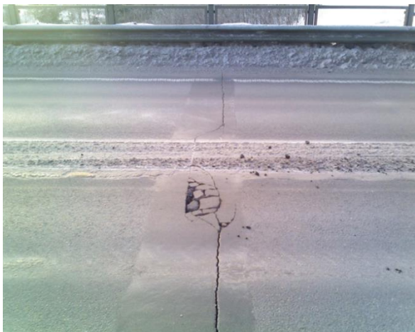
Figur 9 Asfaltfuge, Eikebergmyra vest. Foto: Gaute Nordbotten, Statens vegvesen
