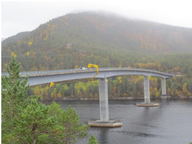
Figur 8 Inspeksjon av Mjosundbrua (1994) i Møre og Romsdal. Foto: Aas Jakobsen
