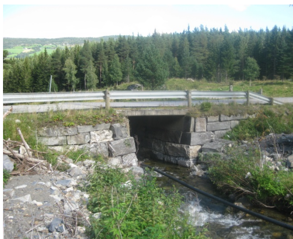
Ulberg bru – oppstrøms side
