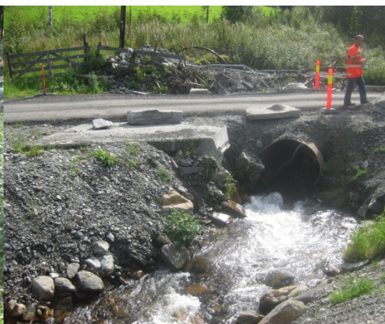
Nytt elveløp ved siden av brua lagt gjennom stålrør.
