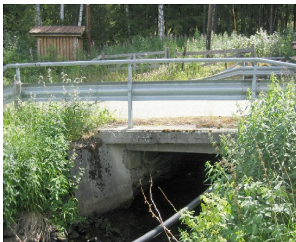
Haugland bru før flomskadene
