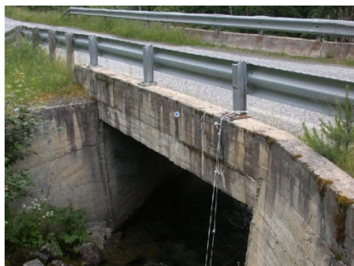
Sandbu bru før flommen inntraff
