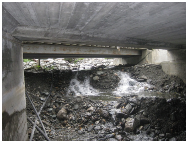
Elveløpet under utgraving. Kun 0,5 meter klaring til UK overbygning.
