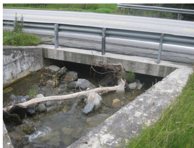
Oppfylling av løsmasser etter flommen 2011
