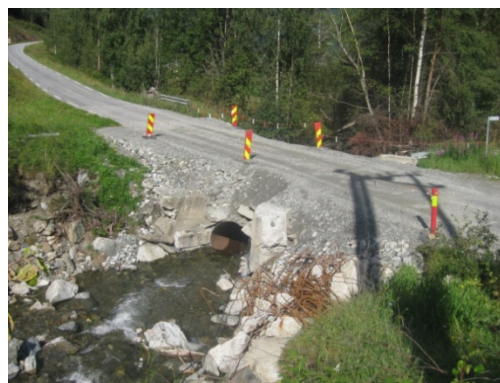
Brua tatt av flommen er erstattet med stålrør
