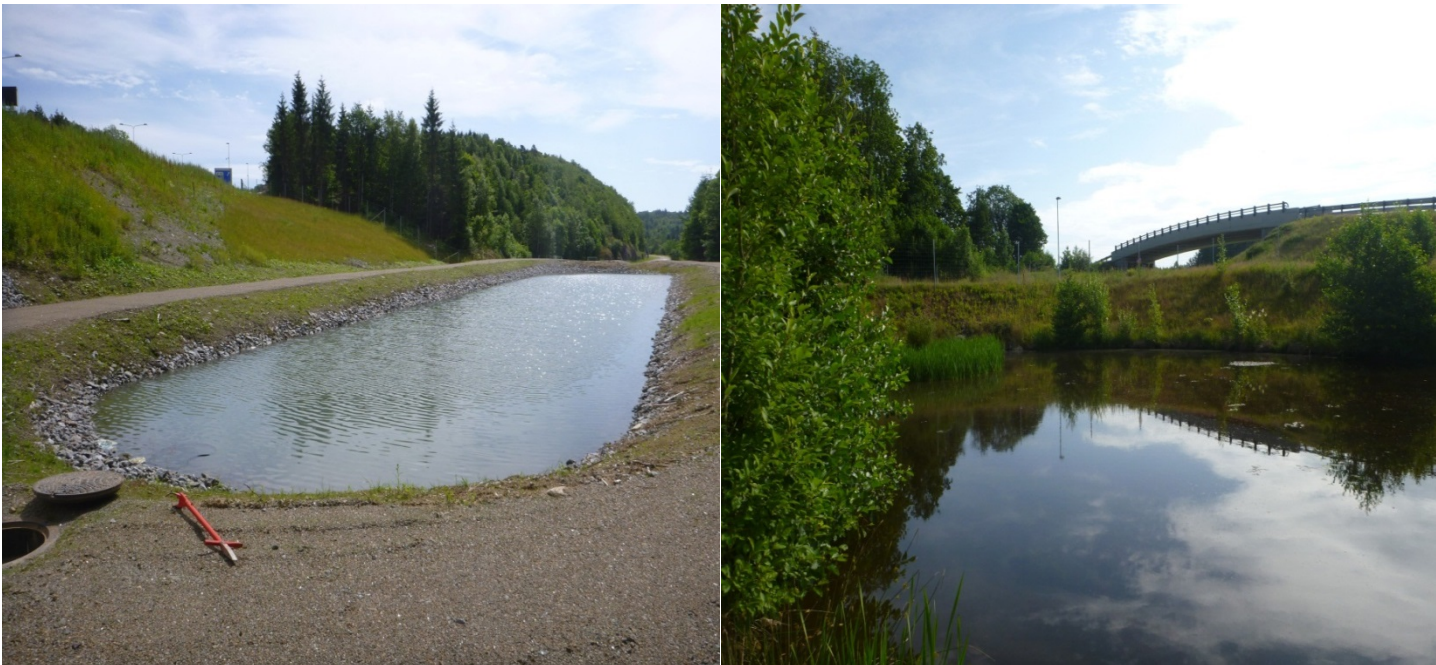
Figur 4 Eksempler på variasjon i tilgjengelighet for drift og ettersyn. Driftsvei rundt hele bassenget ved E18 Langangen Dam F resulterer i god tilgjengelighet (venstre). Dype og bratte sidekanter medfører dårlig tilgjengelighet til bassenget ved Riksveg 308 Emmerød (høyre).
