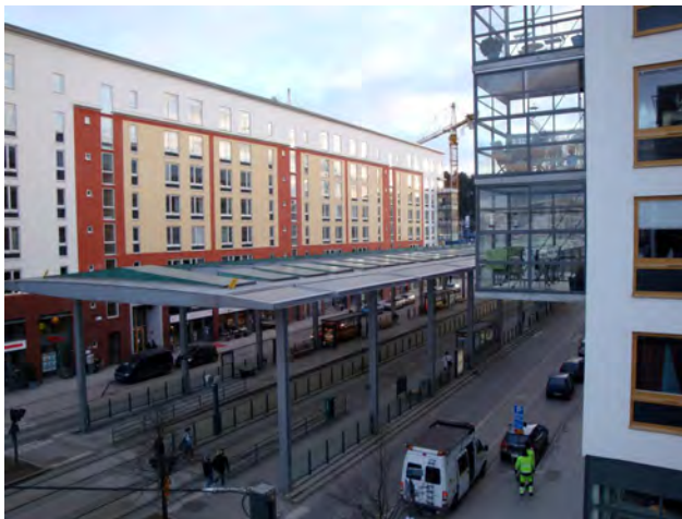
Foto: Eksempel fra overbygd T-bane stasjon i Stockholm
