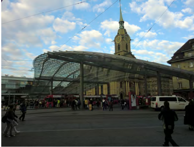
Foto: Eksempel fra Sveits med takoverbygg på bussholdeplass
