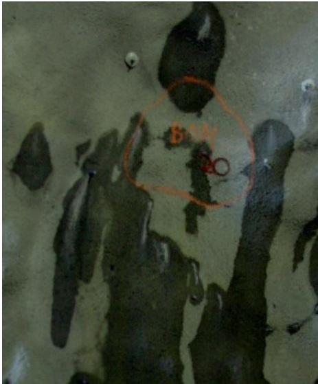
Figur12 Bom i sprøytebetong (Foto: A. Neby)
