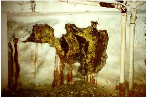
Figur 17 Eksempel på S6 utpressing pga. alunskifer. Fra kjellerrom i Oslo. (Foto: P. Hagelia)
