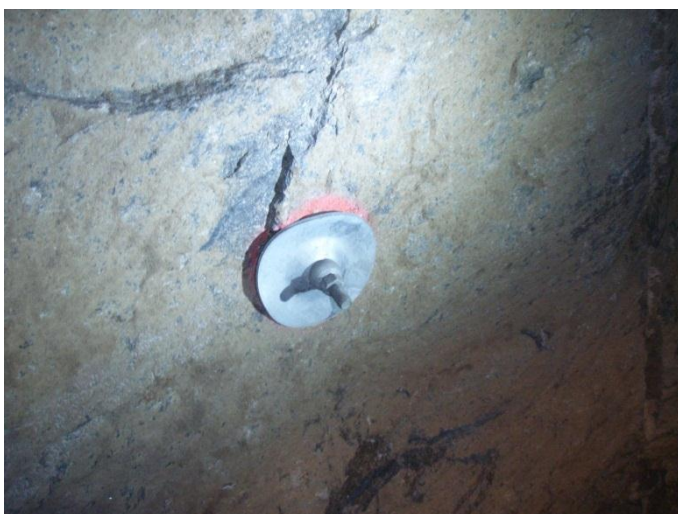
Figur27 Eksempel på B4 Deformasjon
