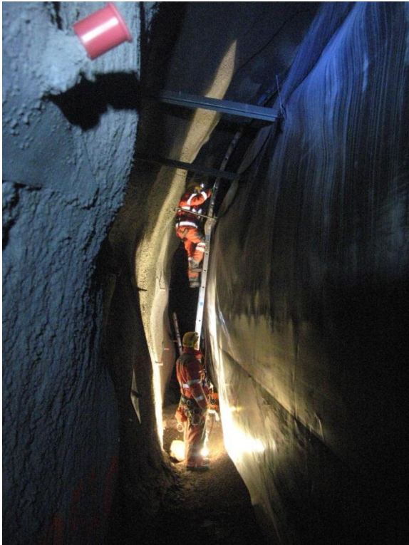
Figur 3.1 Inspeksjon bak hvelv i tunnel. Fra øvelse med test av utstyr. Merk sikret bolteende øverst til venstre i bildet. (Foto: B. Dolva)
