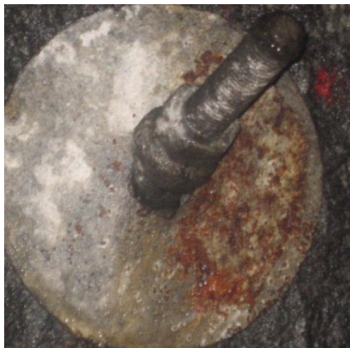
Figur 23 Eksempel på B1, rustgrad C (Foto: Region sør)
