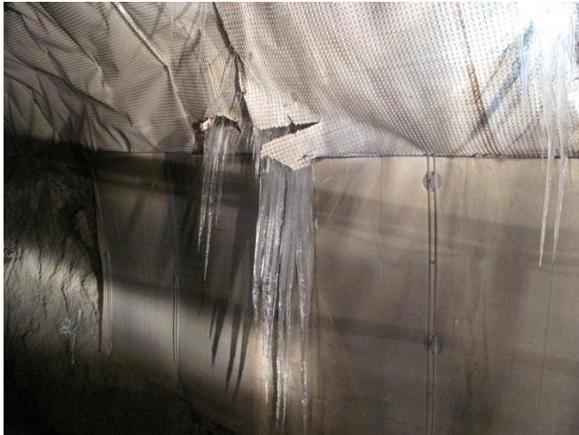
Figur 32 Eksempel på M4. Rift i vannsikring, med vannlecksjer og is i trafikkrommet. Geitryggtunnelen. (Foto: O.C. Ødegaard)
