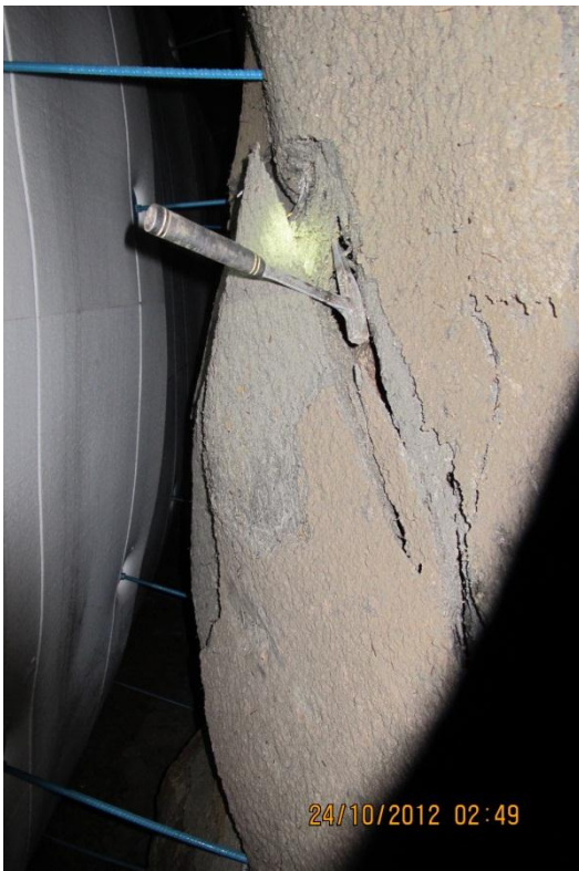
Figur16 Eksempel på S6 Utpressing pga svelleleire (Foto: O.C. Ødegaard)
