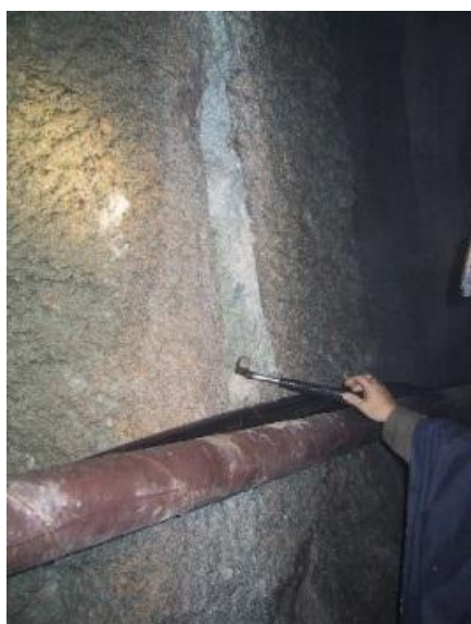
Figur8 Eksempel på F6 Utpressing pga svelleleire (Foto: A. Neby)
