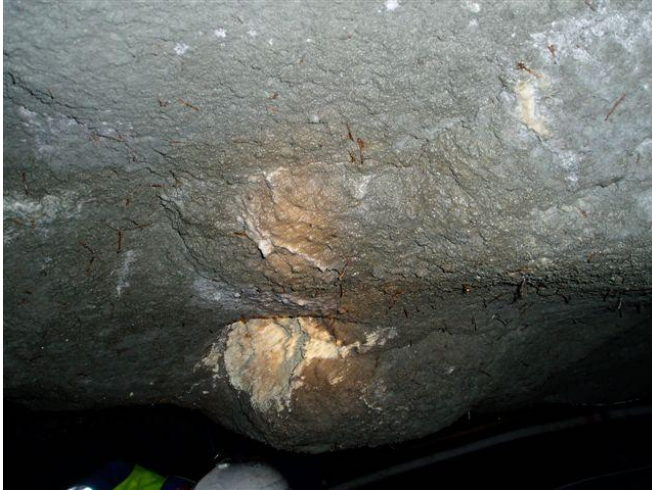
Figur15 Eksempel på S6 Utpressing pga svelleleire (Foto: E. Iversen)
