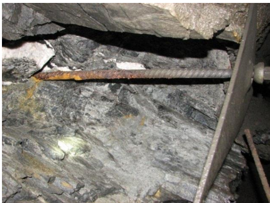
Figur26 Eksempel på B1, rustgrad E (Foto: A. Kveen)
