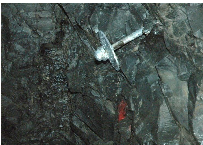
Figur 31 Eksempel på M2. Bolt uten feste (Foto: K. Klemetsrud)
