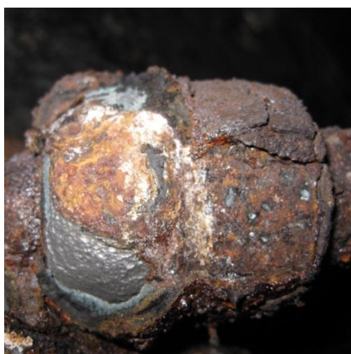
Figur 25 Eksempel på B1, rustgrad D Dyptgående korrosjon (Ellingsøytunnelen) (Foto: Region sør)
