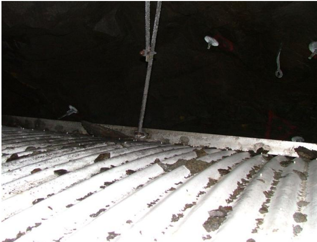
Figur 1 Eksempel på F1 Holmestrandtunnelen (bilde tatt fra takluke) (Foto: M. Lindstrøm)
