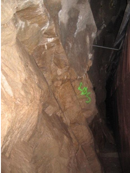
Figur 4 Eksempel på F3 Avløste blokker (Foto: A. Neby)
