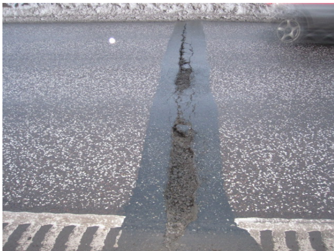
Figur 21 Bilde av en typisk asfaltfuge. Foto: Gaute Nordbotten, Statens vegvesen.
