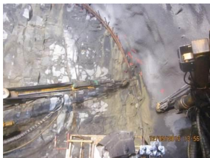
Montering av buer på stoff, foto: Terje Kirkeby (SVV)
