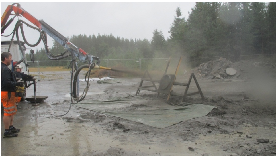
Figur 29: Fra sprøyting av prøveplater og registrering av prelltap ved Rescon Mapeis Shotcrete Test Centre i august 2012
