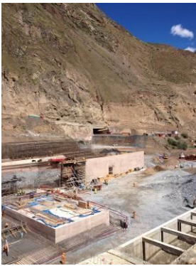
Betongarbeider, foto Jørgen Stenerud
