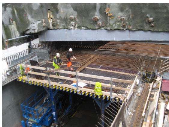
Figur 27 Armeringsarbeid takplate, ved overgang betongtunnel/berg tunnel, Strindheimtunnelen. Foto: Statens vegvesen, E6 Trondheim-Stjørdal.
