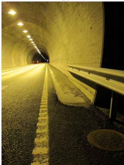
Figur 18 Eksempel på god avfasing av betongskulder
