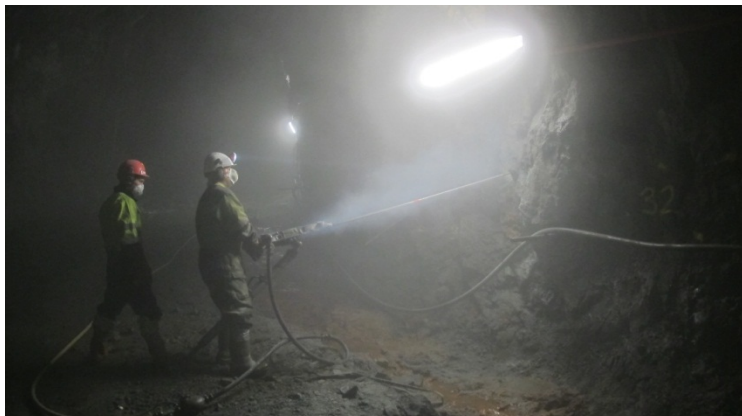
Figur 14 Etablering av testfelt i en sidetunnel i Oslofjordtunnelen. Boring av boltehull ble utført av FJELL Renovering as
