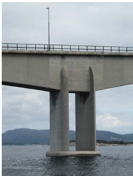
Figur 10 Bakkasundet bru, åpnet i 1999. Foto: Claus K. Larsen, Statens vegvesen
