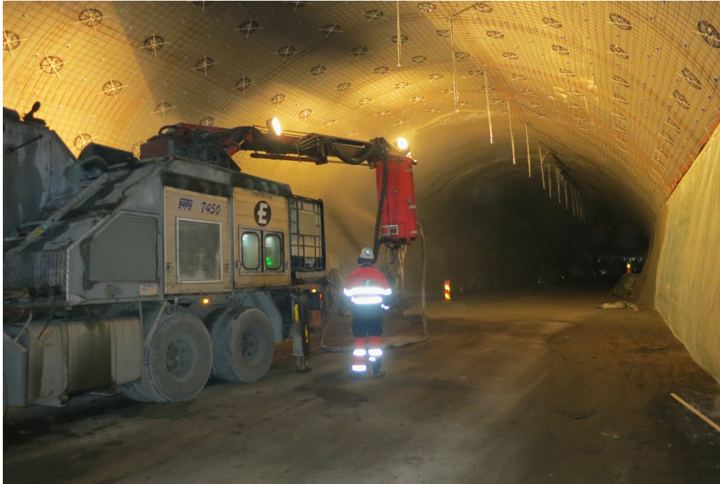
Figur 6: Sprøyting av betong med brannsikringsfibre i Nestunnelen (Foto: Hedda Vikan 2013)
