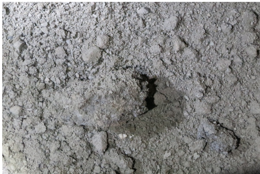
Figur 8: Prelltap fra sprøytebetong med brannsikringsfibre. Fibrene er ikke løse, men bundet av betongen. Bildet er tatt under sprøytearbeider i Nestunnelen (Foto: Hedda Vikan 2013).
