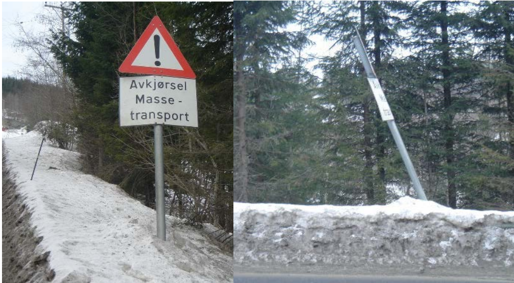
Figur 7-16 Skade på skilt
