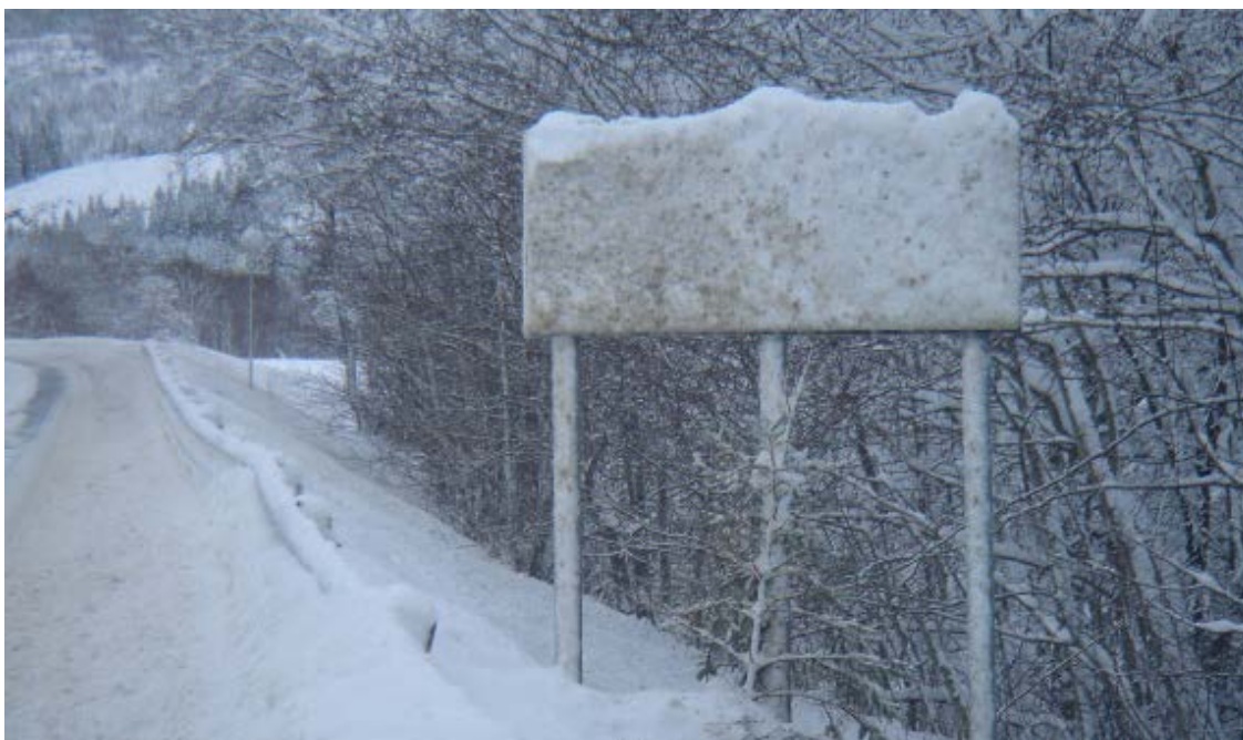
Figur 7-7 Snø på skilt som følge av sprut etter brøyting.
