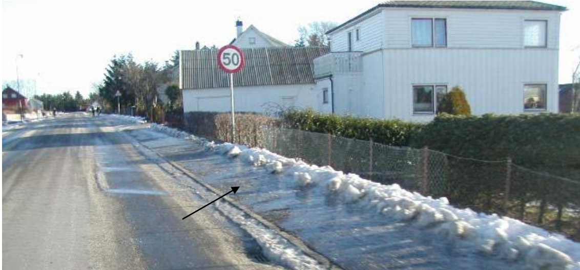
Figur 4-44 Eksempel på uheldig utførelse av brøyting av fortau
