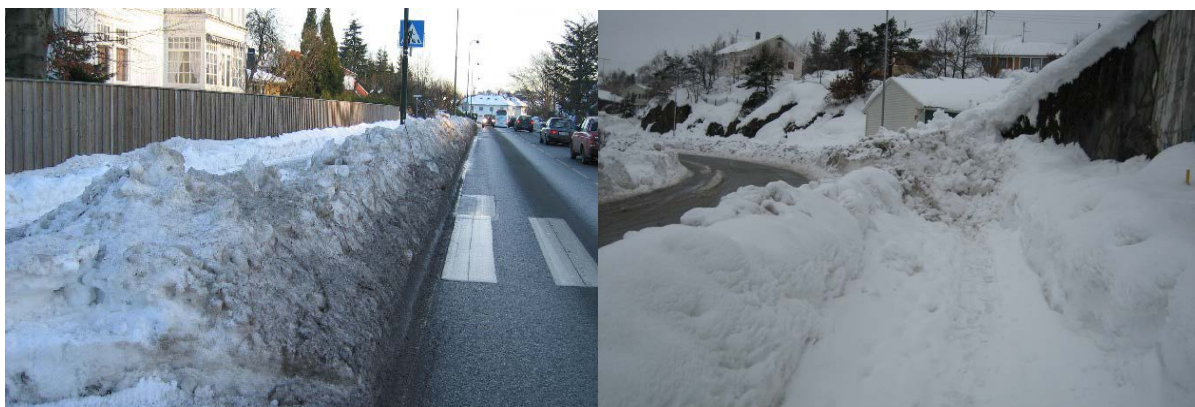
Figur 7-11 Eksempler på dårlig/mangelfull snørydding (avvik!) (Foto: Arild Nærum)
