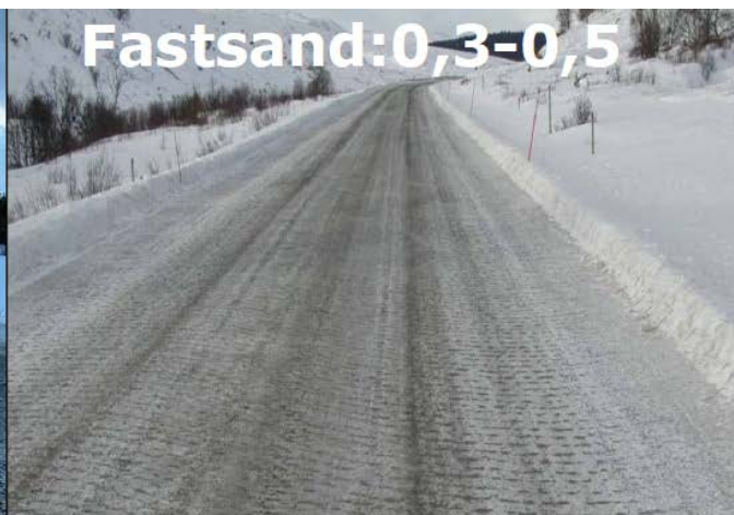
Figur 5-4 Friksjon på veg med isdekke strødd med sand og fastsand
