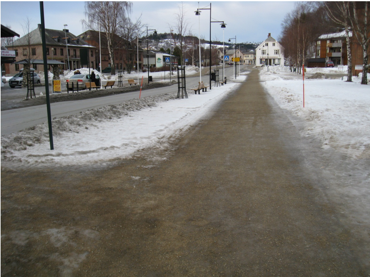
Figur 5-1: Eksempel på strøing av G/S-veg
