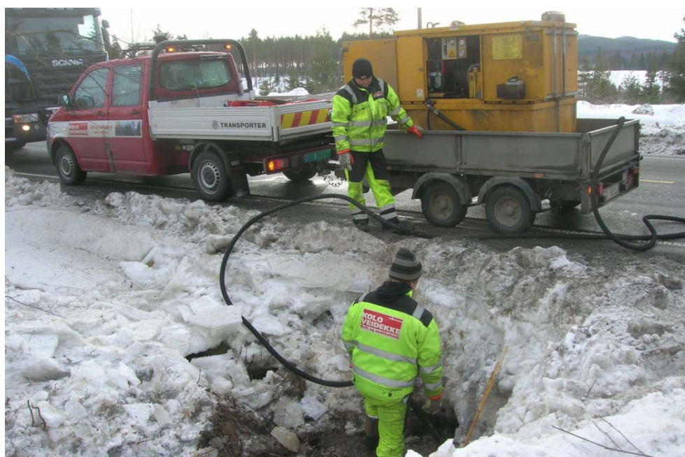
Figur 7-2 Tining av stikkrenne
