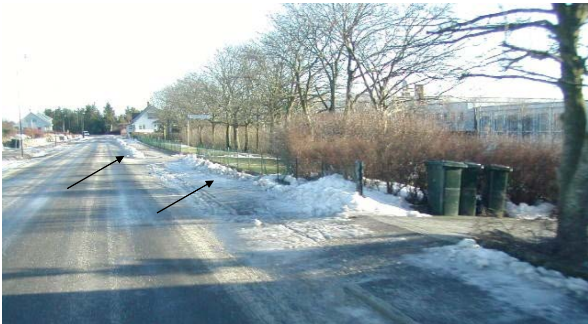
Figur 4-45 Lengst bort i bildet ser vi eksempel på riktig utførelse av brøyting av fortau
