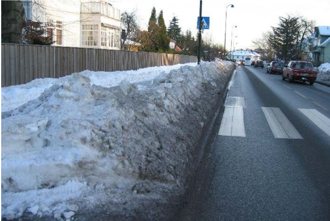
Figur 4-41 Fotgjengerovergang – enkelt å passere? (kilde: Arild Nærum)
