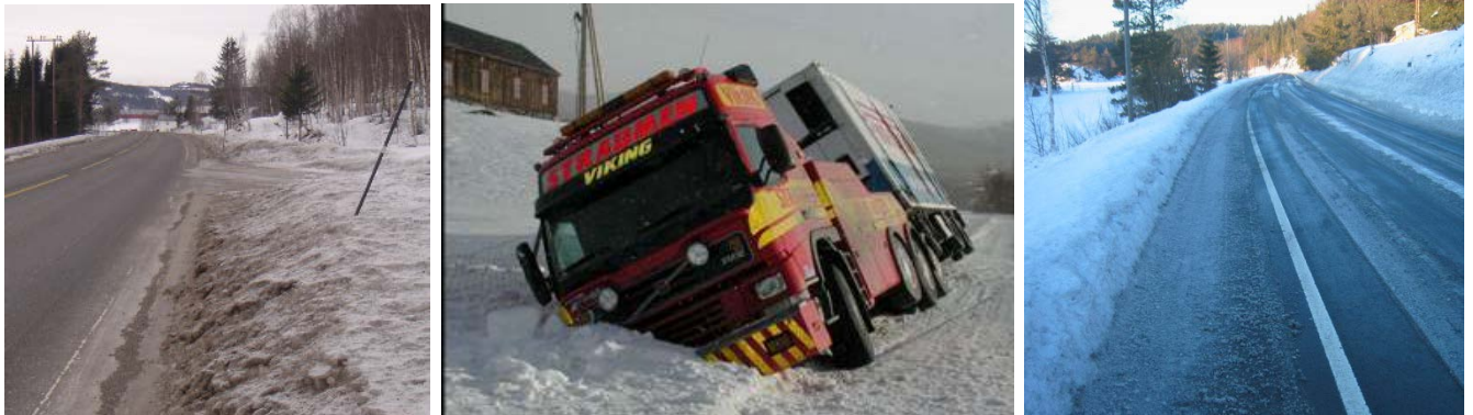
Figur 7-6 Feilaktig plasserte og manglende brøyttestikk kan føre til ulykker
