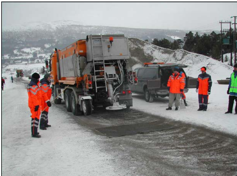
Figur 5-23 Kontroll av utstrødd mengde strømateriale
