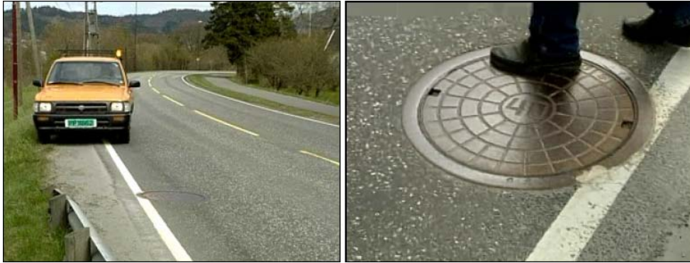
Figur 4-2 En bør stoppe opp å kontrollere kumlokk som ligger utsatt til
