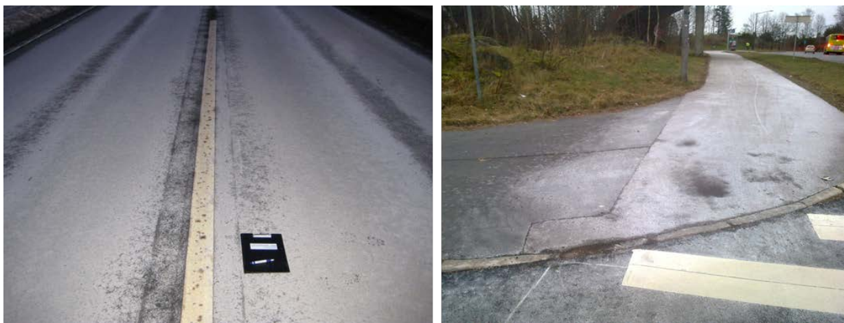
Figur 6-3 Eksempel på oversaltet veg
