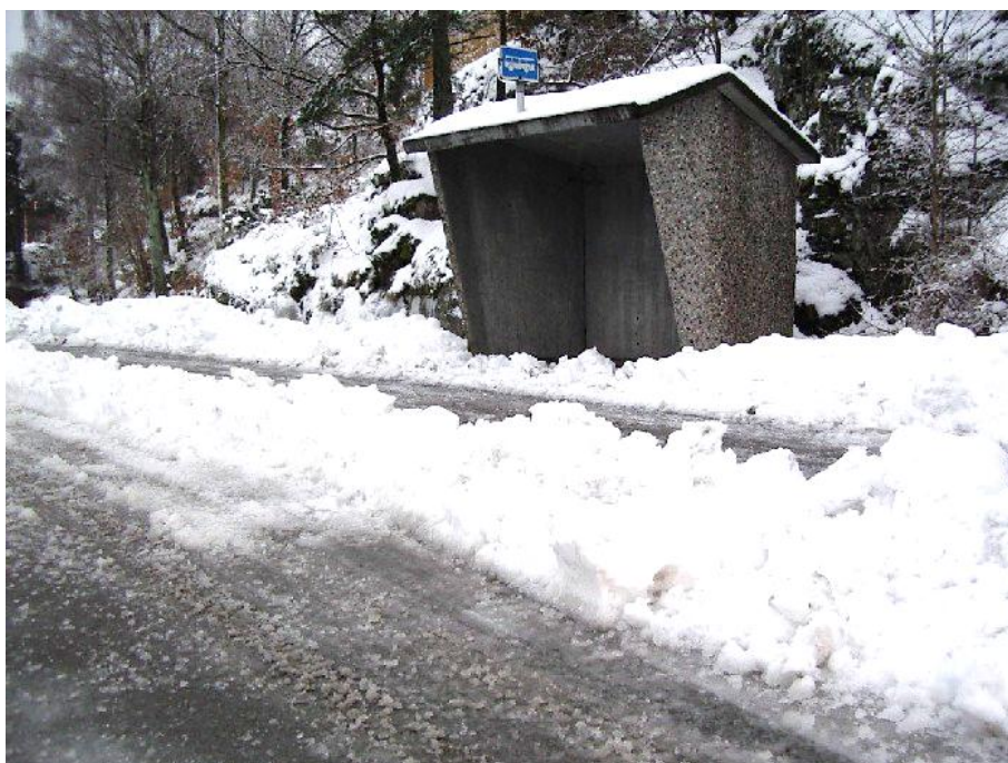
Figur 7-9 Mangelfull rydding foran leskur (Foto: Arild Nærum)
