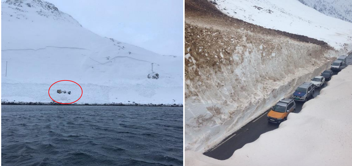
Figur 13: Eksempler på terrengfeller ved skred på veg. T.v. er en hjullaster ført nesten på havet ved E69 som var stengt ved Nordmannset i mars 2017 (foto: Avinor Honningsvåg). T.h. er et skredområde gravd/frest opp og trafikken satt på igjen etter skred i Kvasdalen i Voss i april 2015. Her er brøyte-/fresekanten en terrengfelle (foto: Tore Humstad).
