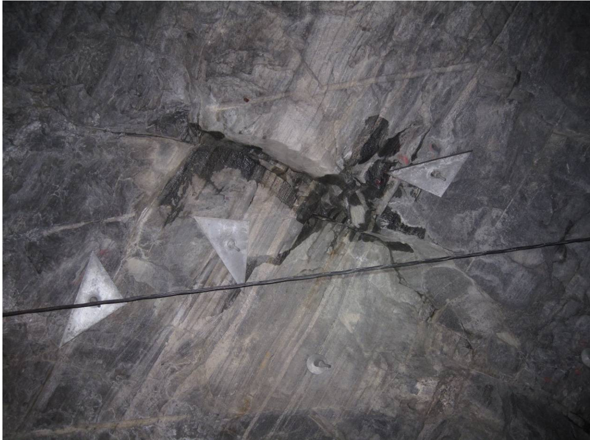
Figur 1.9-7 Spredt fukt – ingen misfarging av bolter
