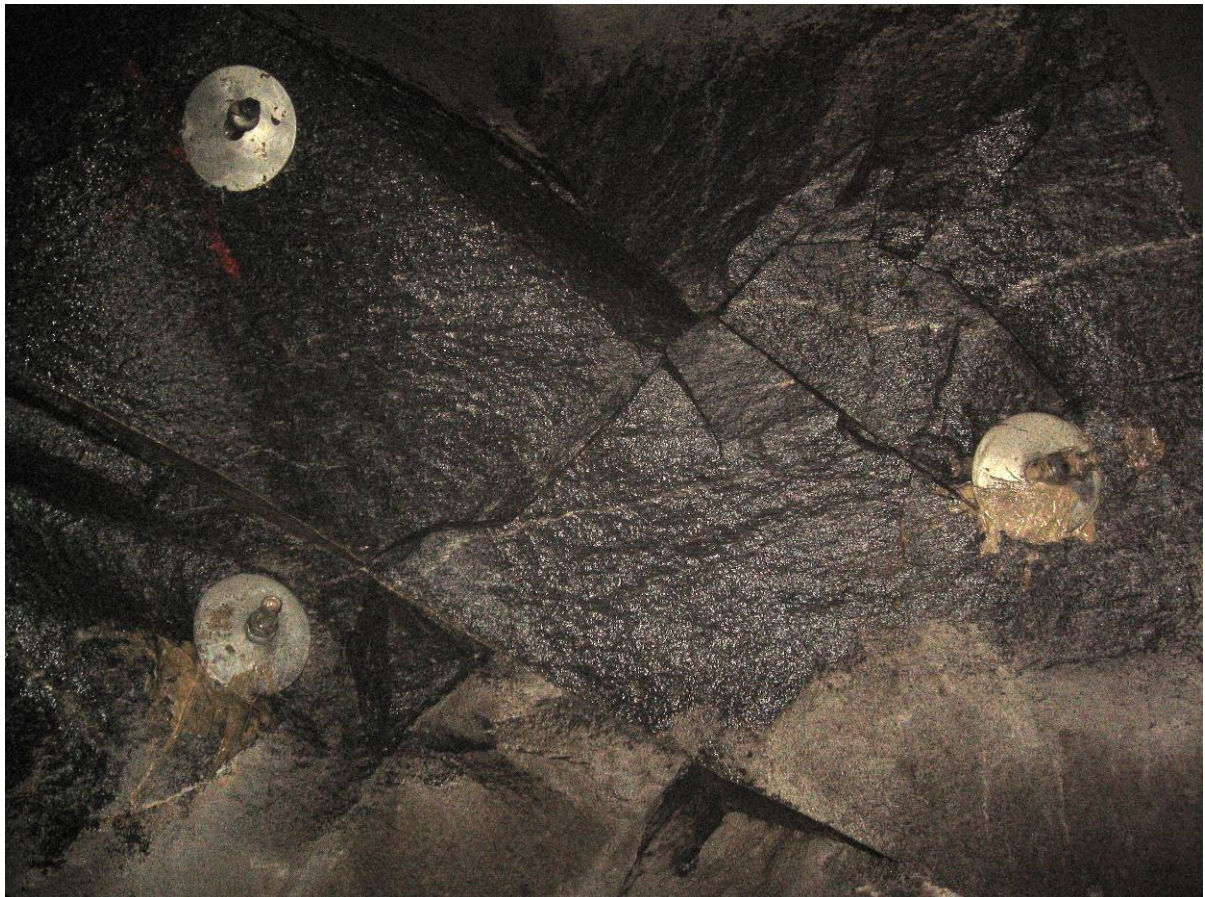
Figur 1.6-10 Bolter i heng uten synlig korrosjon. Synlig fukt på berg
