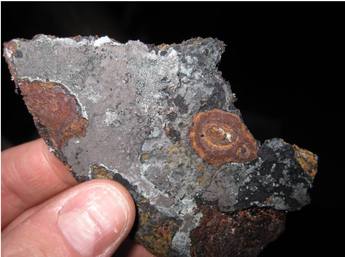
Figur 1.4-18 Avslått korrosjonslag, Bolt 4. Bakside. Synlig grått sinklag?
