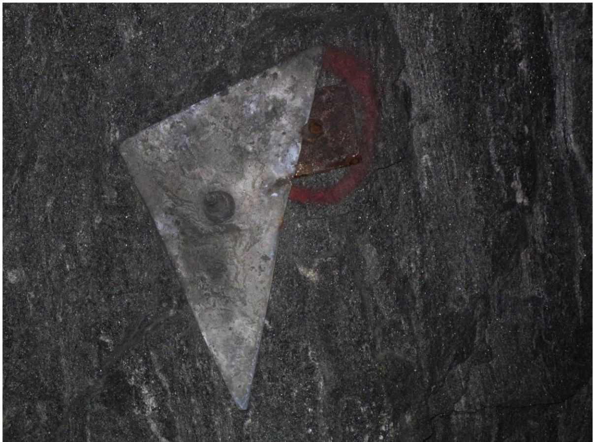
Figur 1.11-8 Ny bolt montert oppå gammel
