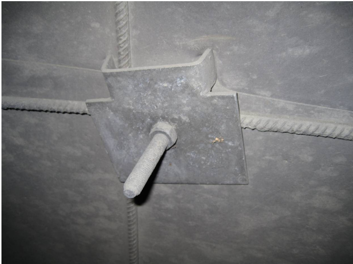
Figur 1.8-1 Festemateriell for vann- og frostsikring i portal
