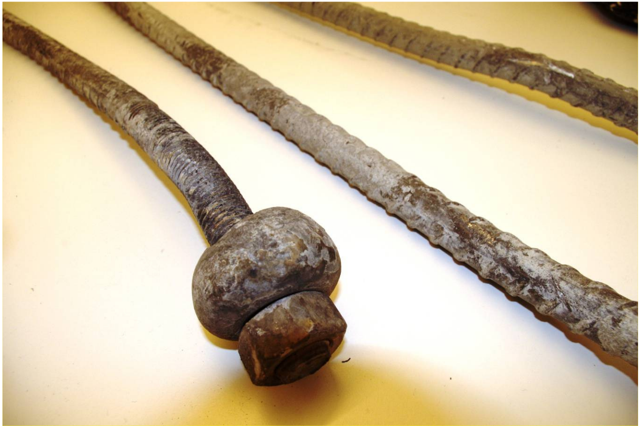
Figur 3.2-4 Frisprengt kamstålbolter – nisje 4 o g 5
