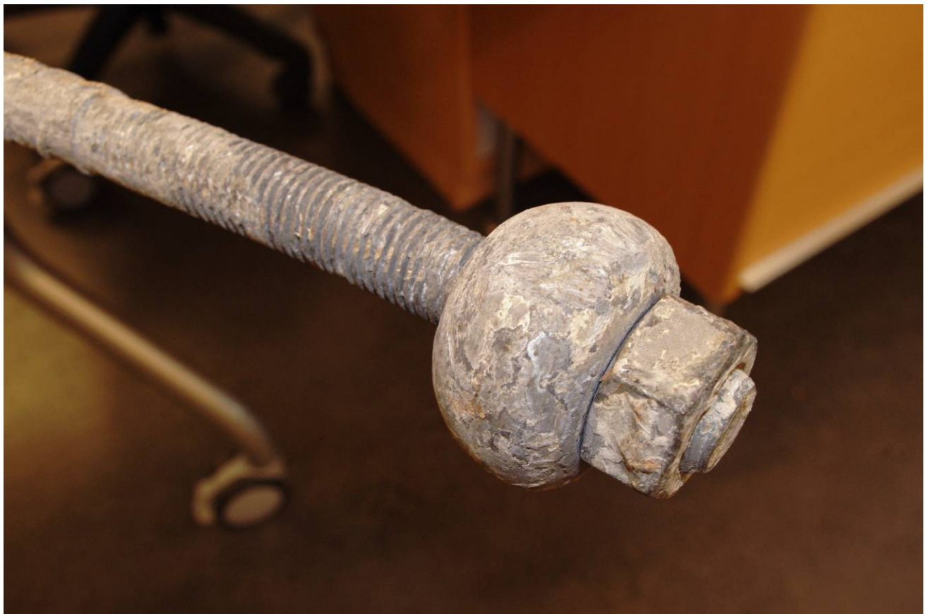
Figur 3.2-3 Frisprengt kamstålbolt fra Øksfjordtunnelen
