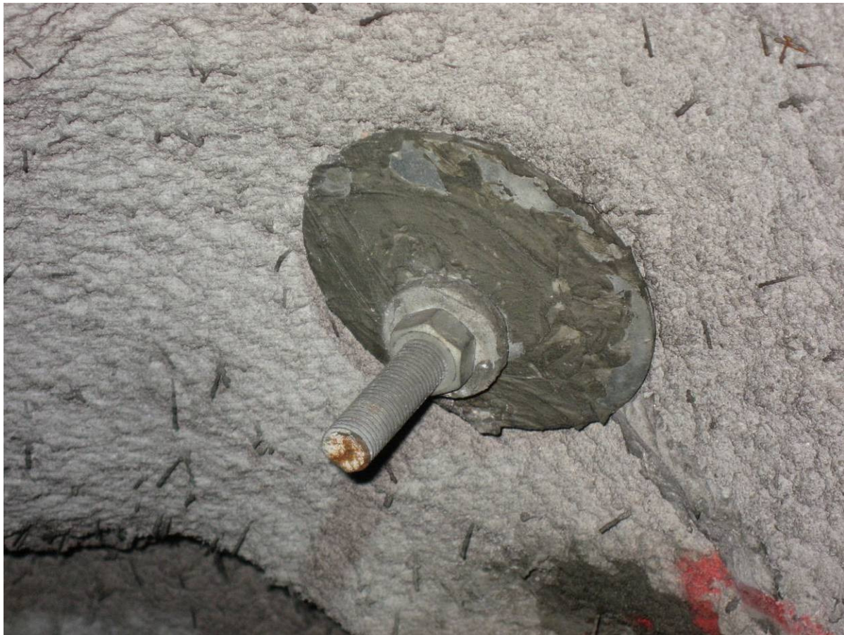
Figur 1.12-1 Farging av bolteende på varmforsinket bolt. Gysemasse på bolteskive
