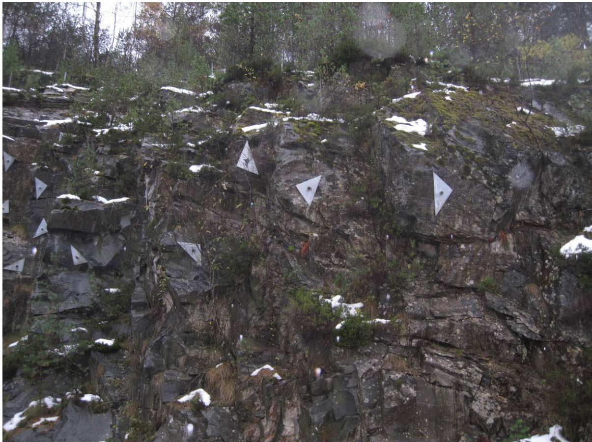
Figur 1.7-1 Bolter i påhugg mot Ålesund. Ingen korrosjon å se.
