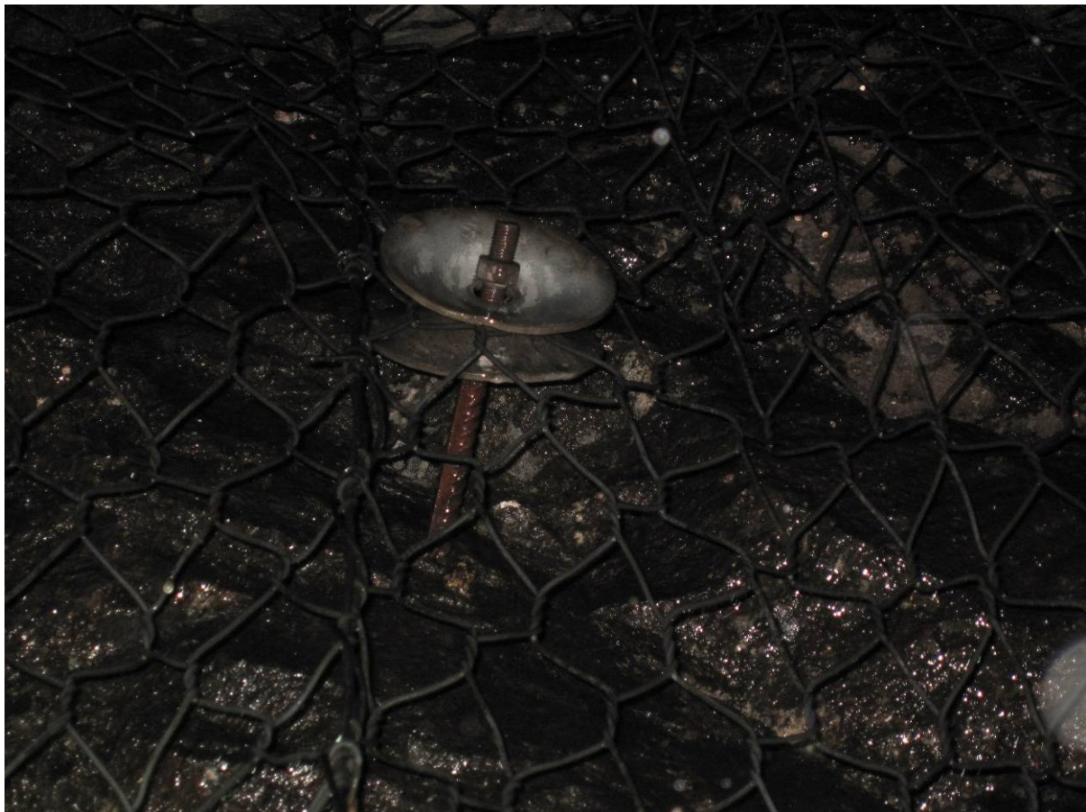
Figur 1.9-4 Overflatekorrosjon på bolt og misfarging av skiver
