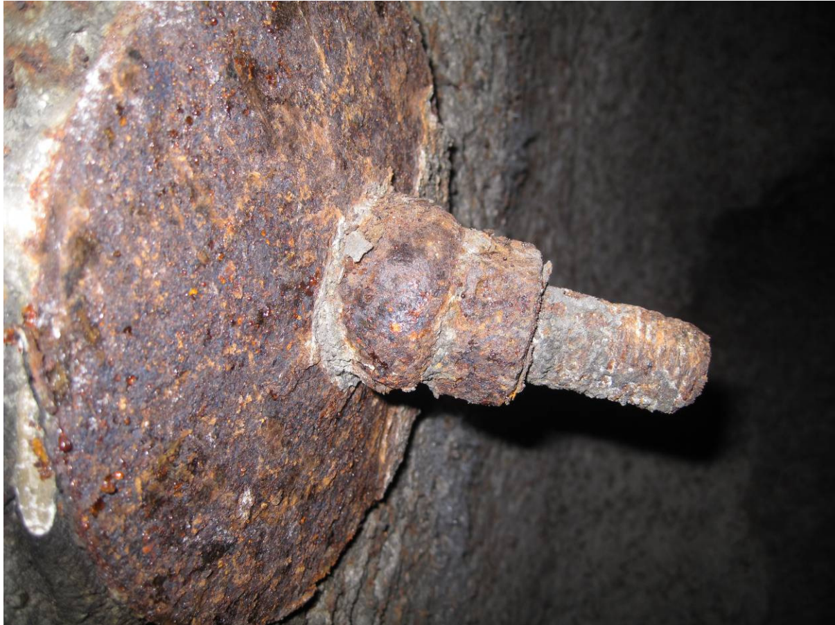
Figur 1.5-9 Bolt 6. Etter at sprøytebetong er fjernet fra bolt.
