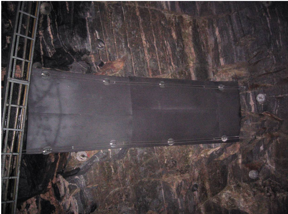
Figur 1.6-12 Bolter og vannsikring i heng – få eller ingen tegning til korrosjon, noe mørtelsøl på bolteskiver
