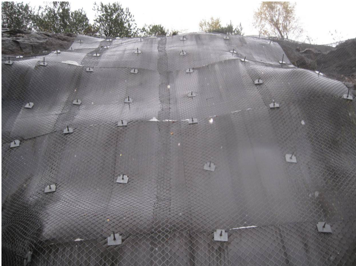
Figur 1.7-2 Vannsikring i påhugg mot Ålesund. Ingen korrosjon å se på festebolter eller flettverksnett
