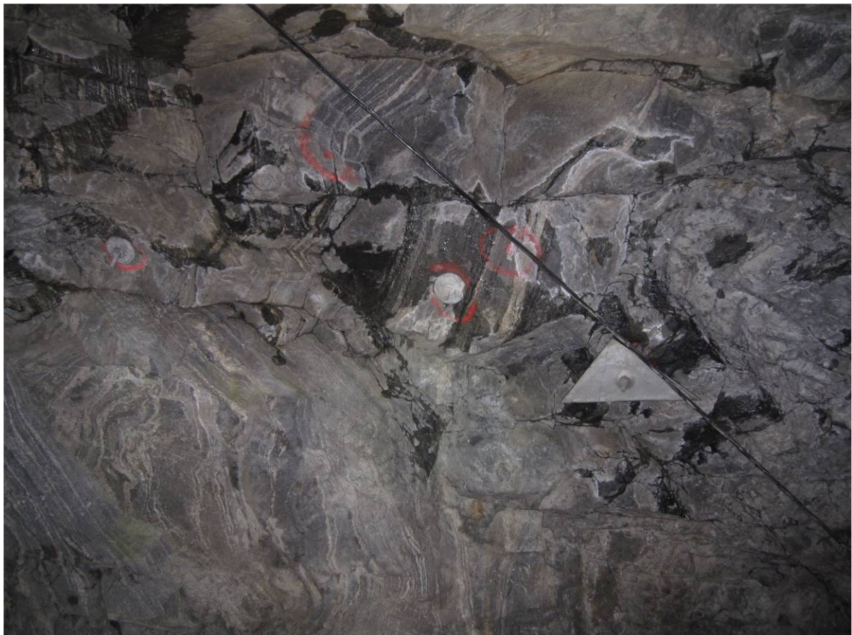
Figur 1.9-6 Ingen korrosjon å se på bolter
