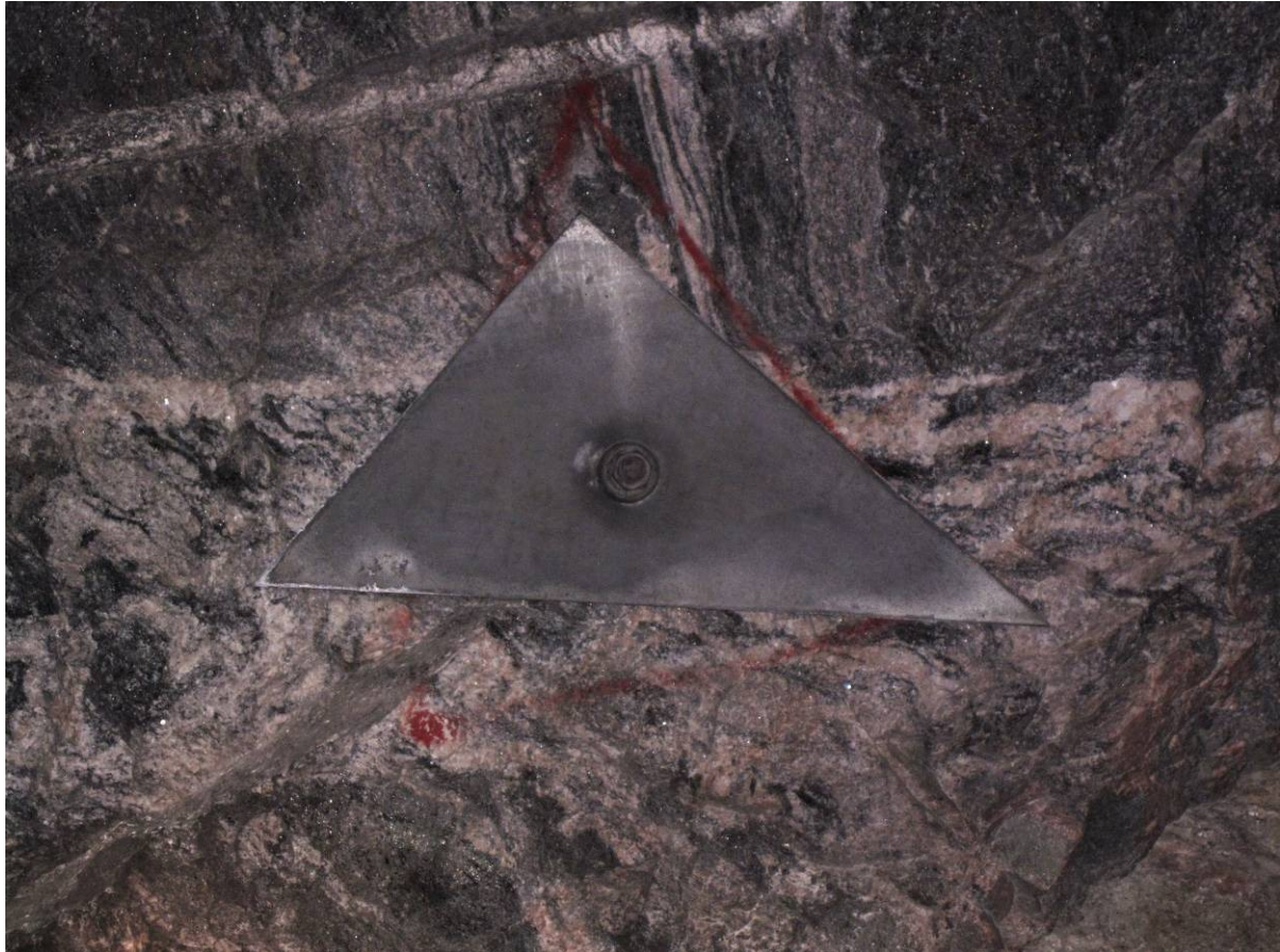
Figur 1.8-3 Ingen antydning til korrosjon
