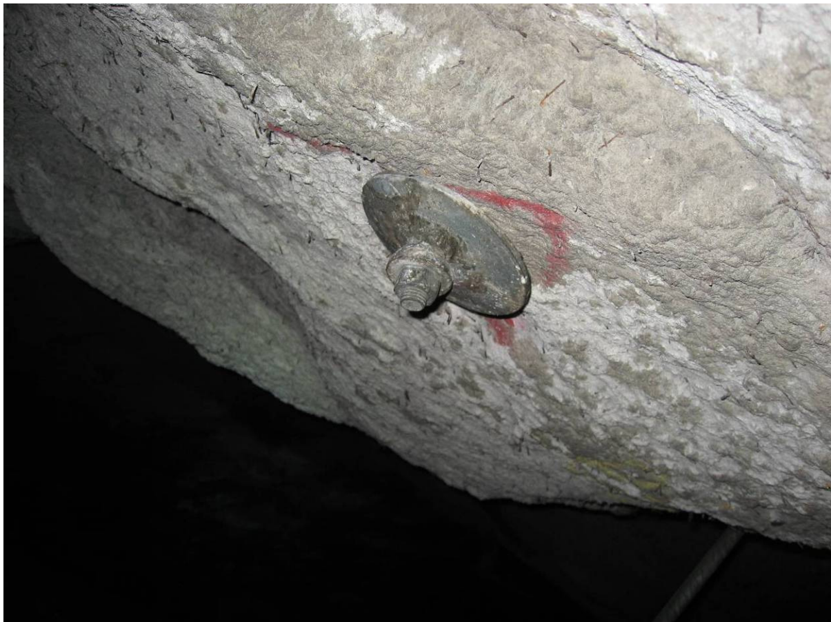
Figur 1.12-4 Ikke noe korrosjon å se
