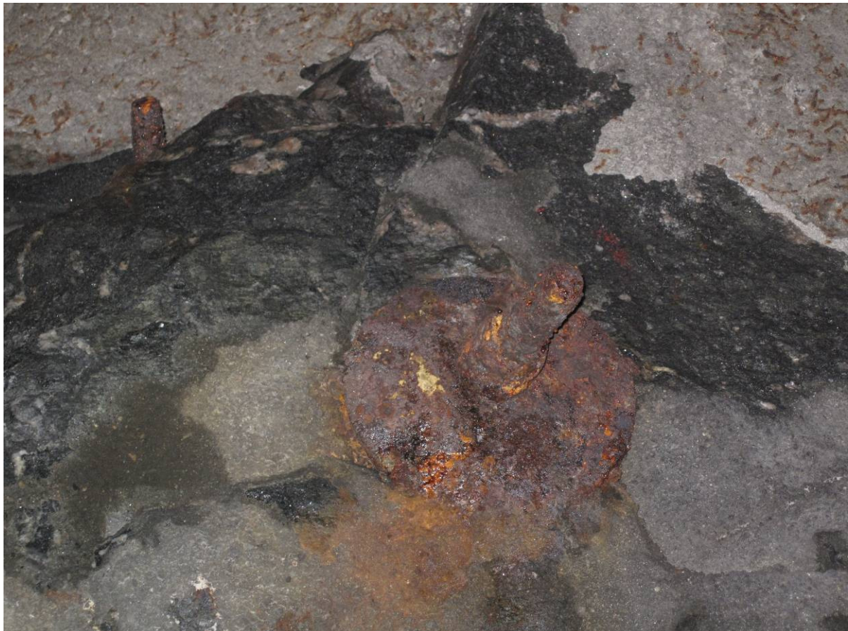
Figur 1.4-24 Bolt 6. Fullt innstøpt bolt i bakkant.
