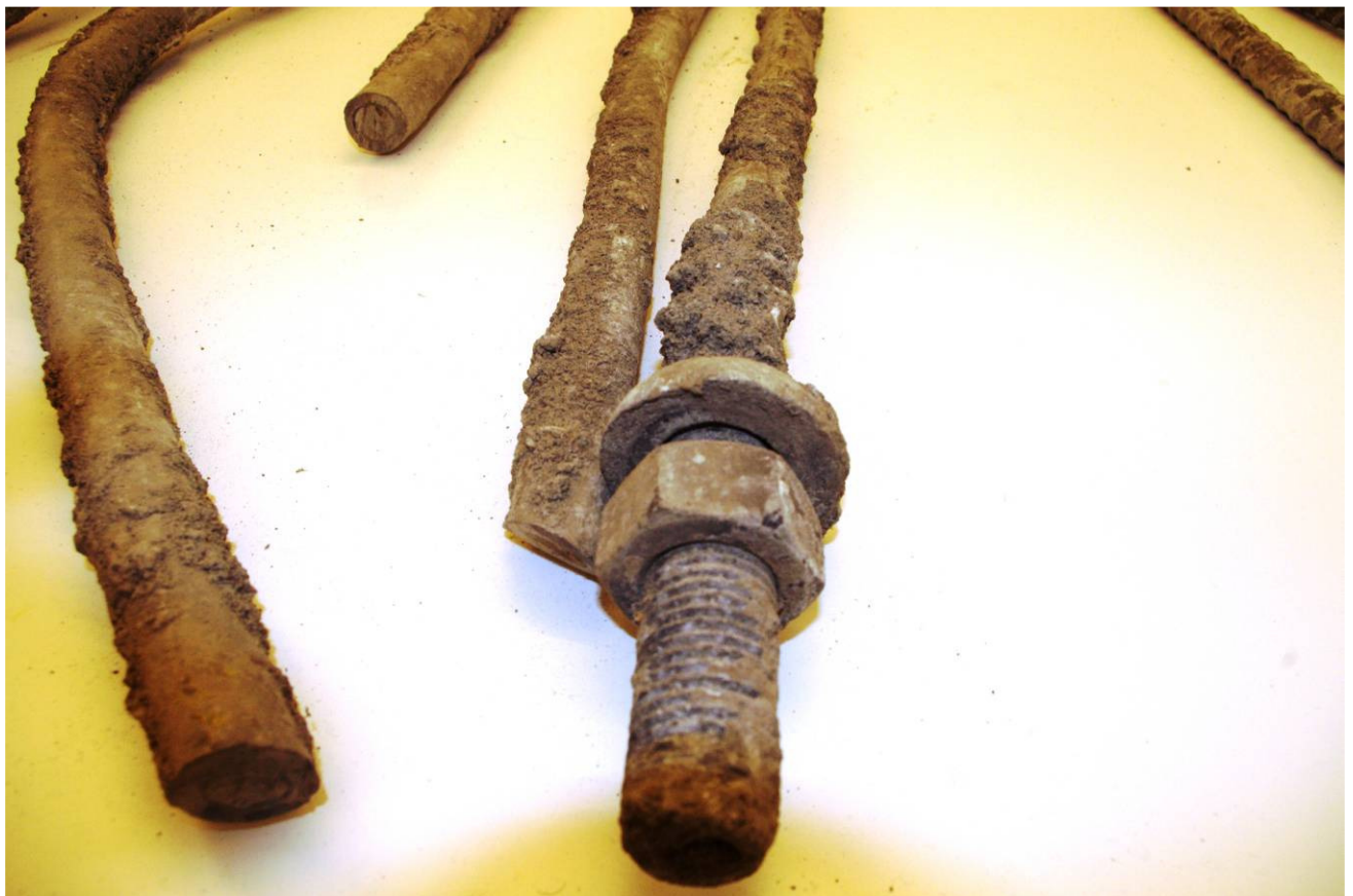
Figur 3.1-7 Rørbolter fra Kvalsundtunnelen tildekket med sprøytebetong
