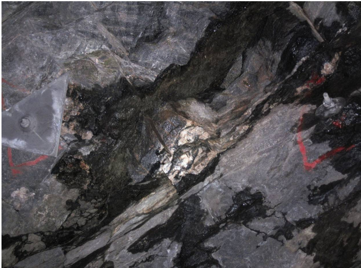
Figur 1.8-8 Ikke noe rust å se her heller, selv om bolt står rett ved fuktig parti
