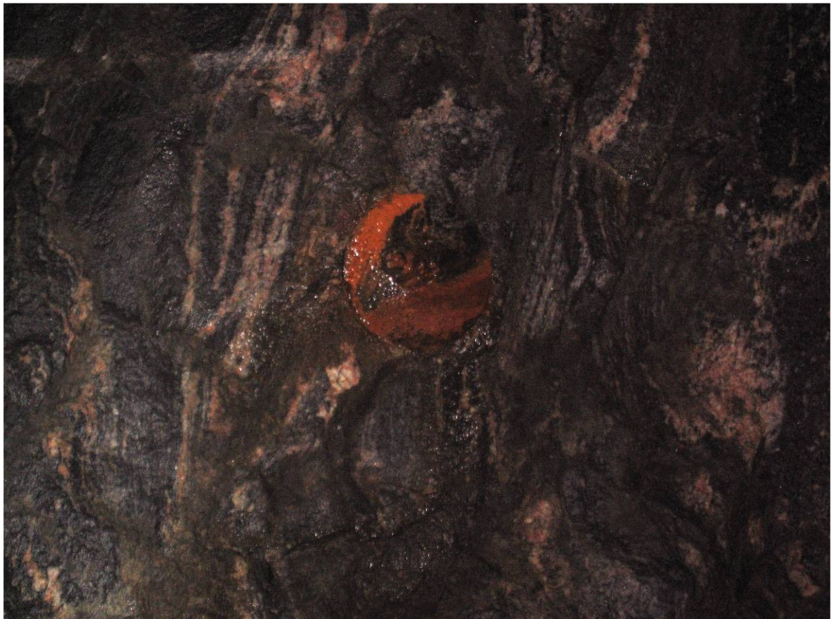
Figur 1.6-40 Bolt som står fuktig til. Helt dekket av korrosjon
