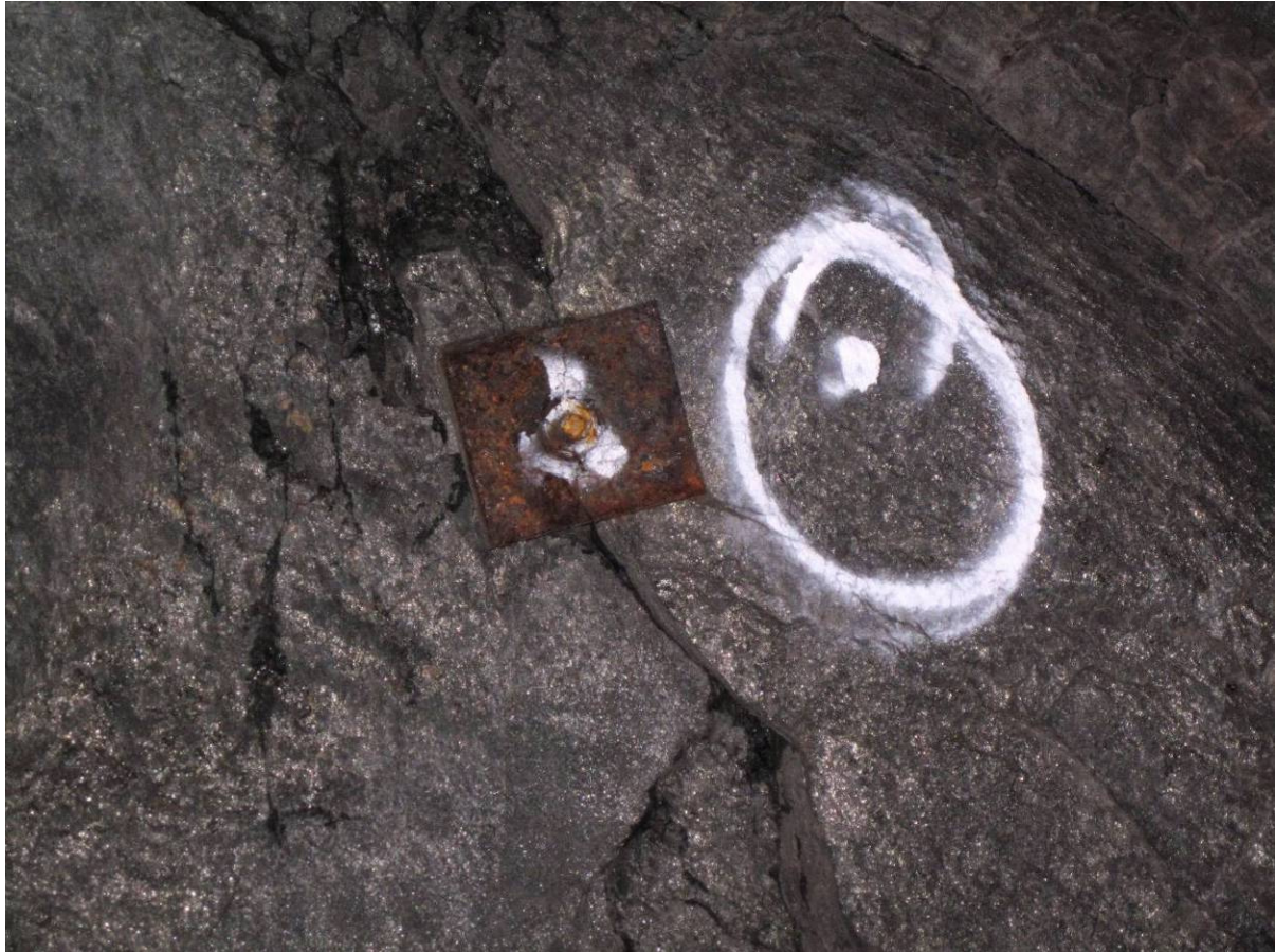
Figur 1.10-13 Gammel boltetype, korrodert svartstål. Vabler på bolteplate
