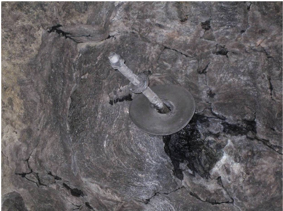
Figur 1.10-12 Fukt fra boltehull, men ingen antydning til misfarging av stålet
