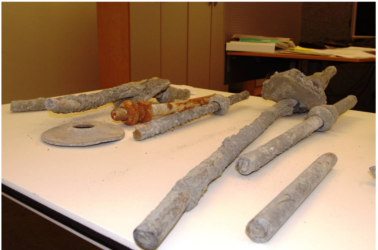
Figur 3.1-5 Frisprenge sikringsbolter fra Kvalsundtunnelen – nisje 1
