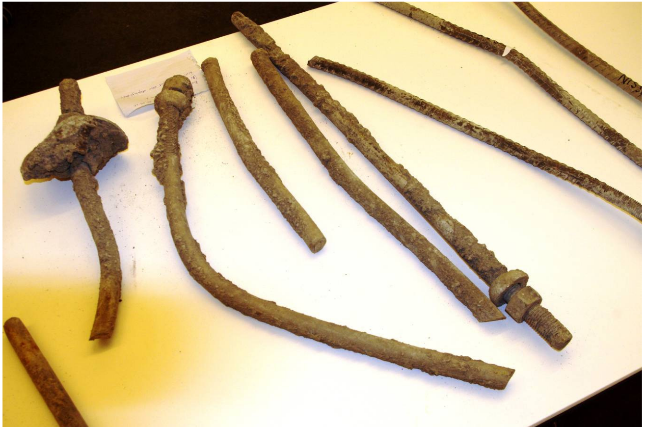
Figur 3.1-4 Frisprenge sikringsbolter fra Kvalsundtunnelen – nisje 1 og 2
