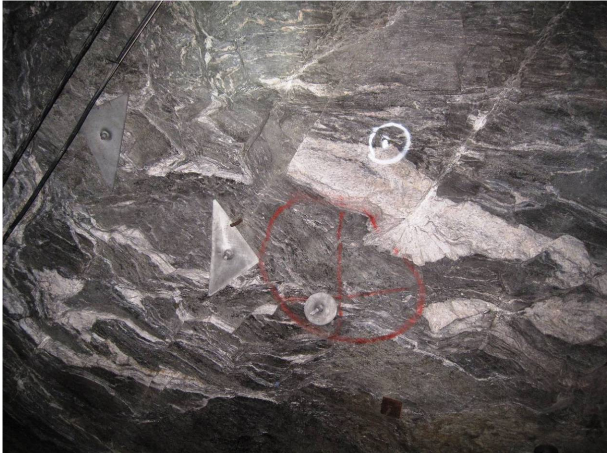
Figur 1.10-17 To gamle bolter med og uten plate sammen med nye bolter
