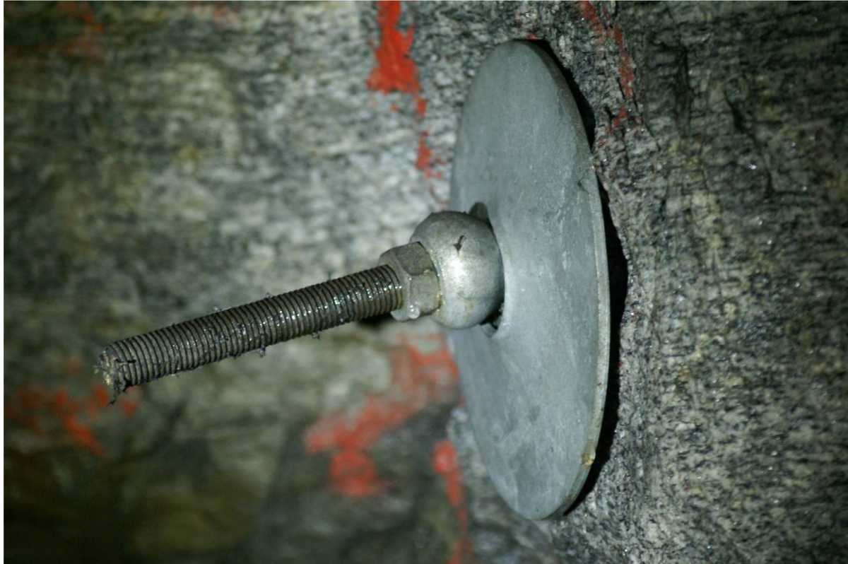
Figur 1.2-3 Bolt uten synlig korrosjon.
