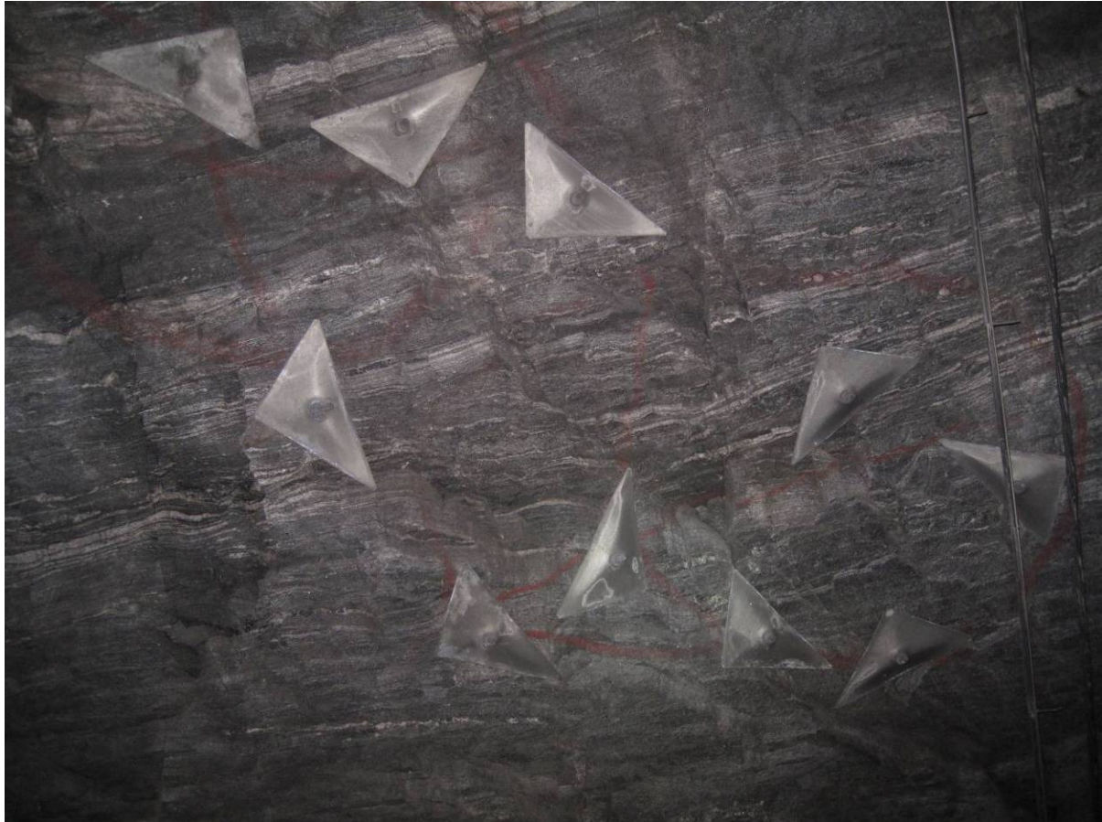
Figur 1.11-9 Tørt. Mye ettersikring
