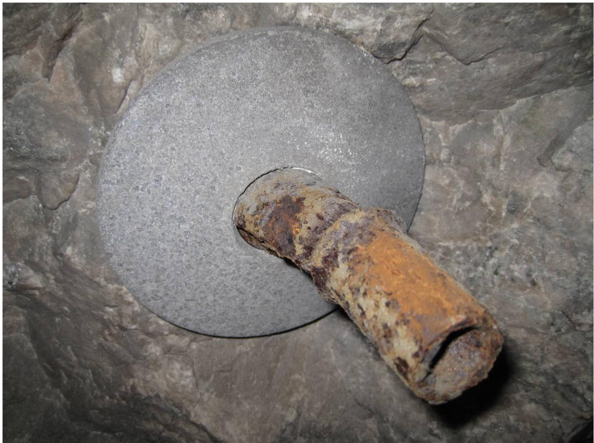
Figur 1.10-4 Swellexbolt 1 etter at løs korrosjon er fjernet med geologhammer
