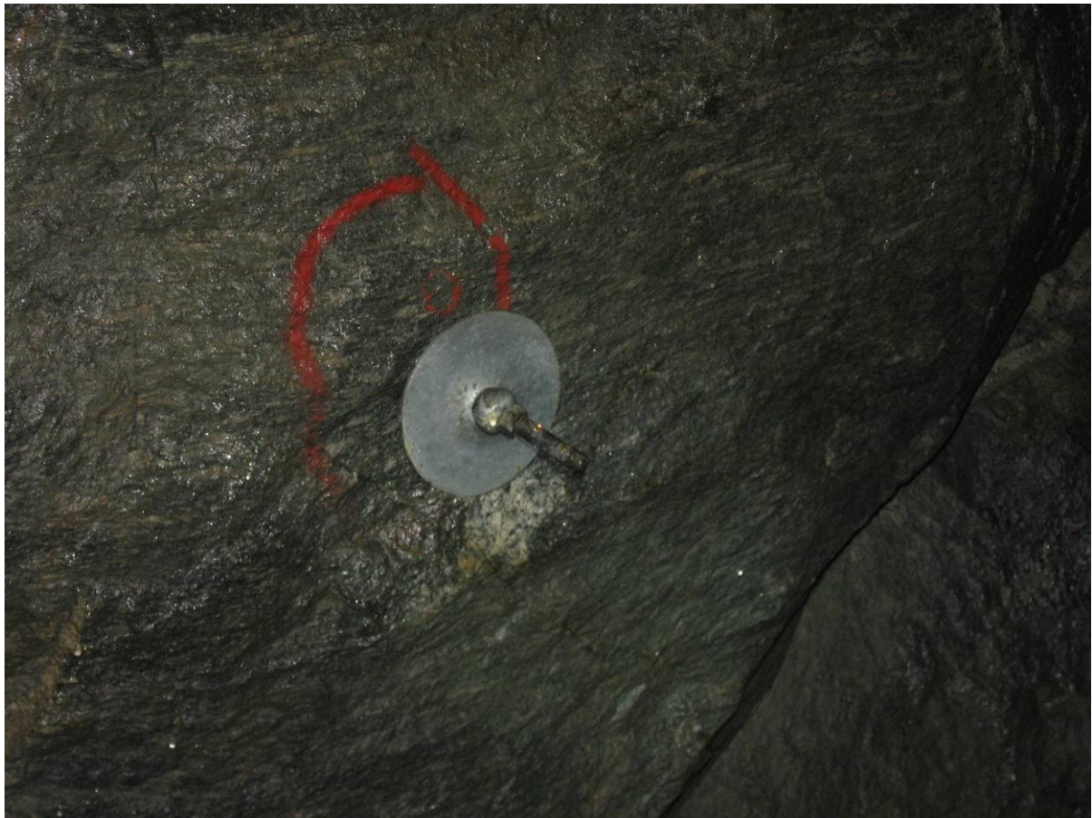
Figur 1.3-1 Endeforankret bolt uten synlig korrosjon. Enkel korrosjonsbeskyttelse
