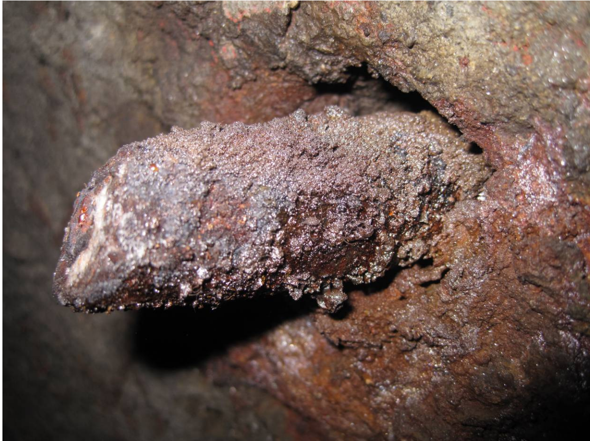
Figur 1.5-11 Bolt 7. Fullt innstøpt bolt uten skive
