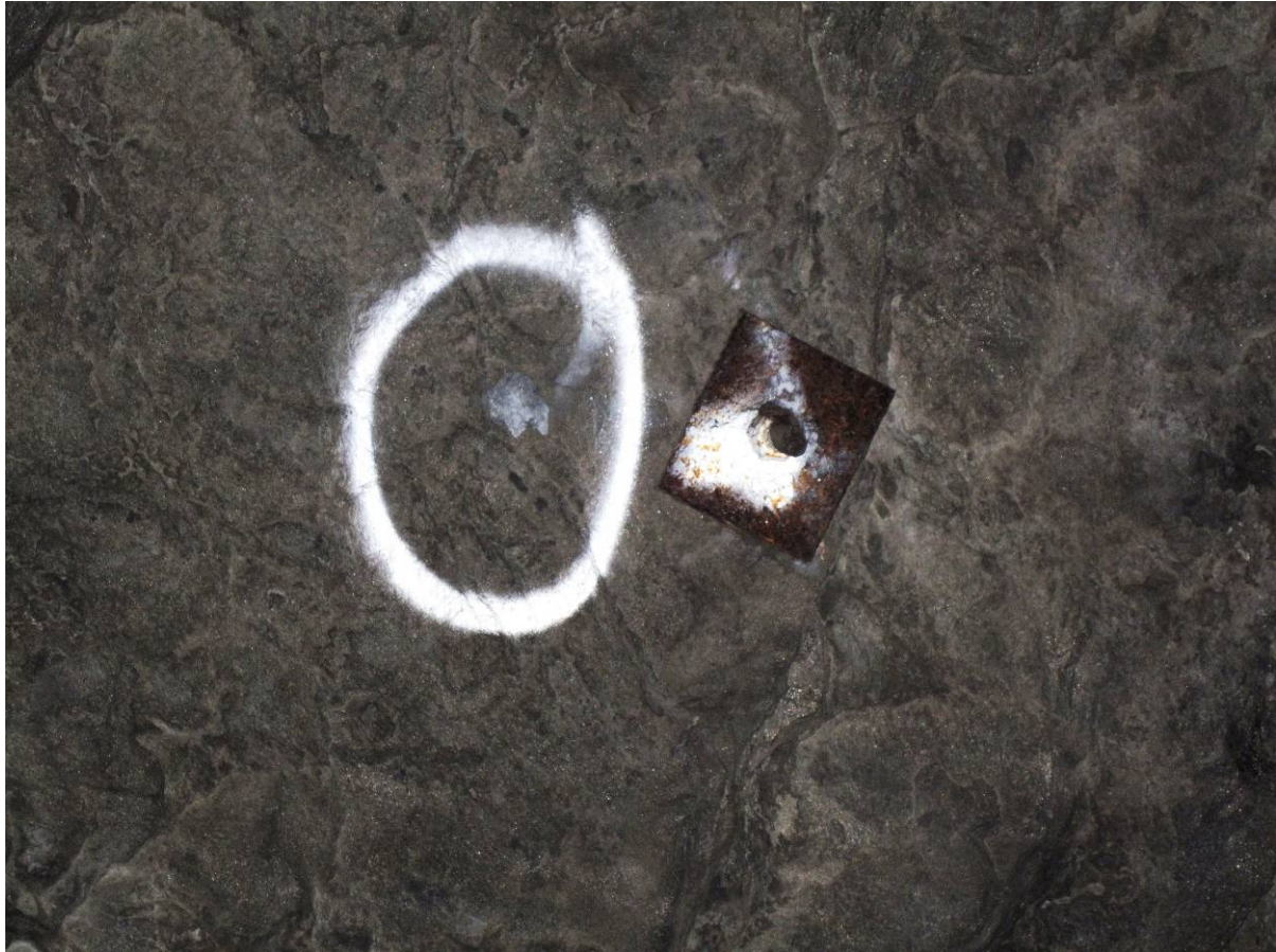
Figur 1.10-11 Gamle bolter \varnothing 16mm med firkantplate, svartstål. Ettersikring i tunnelen har erstattet alle disse
