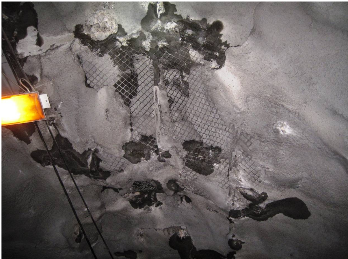
Figur 1.11-6 Tyngre sikring i dårlig, fuktig berg. Ikke noe rust på sikringen
