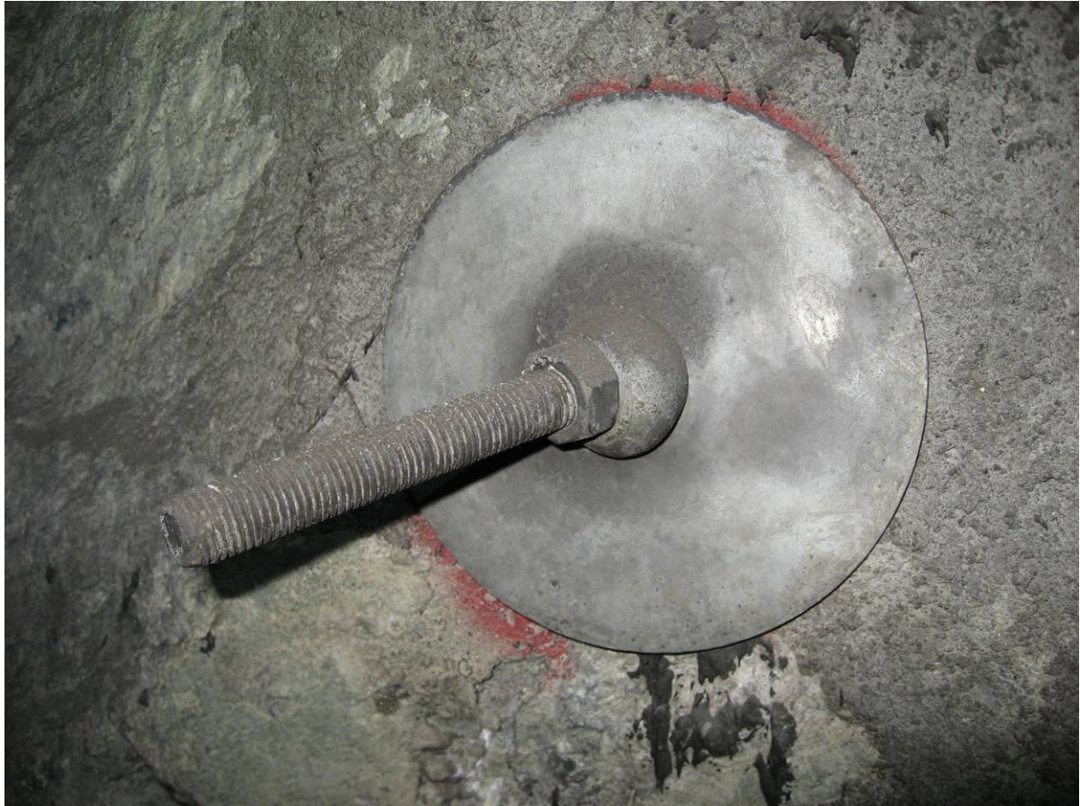
Figur 1.3-3 Innstøpt bolt kun med skitt på. Ingen synlig korrosjon eller misfaring.
