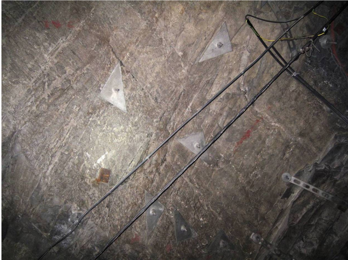
Figur 1.11-3 Gammel og ny sikring. Tørre forhold
