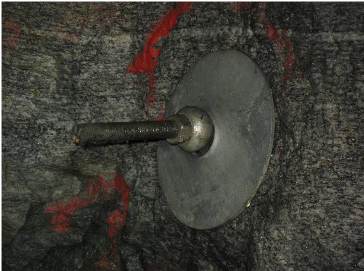
Figur 1.3-2 Endeforankret bolt med kun lett misfarging som kan skyldes skitt og ikke rust.
