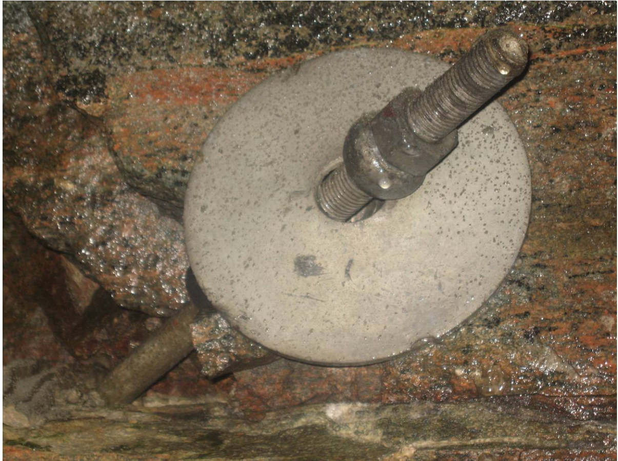
Figur 1.6-9 Bolt i fuktig miljø, men få synlige tegn til korrosjon
