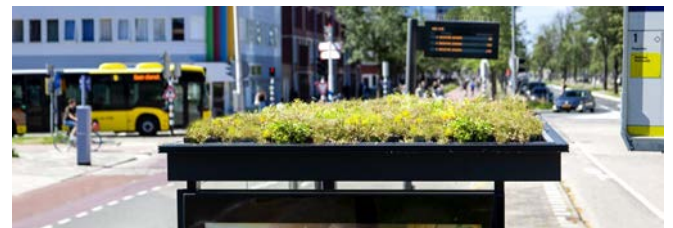
Figur 3.56: Den Nederlandske byen Utrecht har dekket alle sine buskur med grønne tak. Plantene på taket er spesielt valgt ut med tanke på at pollenbærere skal kunne oppholde seg på takene. Foto: Clear Channel
