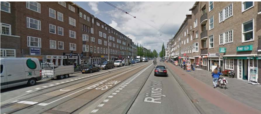
Figur 3.32: Nåværende situasjon. Foto: Google Maps
