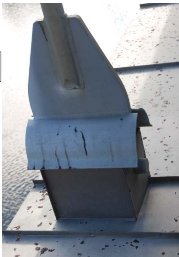
Detalj syrefast beslag klipset på fagverksstav
