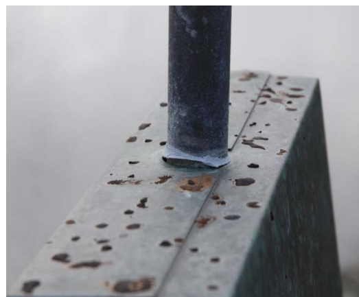
Detalj syrefast beslag klipset på fagverksstav
