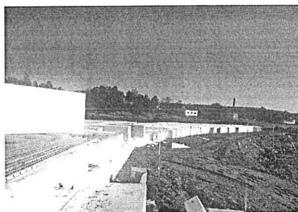
Figur 2. Tilløpsfyllinger av EPS
