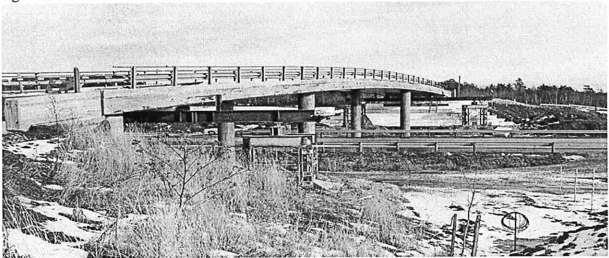
Figur 15 Oppbygging av EPS-fyllinger. Brua bæres av midlertidige understøttelser.
