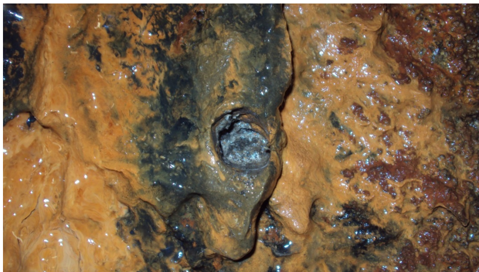
Mikrobiologisk prøvetaking gjennom biofilm og ytre del av sprøytebetong i Oslofjordtunnelen. Foto: Statens vegvesen.
