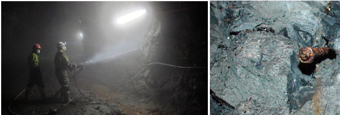
Bildet til venstre viser etablering av testfelt for bolt i Oslofjordtunnelen, mens bildet til høyre viser kamstålbolt med varmforsinking og pulverlakkering i testfelt i Vardøtunnelen, hvor den har stått i 30 år
