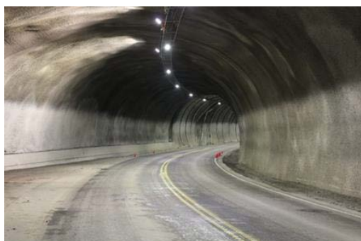
Bildet til venstre viser Presturatunnelen med LED-belysning i indre sone, mens figuren til høyre viser belysningssoner i tunnel (håndbok N500 Vegtunneler)
