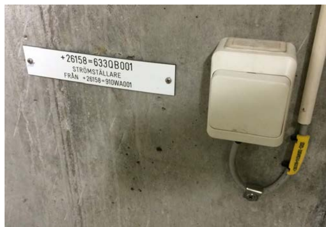
Kabelkulvert (Strindheimtunnelen) og merking av tekniske komponenter (Norra Länken)
