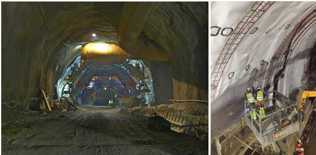
Bildet til venstre viser sikret og avjevnet bergoverflate med sprøytebetong, montering av membran og støp (Foto Reynir Georgson). Bilet til høyre viser montering av armering (gitterdragere) (Havik Hermanstad 2015)
