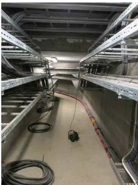
Kabelkulvert (Strindheimtunnelen) og merking av tekniske komponenter (Norra Länken)
