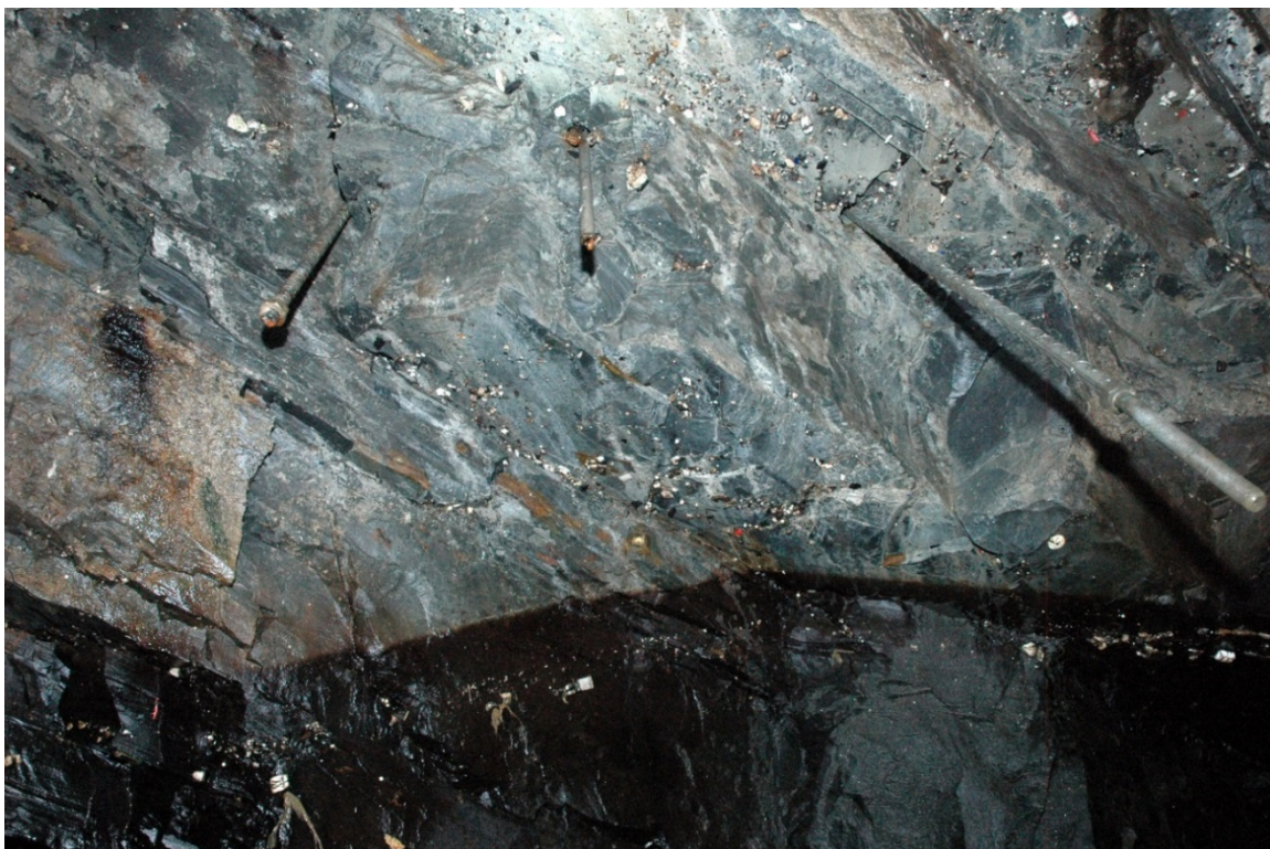
Figur 2 Boltehull nr. 4 med bolt nr. 5 (kamstål), boltehull nr. 5 med bolt nr. 2 (rustfri) og boltehull nr. 6 med «ny» ukjent bolt som ikke tilhører testfeltet.
