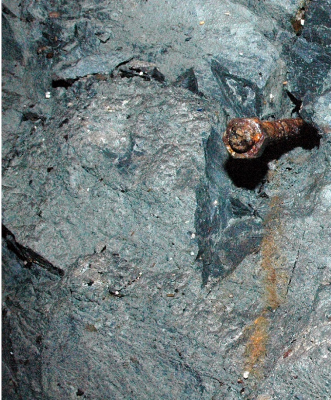
Figur 3 Kamstålbolt, nr. 6 (i boltehull nr. 1)
