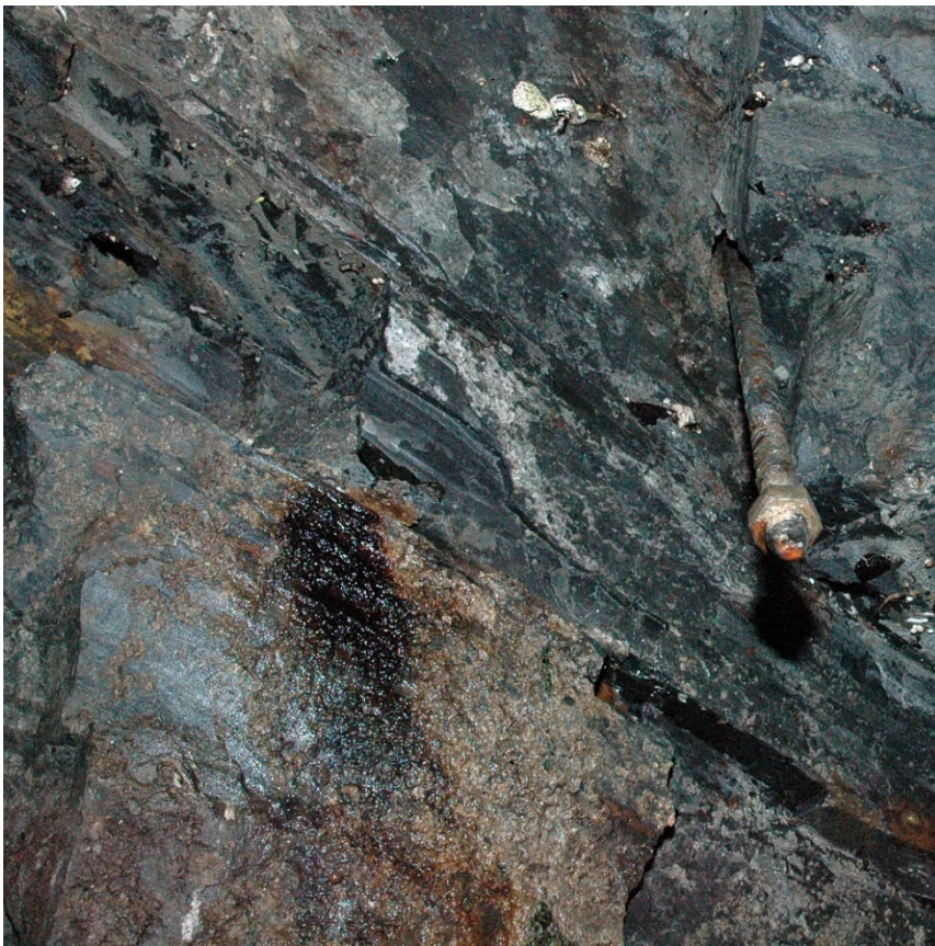
Figur 4 Kamstålbolt, nr. 5 (i boltehull nr. 4)
