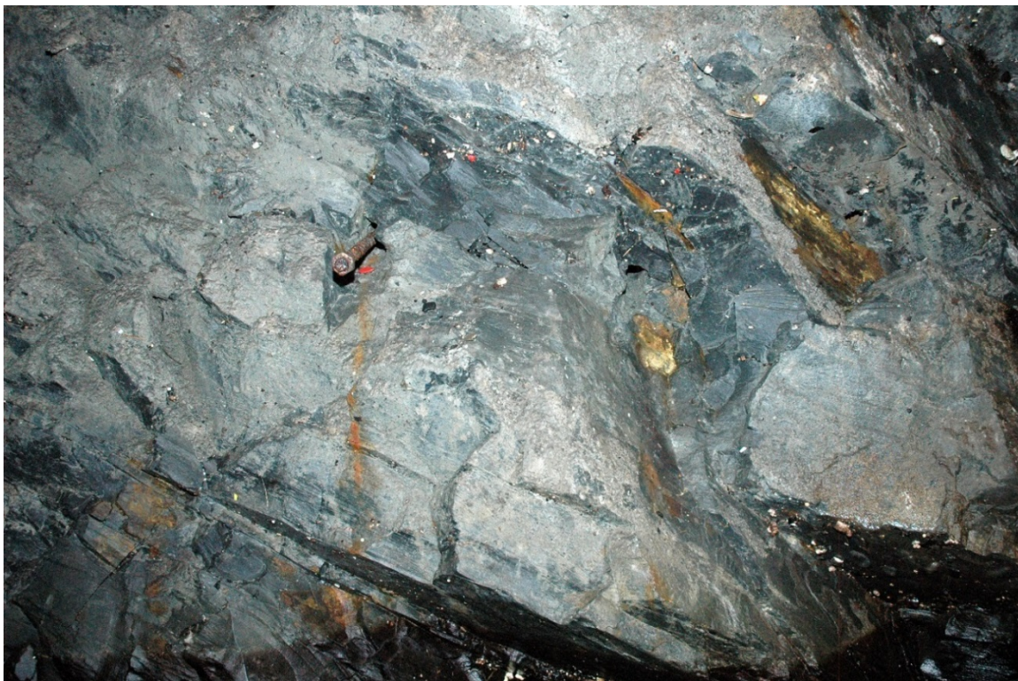
Figur 1 Boltehull nr. 1 (lengst fra inngang pumpebrønn) med bolt nr. 6 (kamstål) og boltehull nr. 2 og 3 som er tomme
