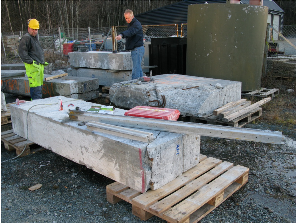
Figur 4 Foto fra tilsaging av armerte prøveelementer ved SINTEF /1/. Midtre del av nordre tårnbein i akse 3 (merket 3M) er nærmest på bildet.
