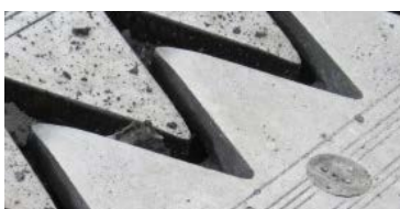
Figur 8 Fylt avstand mellom mutter og fugeelement (foto: Gaute Nordbotten)
