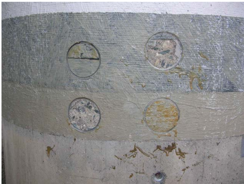
Fig 10 Foto av nedre ende av felt 2.1 etter avtrekksprøving
