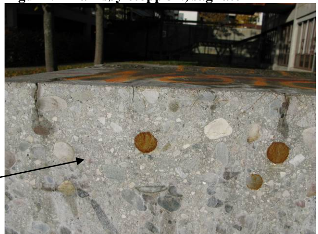
Figur 51 Tårnsøyletopp 3N, sagflate. Riss fra overflata
