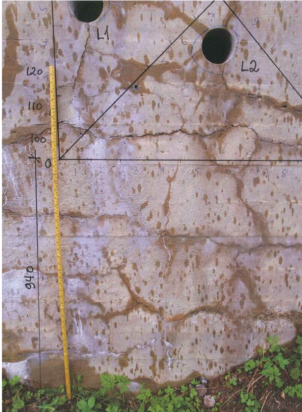
Figur 14 Foto som viser prøvelokaliteter på landkar i akse 1 (nordre vingemur). Avstand fra bakkenivå til origo av referansefelt (ORI) og kjernemerking er angitt. Foto: Audun E. Sanda, Statens vegvesen
