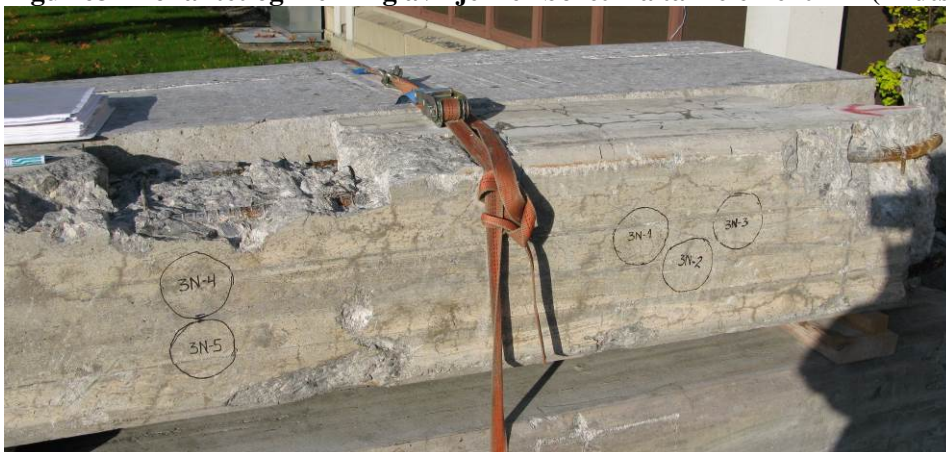
Figur 64 Lokalitet og merking av kjerner boret fra søyle i akse 2, flate mot sør. (Merk at kjernene er feilmerket med akse 3 i stedet for akse 2)
