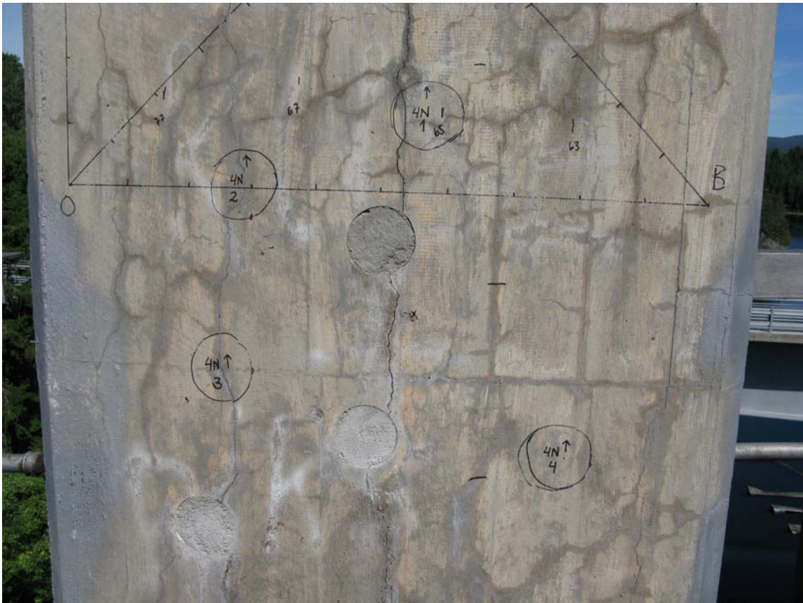
Foto 24 Tårnsøyle 4N, flate mot sør. Merket for utboring av kjerner.
