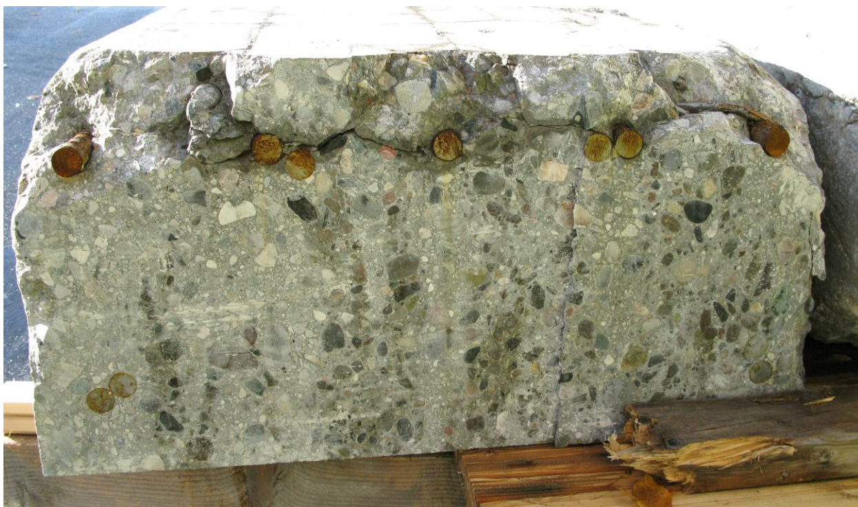
Figur 61 Sideelement fra tårn i akse 4S (mrk 4B), sagflate. Delaminert overdekningsjikt, ellers ikke observert riss i indre deler av elementet.
