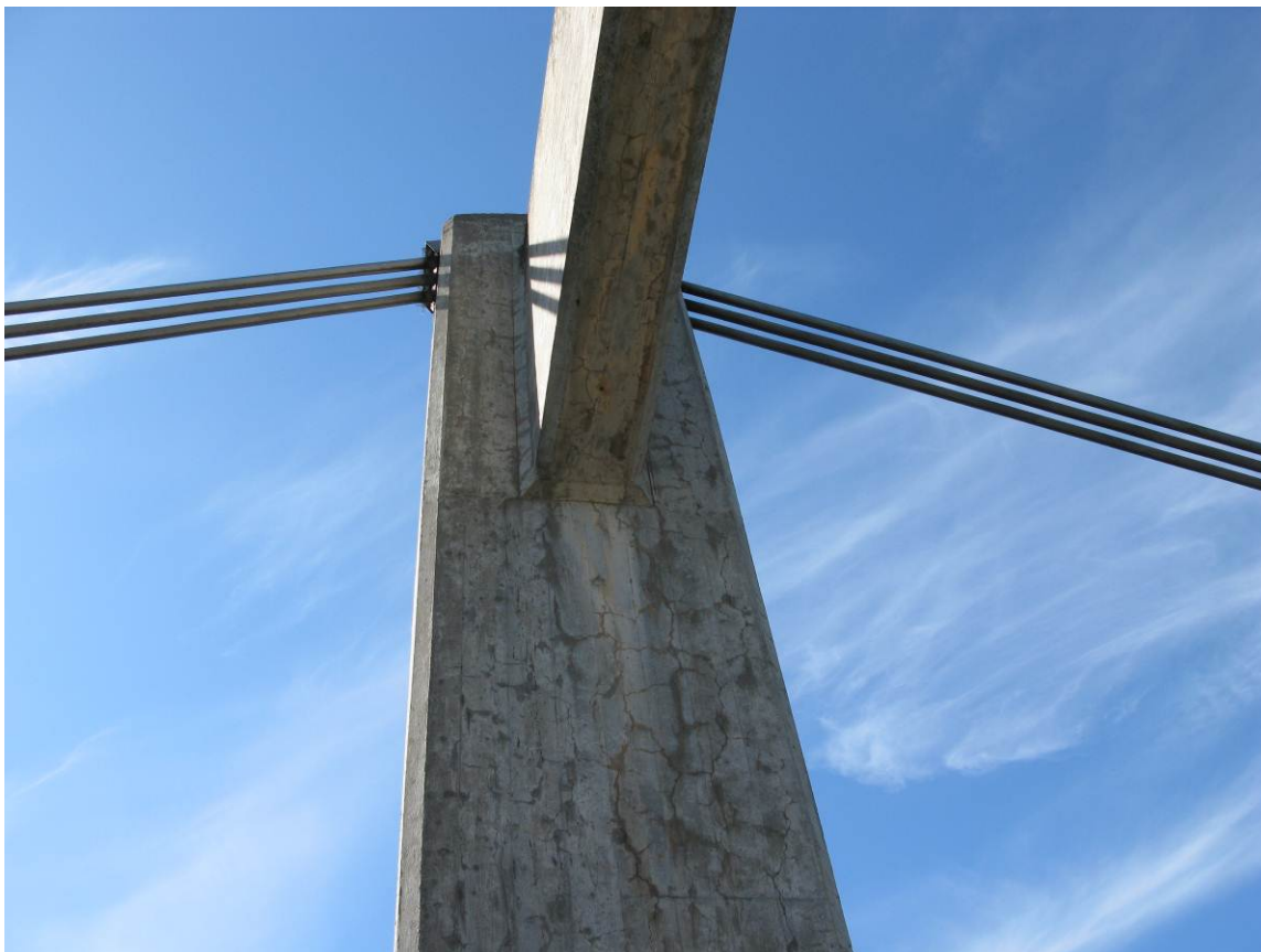
Foto 9 Tårnsøyle 3S. Oversikt mot rigel.
