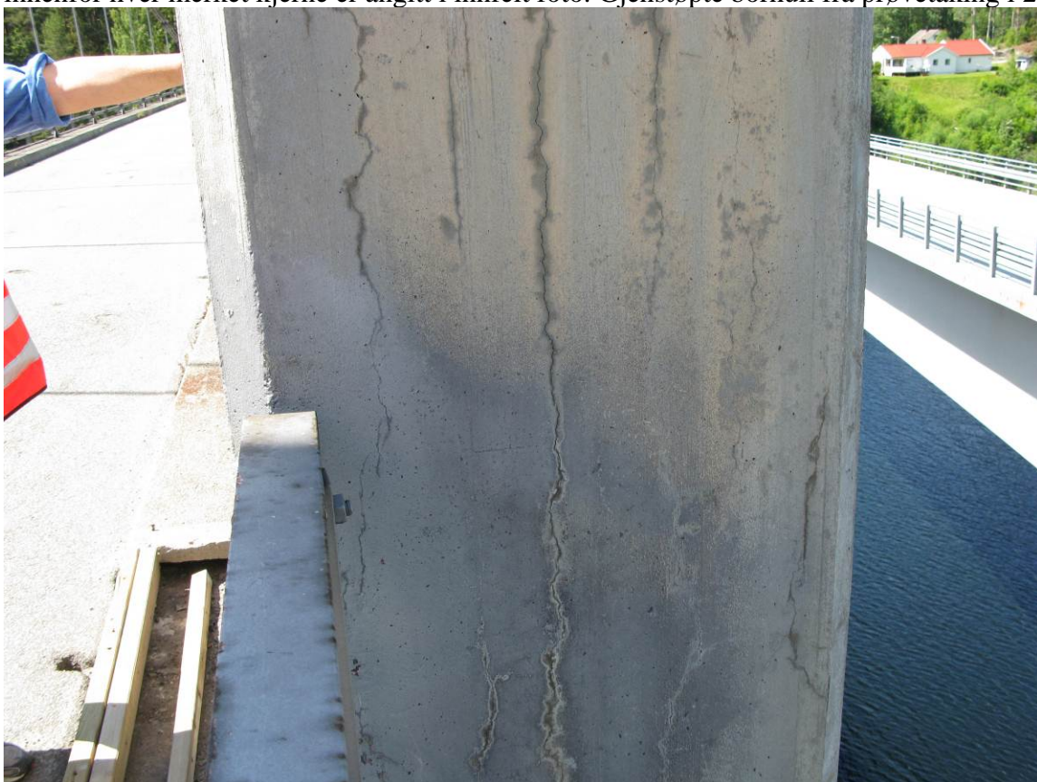
Foto 14 Tårnsøyle 3S, flate mot øst.
