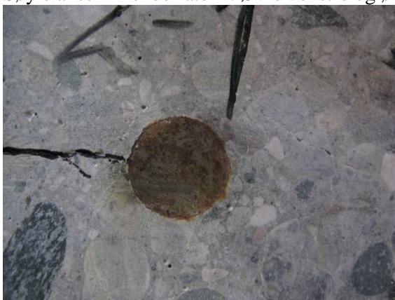
Søyle akse 2 – endeflate B. Øvre venstre og øvre høyre armeringsende
