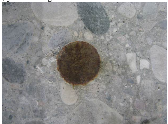
Søyle akse 2 – endeflate B. Øvre venstre og øvre høyre armeringsende
