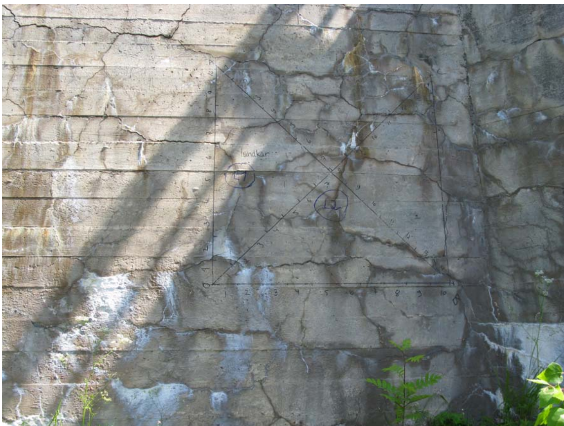
Foto 5 Landkar i akse 1 – nordre vingemur. ORI-felt og merking for utboring av kjerner.
