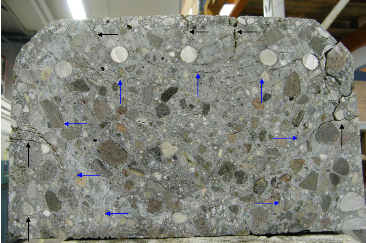
Figur 78 Vertikal skive (mrk 2) fra topp rigel akse 4, b \times h = 400 \times 260 \text{ mm}^2 . Merk riss fra overflata (topp og sider, svarte piler) går ca 40-50 mm inn før de tar overflateparallell retning (blå piler). Mange grove riss rundt og i tilslag, samt gjennom tilslag ut i pasta i hele tverrsnittet. Se også nærbilder i Figur 79 og 80.
