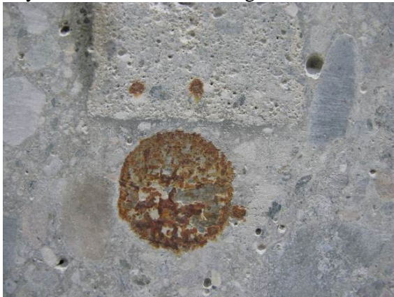
Søyle akse 2 – endeflate A. Øvre venstre og øvre høyre armeringsende
