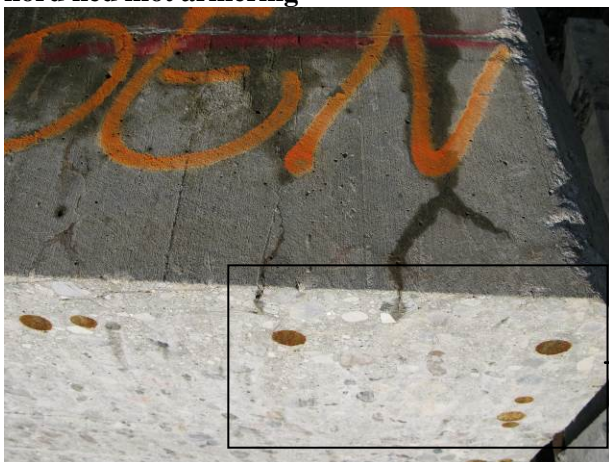
Figur 52 Tårnsøyletopp 3N, riss fra flate mot nord ned mot armering
