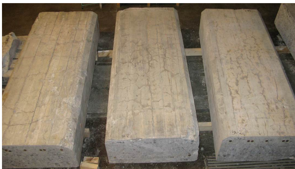
Figur 70 Prøveelement fra søyle i akse 2 (øverst) og prøvestykkene 4B, 4A og 3A (nederst, fra venstre mot høyre)
