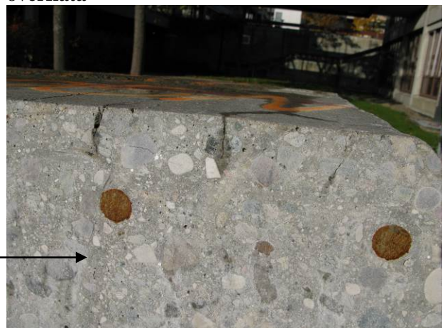
Figur 53 Tårnsøyletopp 3N, sagflate. Riss fra overflata
