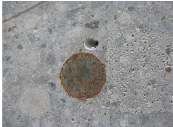
Søyle akse 2 – endeflate A. Øvre venstre og øvre høyre armeringsende
