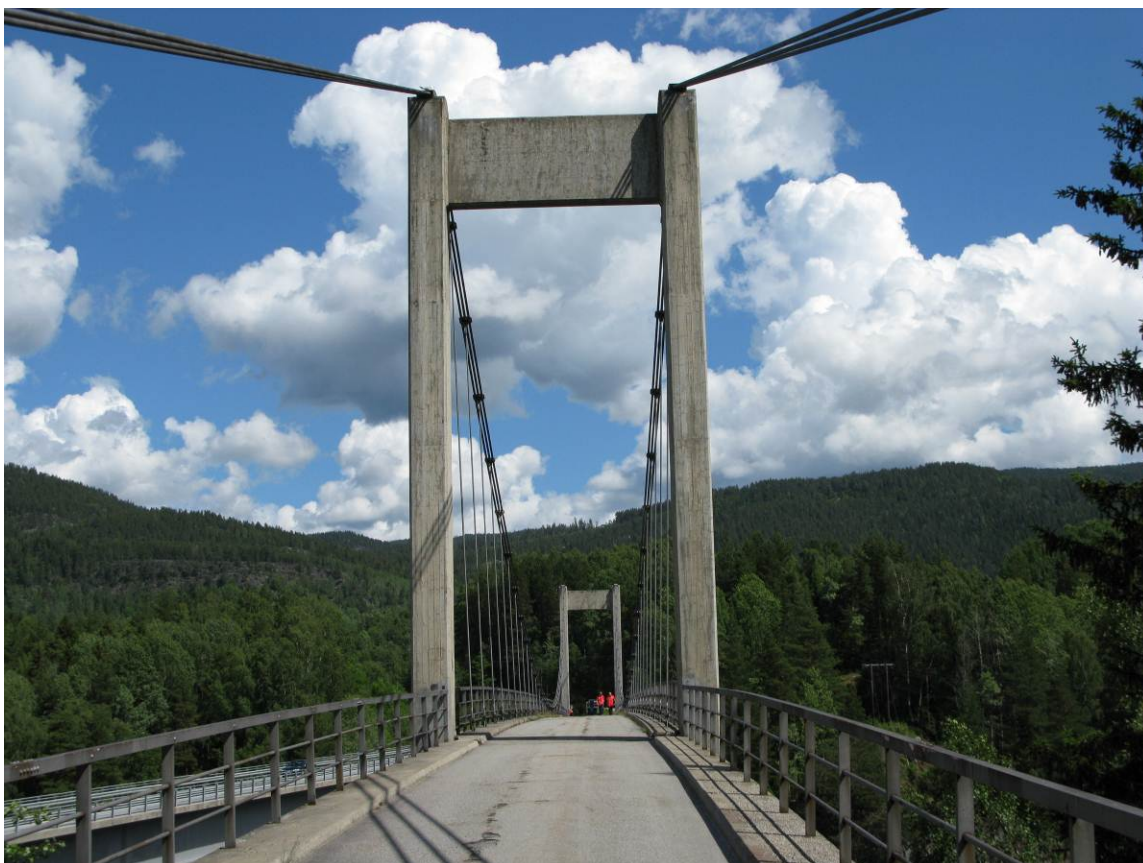
Foto 1 Brua sett fra landkar i akse 6.
