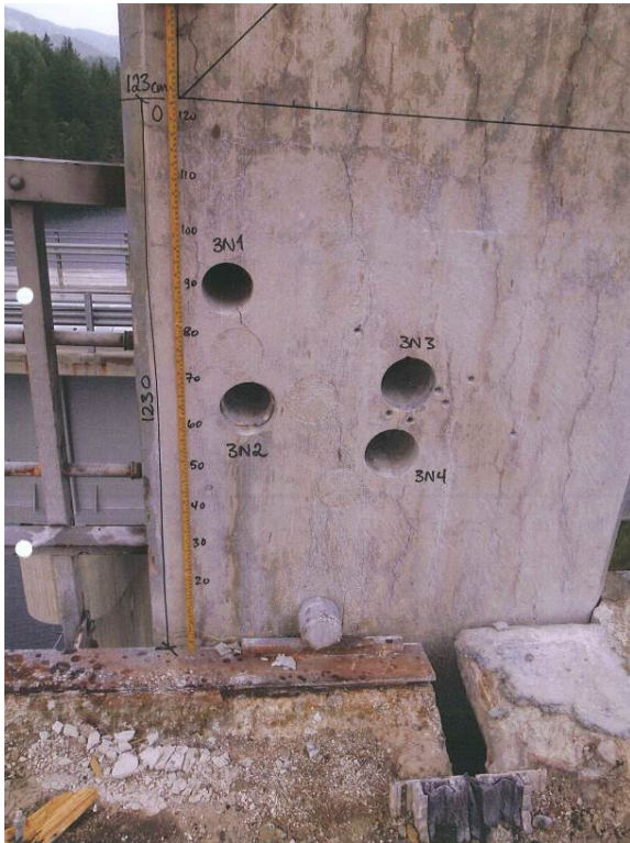
Figur 12 Foto som viser prøvelokaliteter på tårnsøyler i akse 3, nordre søyle til venstre og søndre søyle til høyre. Avstand fra kantbjelke til origo av referansefelt (ORI) og kjernemerking er angitt. Foto: Audun E. Sanda, Statens vegvesen
