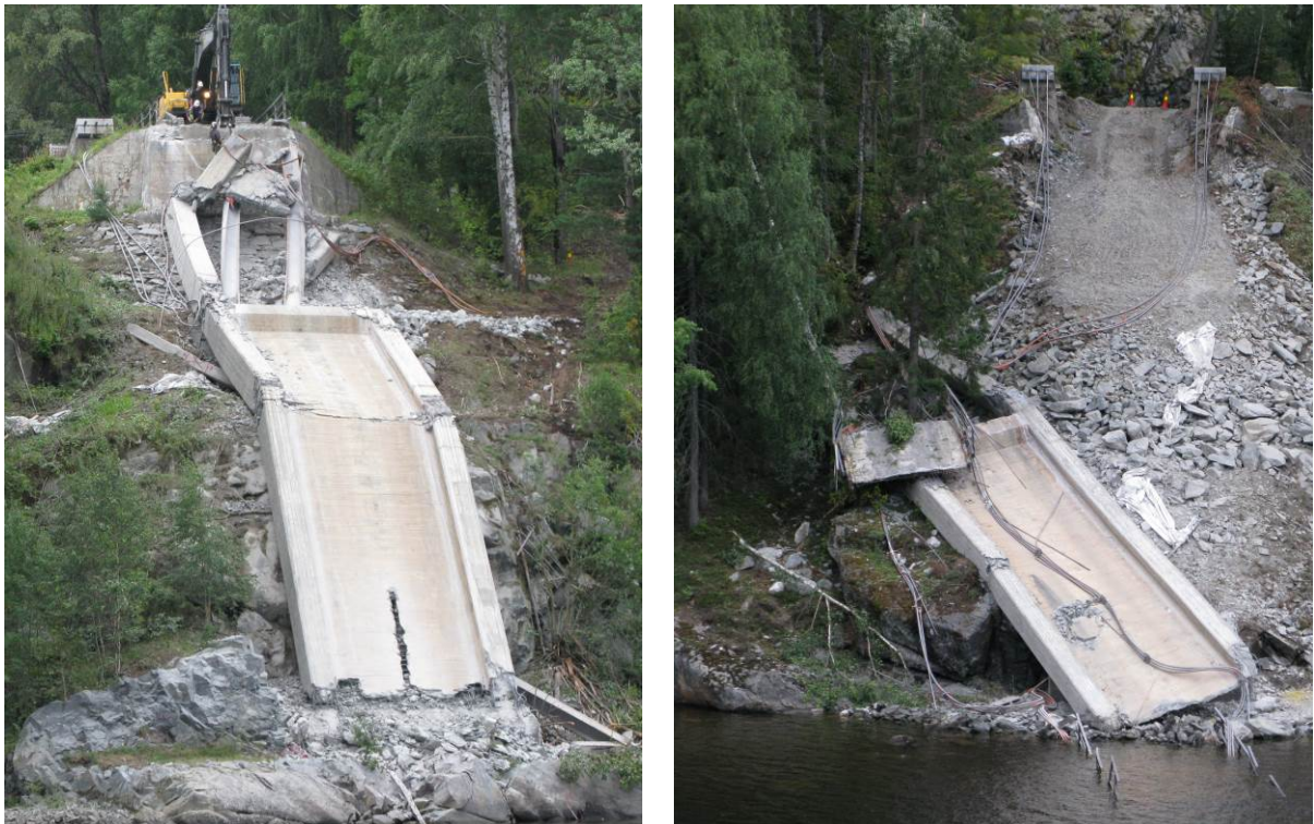
Figur 16 Tårnene etter felling, akse 3 til venstre akse 4 til høyre
