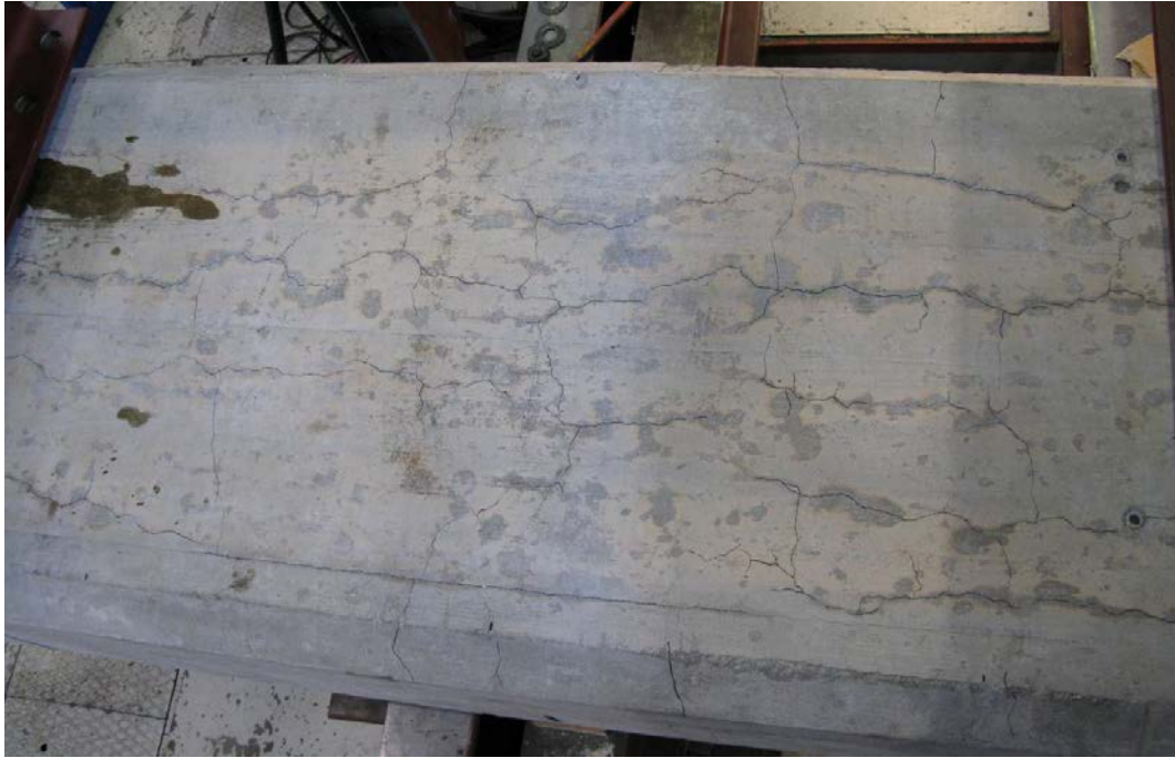
Element 3A – toppflate A-B – montert i rigg før belastning
