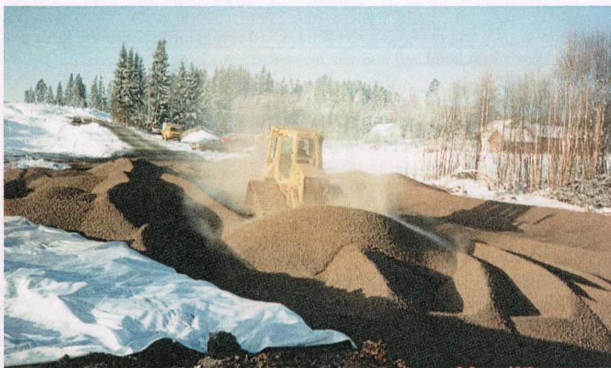
Figur 4.2 Utlegging av lettklinkerfylling (Foto: Norsk Leca)
