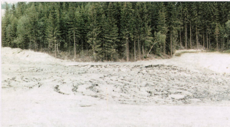
Figur 0.8 Ustabilitet i utfylte masser som følge av tining. (Foto: O.H.Hole, Statens vegvesen, Buskerud)
