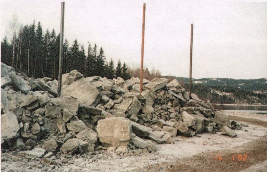
Figur 3.6 Fylling for bruhode med setningsmålere der forbelastning delvis er lagt ut. Setninger måles ved nivellering av topp rør. (Foto: Nils Rygg, Veglaboratoriet)
