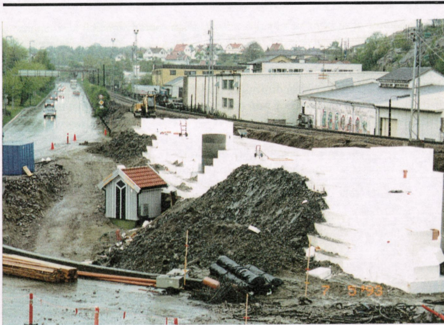
Figur 4.5 EPS-fylling (Foto: K.Brattvang, Statens vegvesen Østfold)
