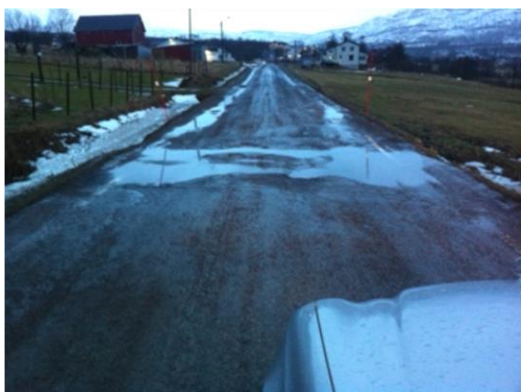
Bilder fra Bukkskinn som viser telehiv, sporete veibane og asfalt som er i delvis oppløsning. Bildene er representative for store deler av strekningen Bondjord - Kårvikhamn
