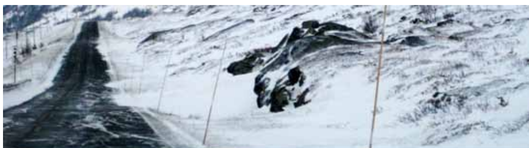
Figur 6-2. Riksveg 52, Hemsedalsfjellet ved km 8,9 som viser fonndannelse bak mindre fjellskjæringer. (Foto Tonje Hellenes)
