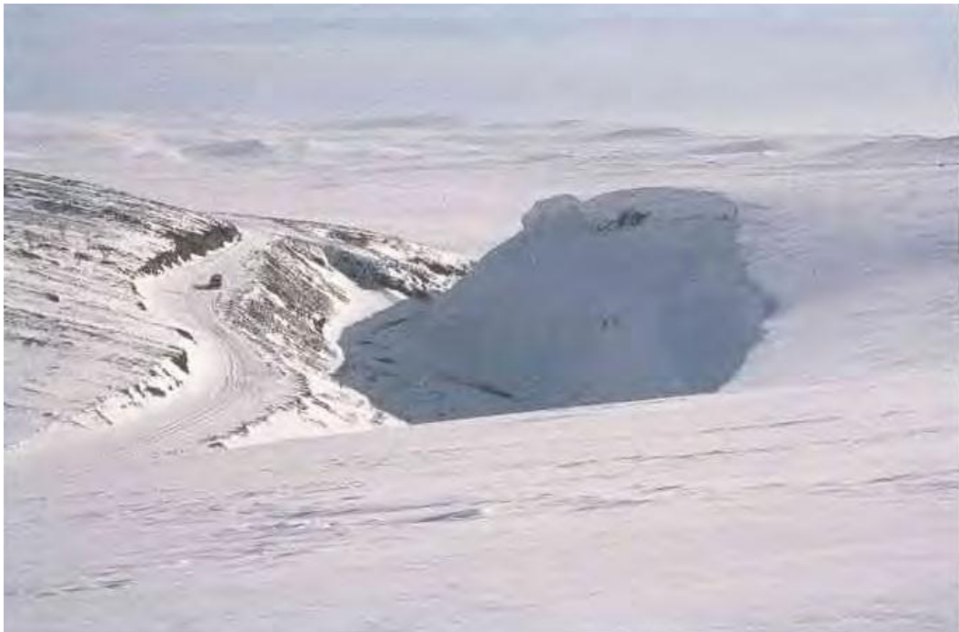
Figur 4-5. Vegen bør plasseres på le side av terrengdetaljer som fører til fonndannelse, men utenfor selve fonnområdet. (Foto: Harald Norem)
