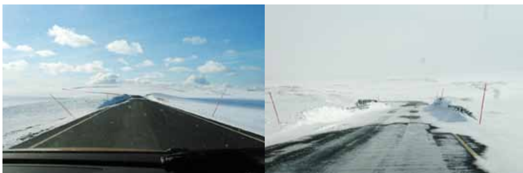
Figur 6-1. Rv. 890 Auster Tana-Gednje hvor vegen krysser Gednjevannet. Mot vannet er det montert rekkverk. På den øvrige strekningen av vegen er det minimalt med behov for brøyting under uvær, mens det på strekningen med rekkverk samler seg betydelige snømengder på vegen. (Foto Yngve Øverli)
