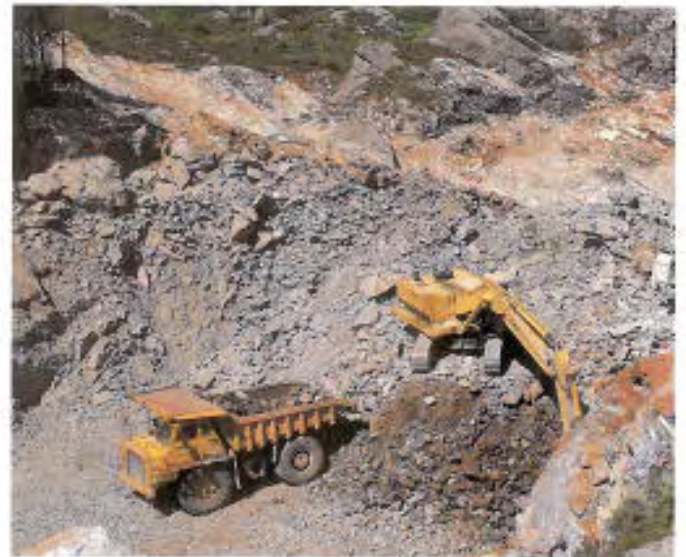
Sprengningsteknikk, Askøybroen, Hordaland. Foto: Erling Grønsdal
