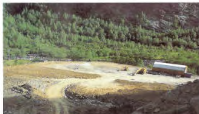
Massedeponi og riggplass, Samnanger, Hordaland. Foto: Arne Matthiessen
