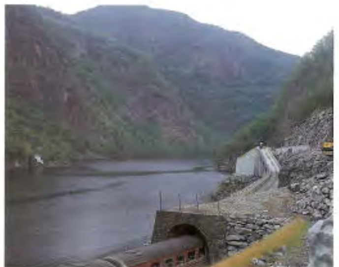
Anleggsveg, Dale i Voss, Hordaland. Foto: Erling Grønsdal
