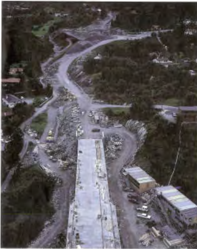
Riggplass, Salhusbrua, Hordaland Foto: Erling Grønsdal
