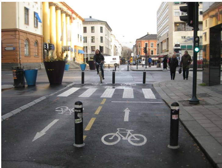
Figur 6.5: Bruk av pullerter for å hindre motorisert trafikk på gang- og sykkelanlegg
