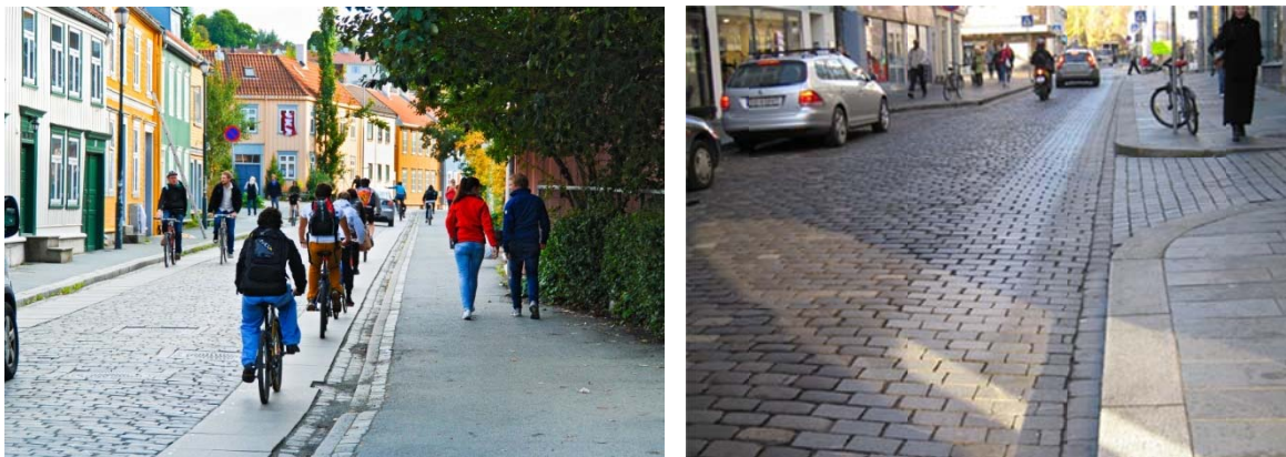
Figur 3.16: Spesiell steinsetting langs sykkelrute med heller eller saget brostein (Bilde til venstre, foto: Knut Opeide, Statens vegvesen)
