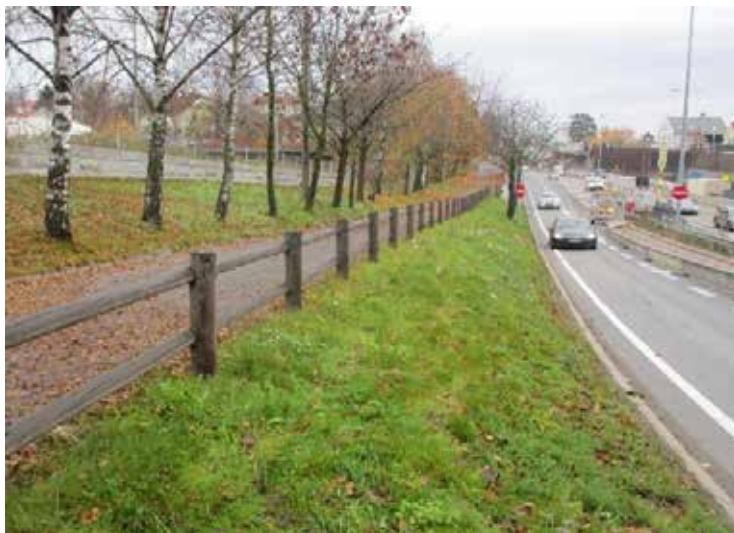
Figur 3.47: Eksempel på G/S-rekkverk i byområde plassert utenfor vegens sikkerhetssone
