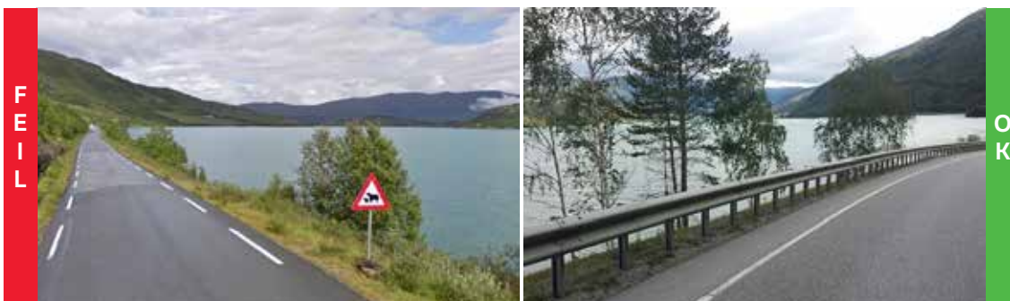
Figur 2.26: Eksempel på veg langs vassdrag uten og med rekkverk. Venstre foto viser bratt skråning/stup ned til dypt vann innenfor sikkerhetssonen
