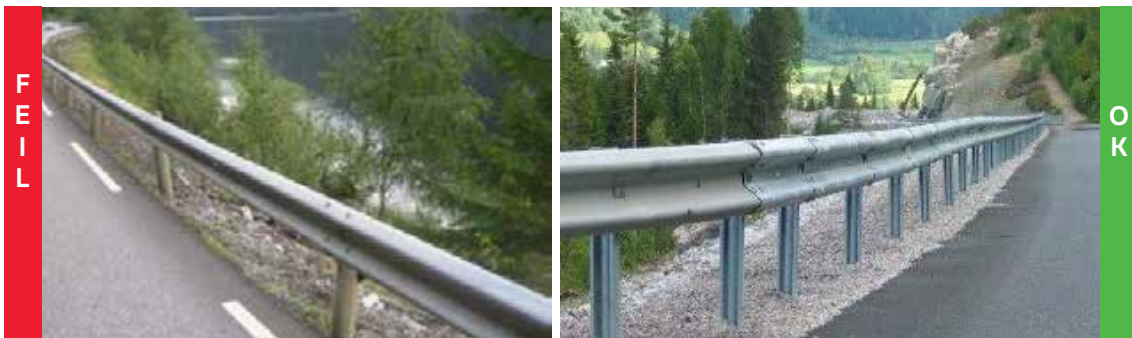
Figur 3.15: Eksempel på feil (venstre) og riktig (høyre) plassering av rekkverk ved skråning mellom 1:3-1:1,5. Rekkverket på venstre foto har mangelfull innfestingsbredde - og utilstrekkelig styrkeklasse.
