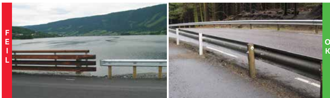
Figur 5.3: Eksempel på endring i rekkverkstype uten og med overgang
