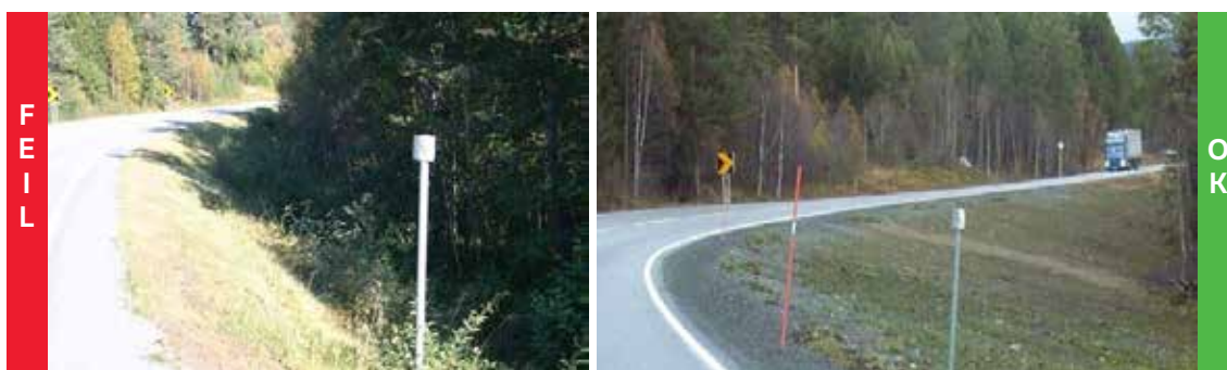
Figur 2.19: Eksempel på vegetasjonsrydding og utslaking av sideterreng
