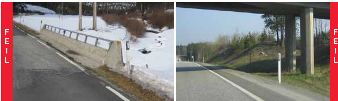
Figur 2.21: Eksempler på påkjørselsfarlige faste sidehindre med rekkverksbehov
