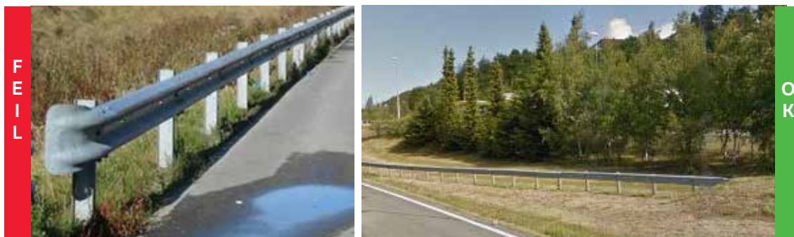
Figur 4.4: Eksempler på ulovlig (fiskehale) og lovlig rekkverksavslutning. Venstre foto: Ved påkjørsel av en slik «fiskehale», er det stor fare for at rekkverket vil trenge inn i bilens karosseri.
