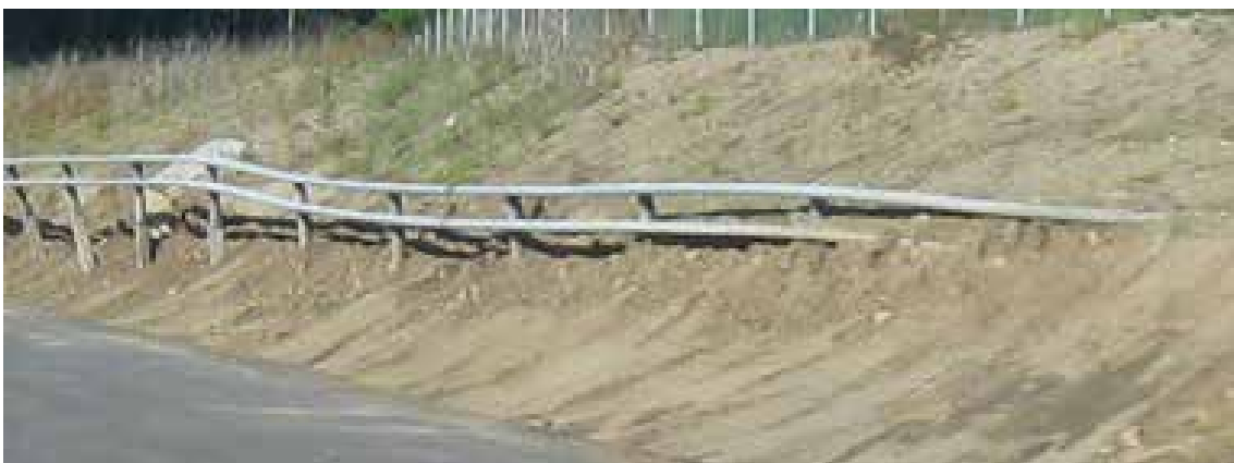
Figur 3.3: Eksempel på dårlig vertikal linjeføring
