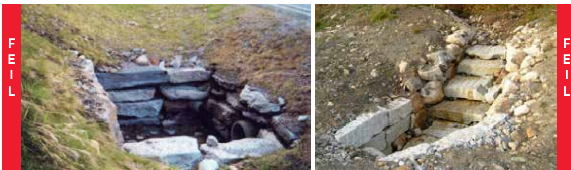
Figur 2.23: Eksempler på påkjørselsfarlige stikkrenneinnløp med rekkverksbehov
