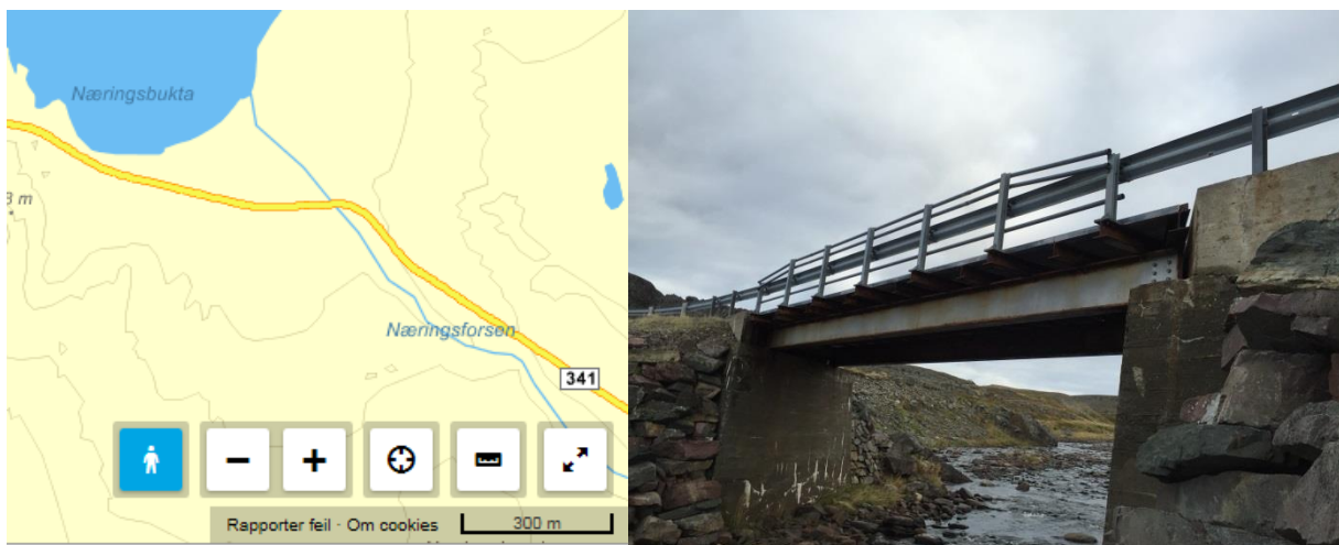
Figur 19. Plassering av Næringselv bru og oversiktsbilde
