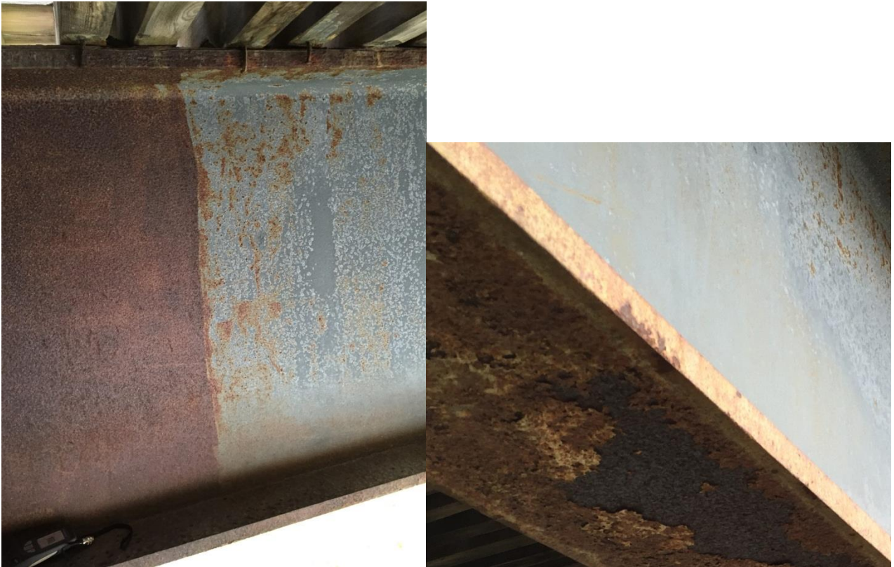
Figur 3. Effekt av filmtykkelse og kant. I det korroderte området i bildet til venstre var filmtykkelsen ca. 90 \mu\text{m} , mens i område uten korrosjon var filmtykkelsen 140 \mu\text{m} (kalibrert på glatt stål). Bildet til høyre viser mindre nedbrytning langs en kant, som indikerer at stripecoating har blitt utført.
