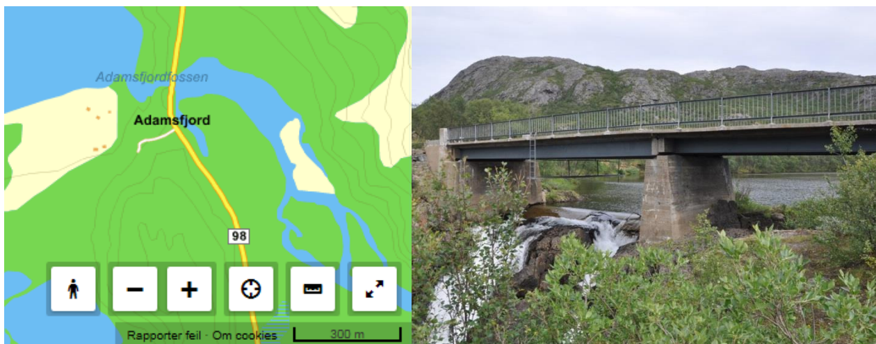
Figur 12. Plassering av Adamsfossen bru og oversiktsbilde
