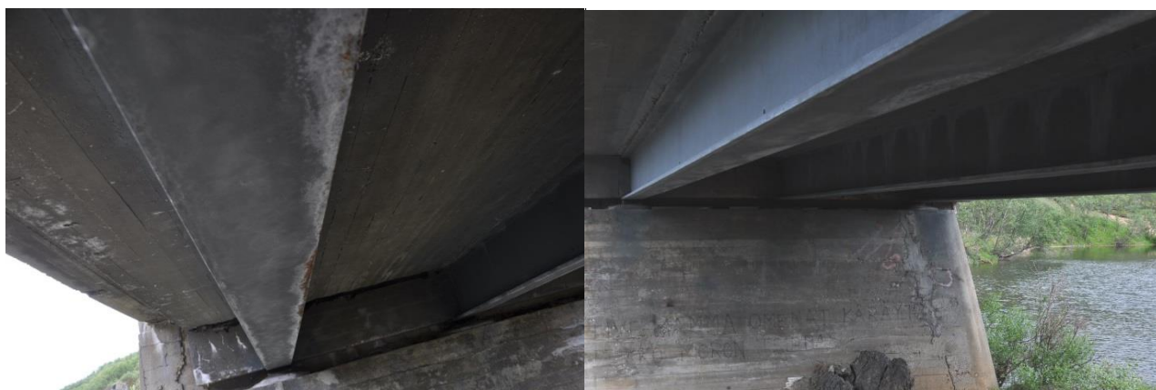
Figur 13. Beleggtilstand på Adamsfossen bru i 2013
