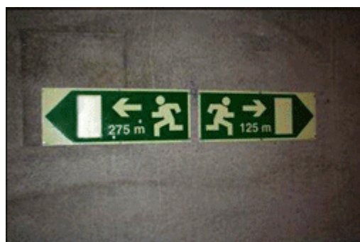
Figur 1. 13: Eksempel på skilt 570.2 i tunnel
