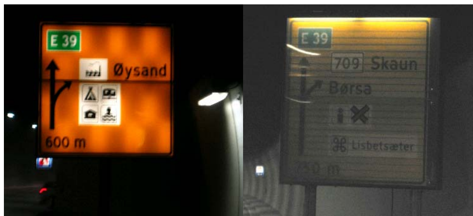
Figur 1. 12: Eksempler på innvendig belyste trafikkskilt med dårlig luminansjevnhet
