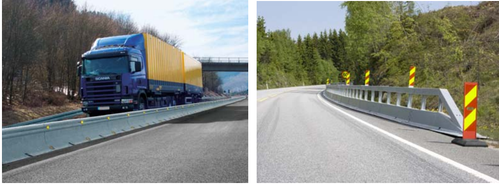
Figur 4. 14: Langsgående sikring (eksempler)
