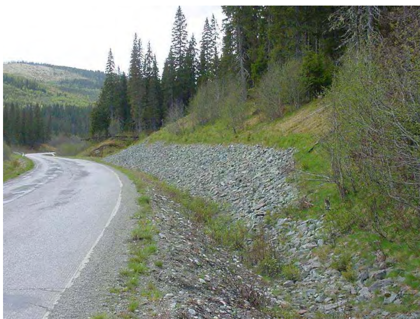
Figur 245.8 Masseutskifting i skråningsfot (Gartland i Nord-Trøndelag. Foto: Kjell Eriksen)
