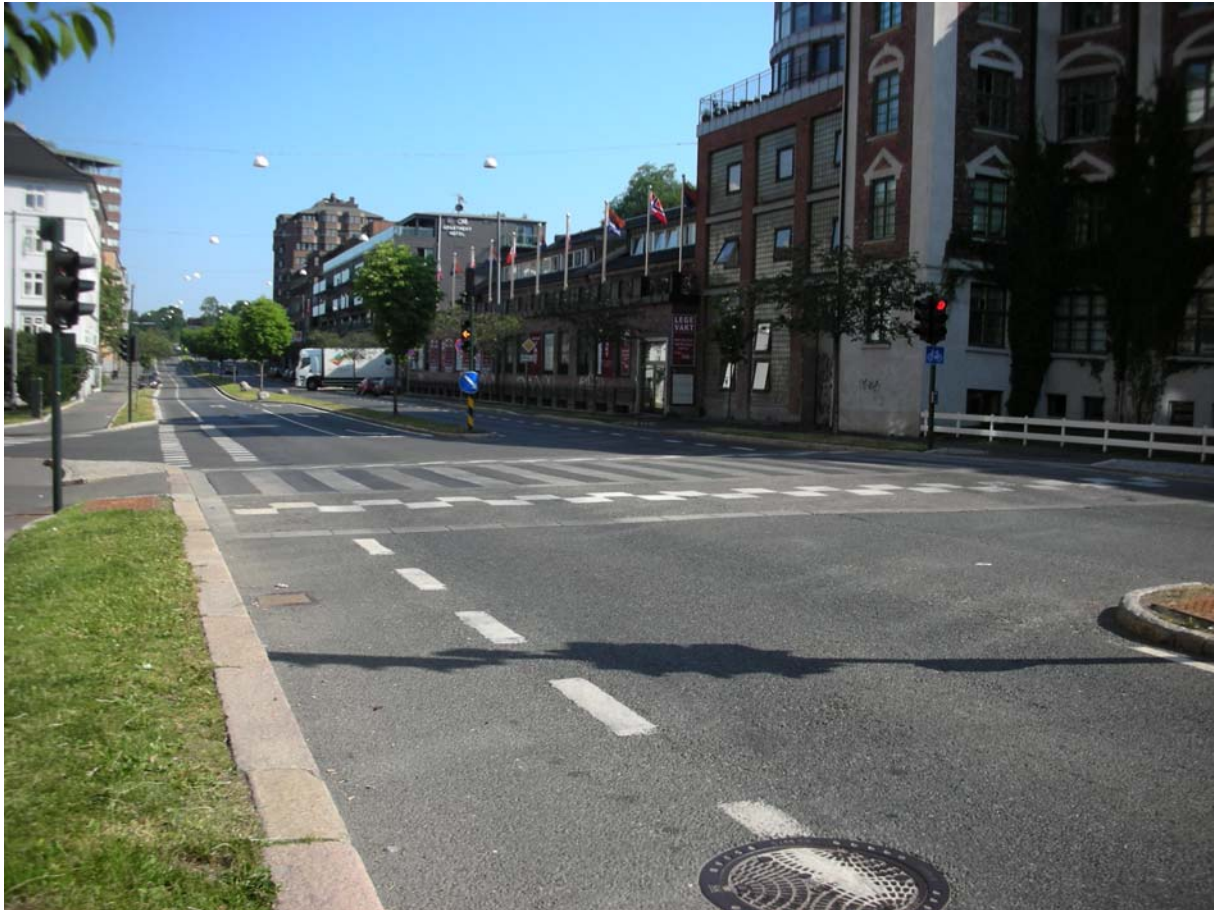
Figur 7.14: Bildet viser det opphøyde gangfeltet midt i krysset og tydelig oppmerket sykkelfelt.
