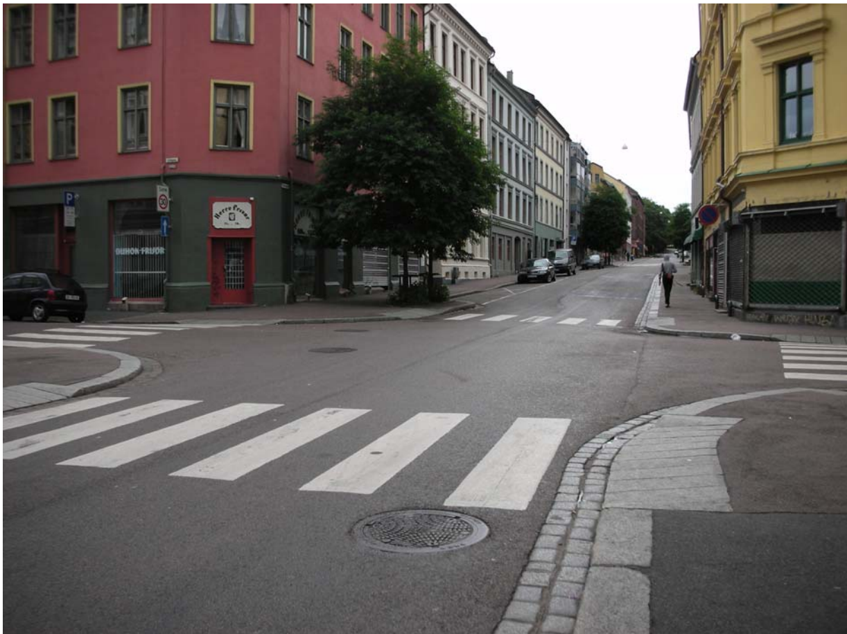
Figur 7.21: Bildet viser hvordan overgangene er trukket vekk fra krysset og det naturlige krysningspunktet. Tydelig markering av overgangene, bruk av nedsenkelementer og smågatestein gir et godt trafiksikkert og estetisk kryss.
