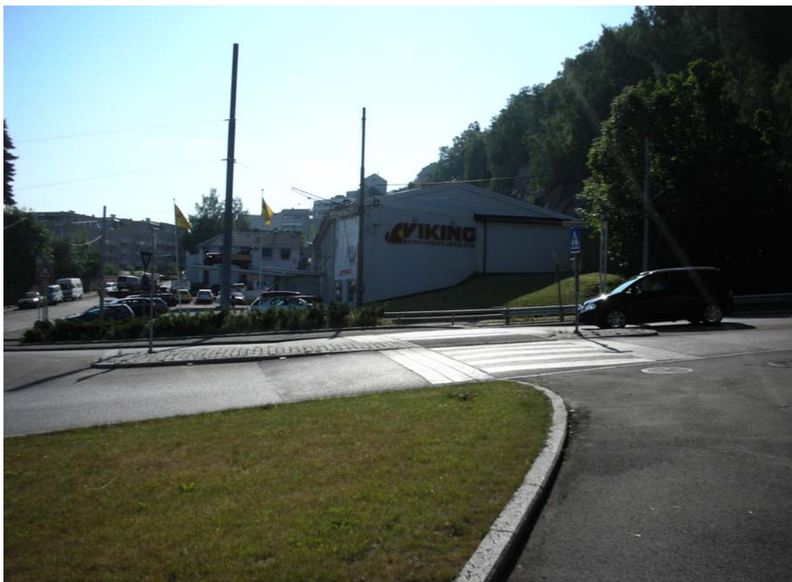
Figur 7.18: Opphøyd gangfelt med refuge i Kongsveien.
