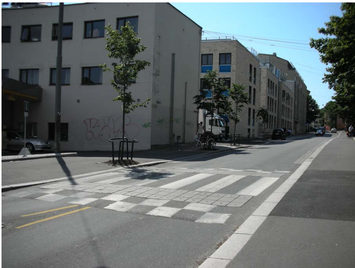
Figur 7.12: Opphøyd gangfelt i Fredensborgveien.
