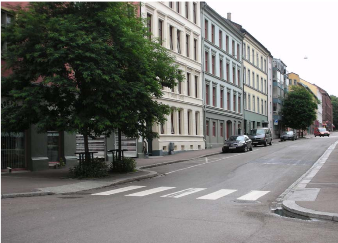
Figur 7.23: Bildet viser nedsenket kantstein ved overgangene.
