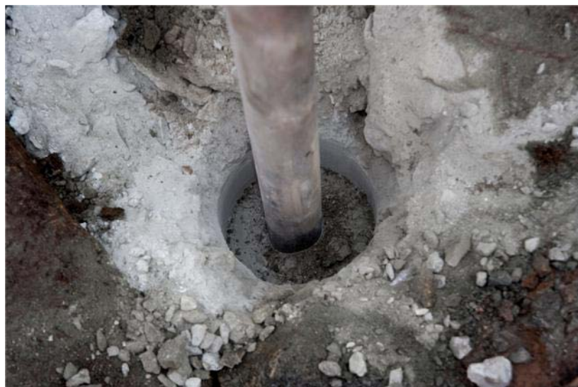
Berget etter at Spiss nr. 1 har vært meislet inn og deretter fjernet.
