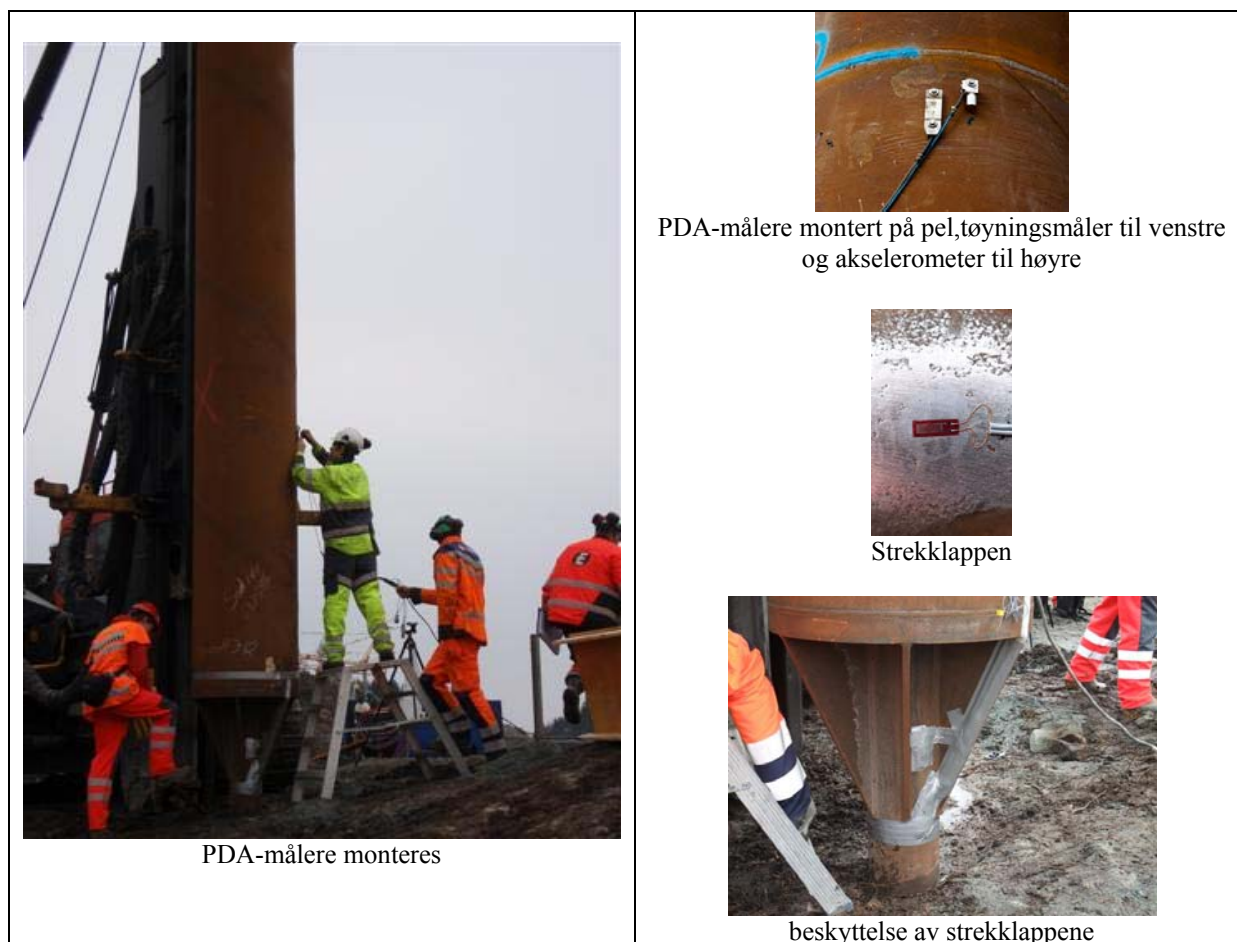
Figur 5-6: Instrumenteringen av pelene.
