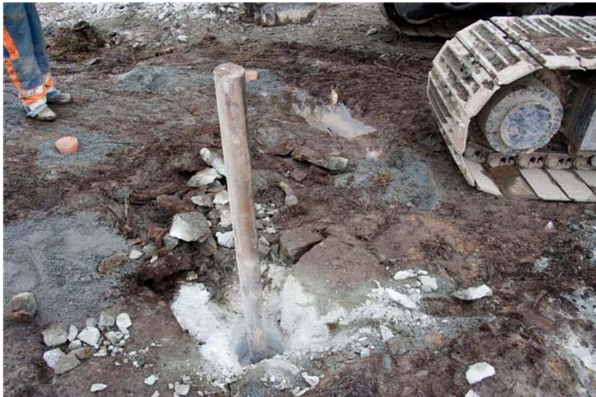
Berget med forboret hull med dybel før Spiss nr. 1 ble rammet.
