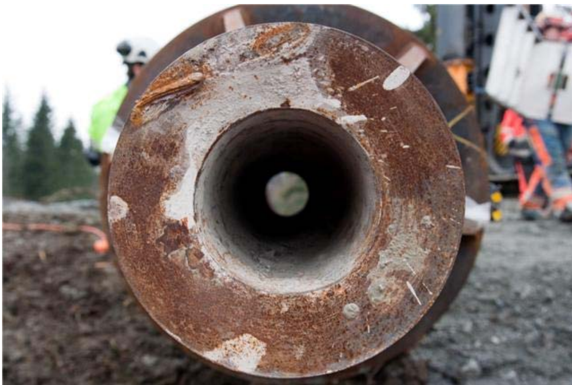
Underkant av spisseemne før spissen ble rammet.
