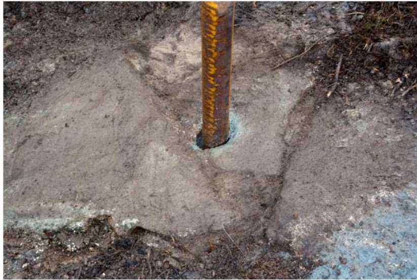
Berget med forboret hull med dybel før Spiss nr. 1 ble rammet.
