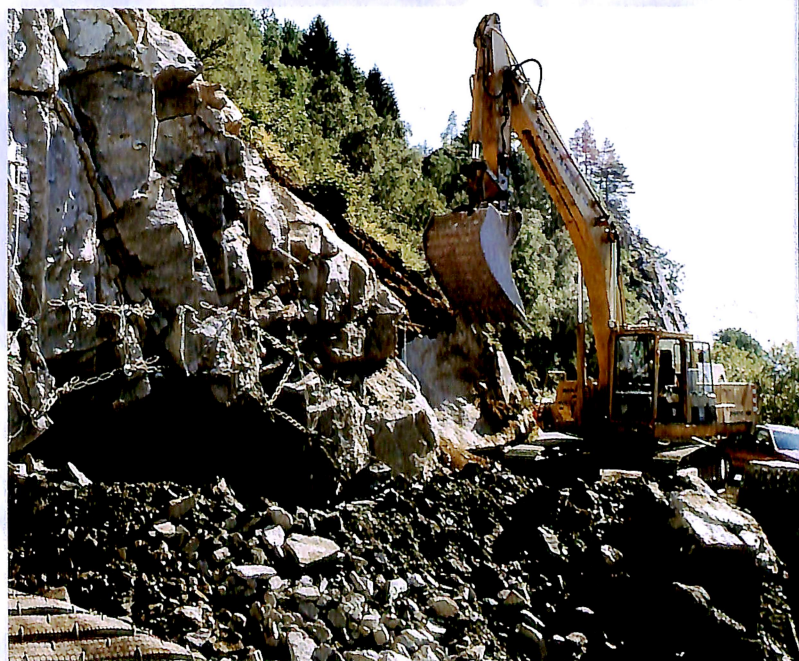
Oppryddingsarbeidet i gong berre minuttar etter smellen og «festen» på røysa.
