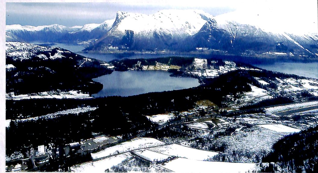
Tunnelen frå Sørestranda kjem ut ved Hovdevatnet, og vegen vil herifrå gå vidare i tunnel gjennom Åsen til kryssområde med noverande E39 ved Furene.
