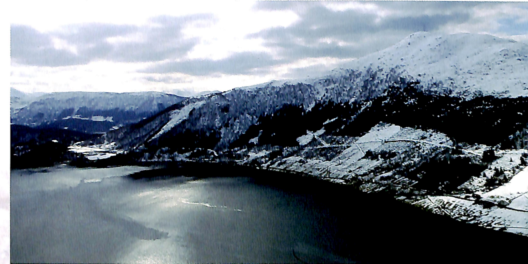
Frå Eiksundet skal vegen gå på ei 250 meter lang fylling fram til ei bru over til Eika. Når sambandet står ferdig, vil ferja verte lagt ned på dagens ferjestrekning Eiksund-Rjånes.
