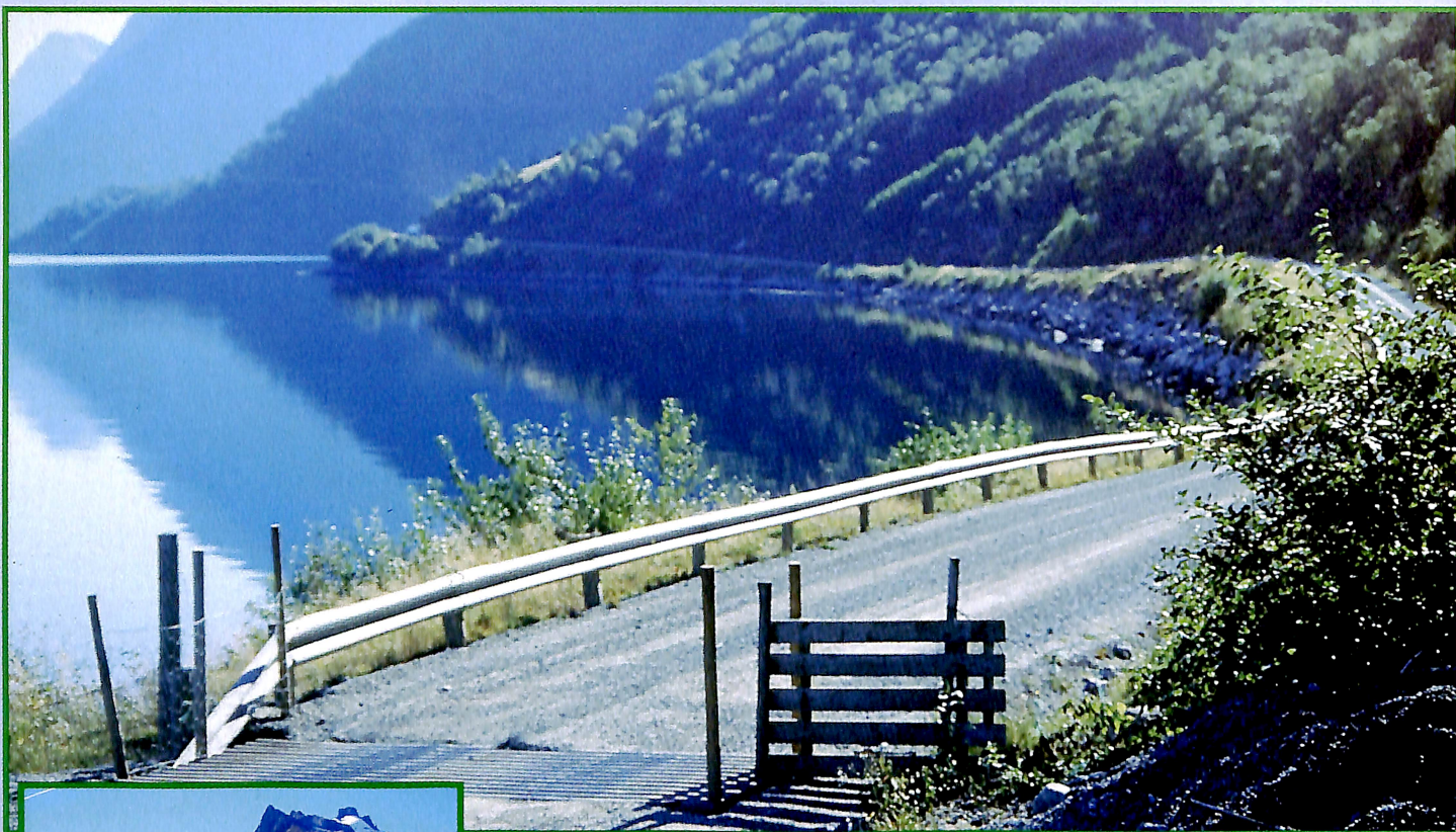
Plantesafta som er påsprøyt grusvegen mellom Festøy og Standal, skal hindre støving og gi ei hardare og tryggare vegbane. (Alle foto: Hild Nordal)
