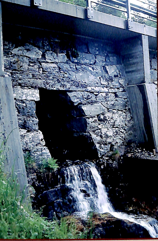
1 Opprinnelig gammel tørrmurt bru hvor Vegvesenet i ettertid har forsterka brua.
